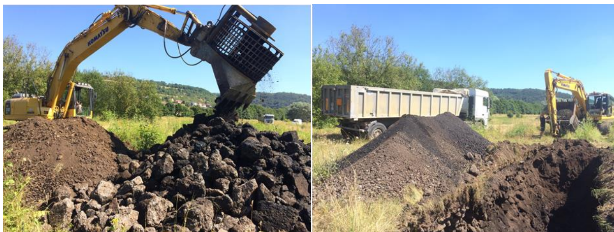
Figure 52 : Prélèvement de la terre CK pour les essais en parcelle lysimétrique
