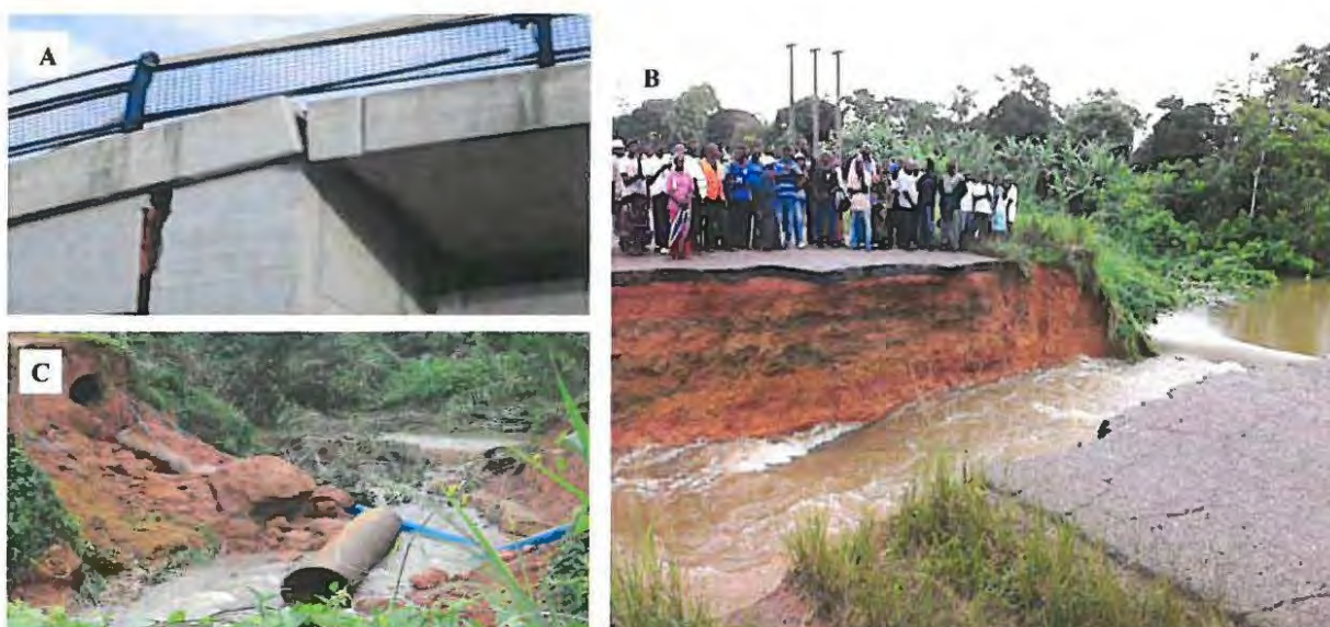
Figure IV.7.1 : Pont du cimetière de Lalala (A), affaissement de la dalle de bitume au village Meyang (B) et la rupture des canalisations au quartier Bangoss (C)
