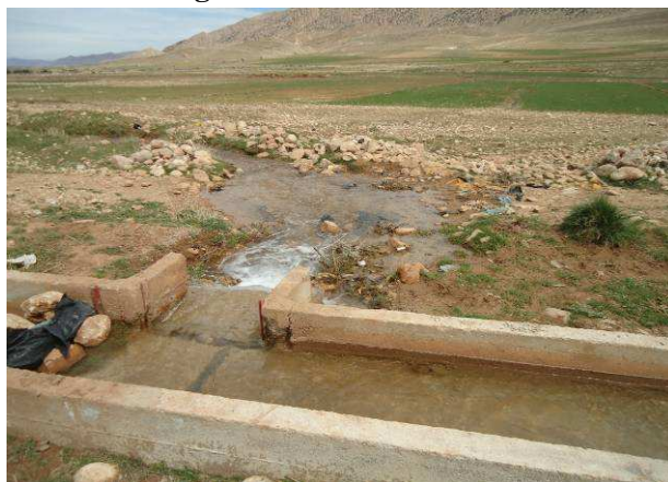
Photo 9.3 : Seguia en béton et en terre.
