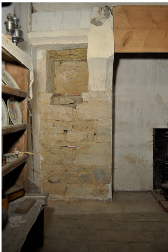
Fig. 276: Maçonnerie sous le corbeau ouest
