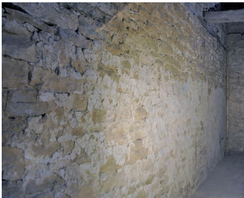
Fig. 255: Mur nord vers l'angle nord-est de la pièce 6a
