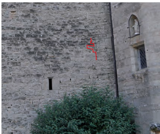
Fig. 301 : Parement extérieur nord
