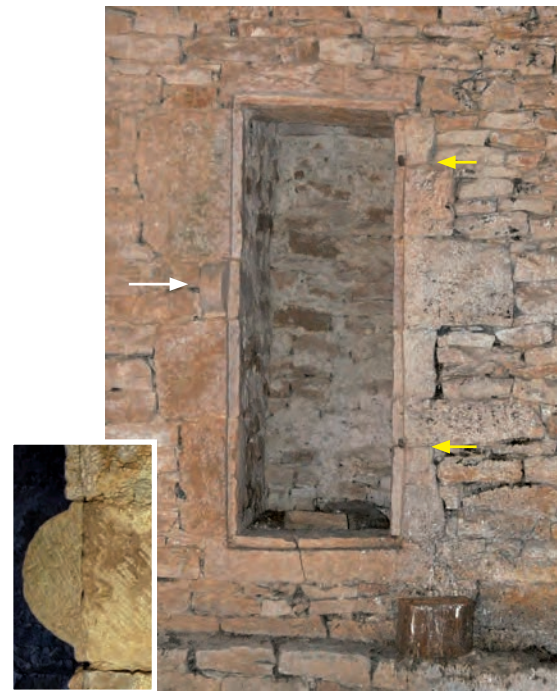
Fig. 371 : Porte d'accès aux latrines (en jaune : gonds ; en blanc, la console de verrouillage)
