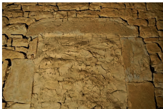
Fig. 308 : Détail des piédroits et du comblement
