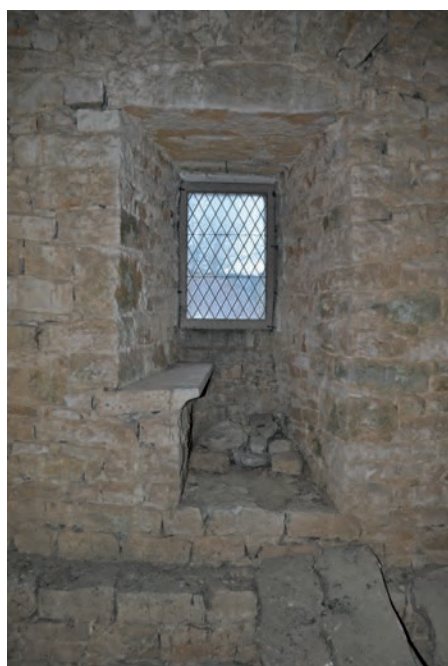
Fig. 369: Vue d'ensemble de la fenêtre orientale
