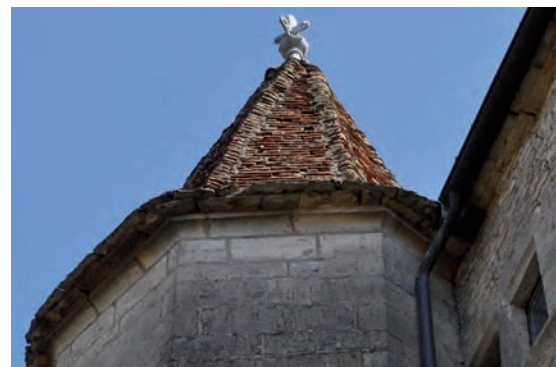
Fig. 496: Détail de la toiture de la tourelle d'escalier
