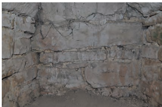
Fig. 395: Détail du parement intérieur de l'allège (UM3-5-UC4)
