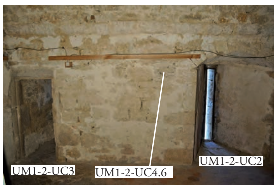
Fig. 158: Partie orientale du mur sud, salle 4
