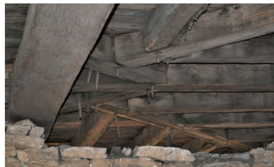
Fig. 479: Jonction entrail, goussets et coyer (côté est)
