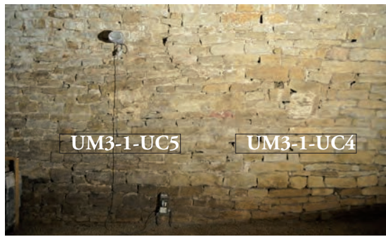
Fig. 57 : Mur nord avec empochements comblés
