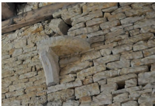
Fig. 474: Détail du support occidental (UM1-5-UC5)
