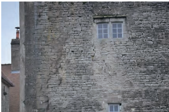
Fig. 40 : Zone rejointoyée entre les 2 e et 3 e niveaux (UM2-3-UC1.1)
