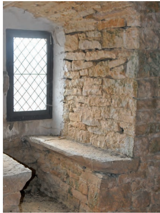
Fig. 321 : Détail de l'ébrasement sud
