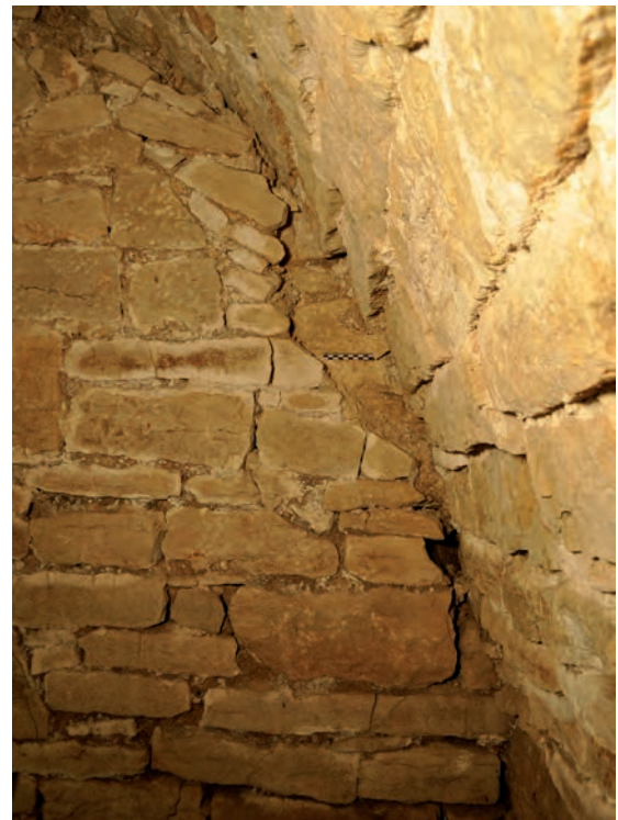
Fig. 68 : Détail des deux parements successifs (UM4-1-UC7 et UM4-1-UC7.3)
