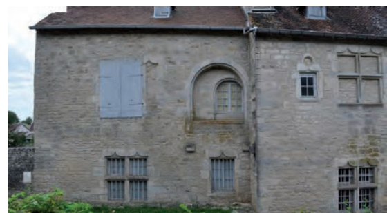
Fig. 9 : Façade nord du bâtiment sud-est
