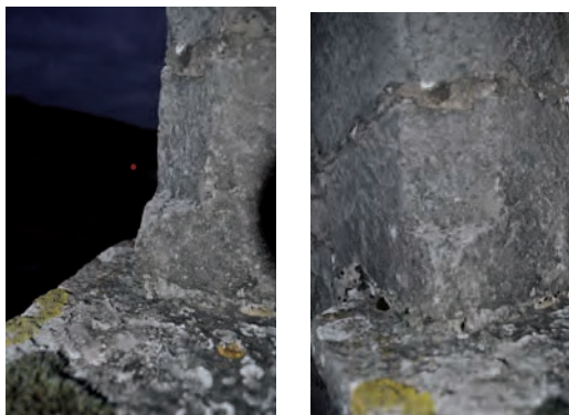
Fig. 347: Détail du congé ouest
