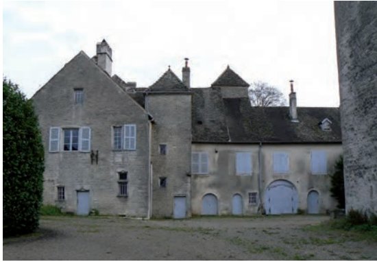
Fig. 12 : Façade occidentale du bâtiment sud-est
