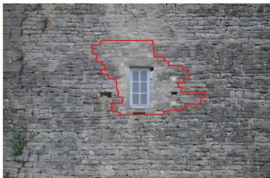
Fig. 132 : Parement extérieur de la fenêtre occidentale de la salle 3 b et tracé probable de la reprise (en rouge)
