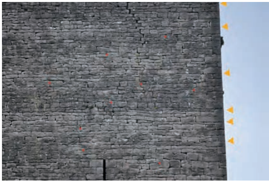
Fig. 28 : Détail de la façade ouest (3 e niveau) avec variations de module et sauts d'assises
