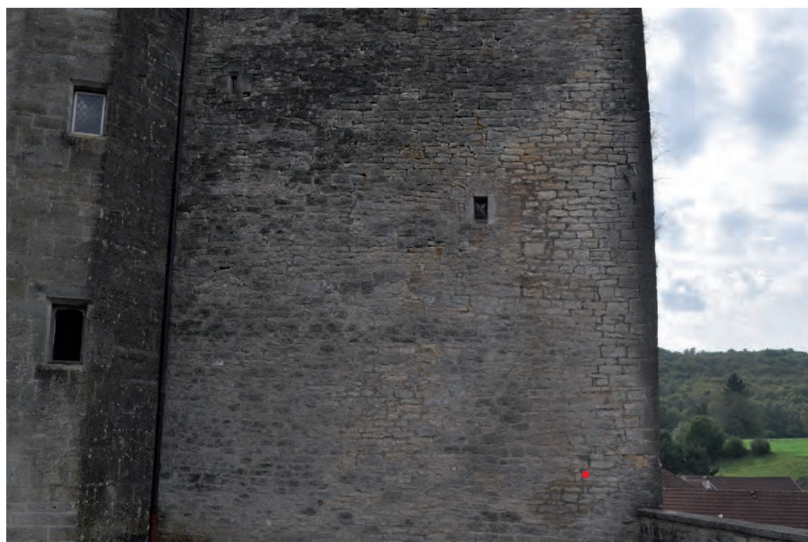
Fig. 31 : Détail de l'angle nord-ouest
