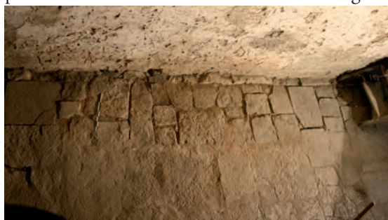
Fig. 244: Sol de dalles calcaires non jointives à proximité de la porte ouest du mur de refend
