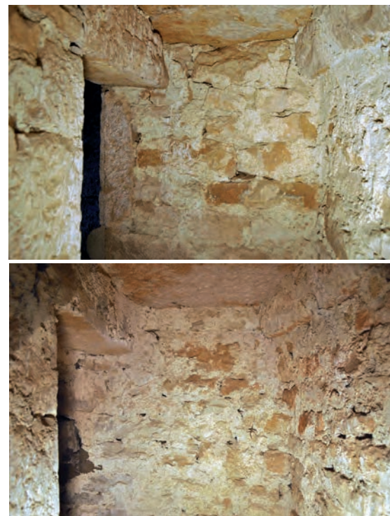
Fig. 372 : Détail des murs nord (UC1.1) (en haut) et sud (UC1.4) (en bas)
