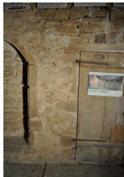
Fig. 191: Maçonnerie entre le placard et la porte
