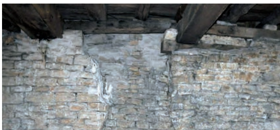
Fig. 458: Détail des reprises en sommets de murs
