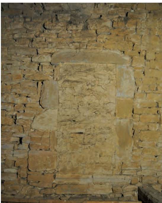
Fig. 305 : Porte (obstruée) de la tourelle d'escalier
