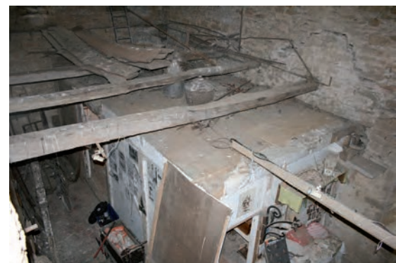
Fig. 285: Vue d'ensemble de la structure
