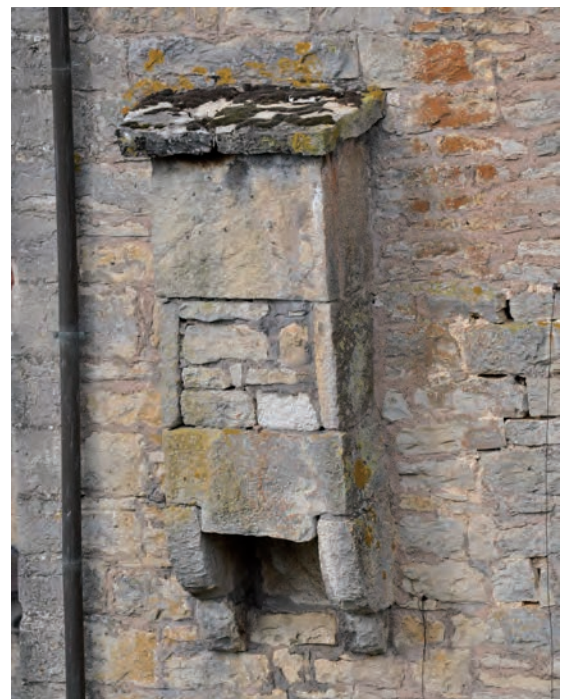
Fig. 265: Détail des latrines en encorbellement
