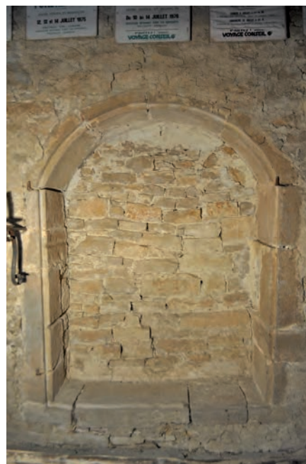
Fig. 187: Placard mural du 3 e niveau (salle 5)
