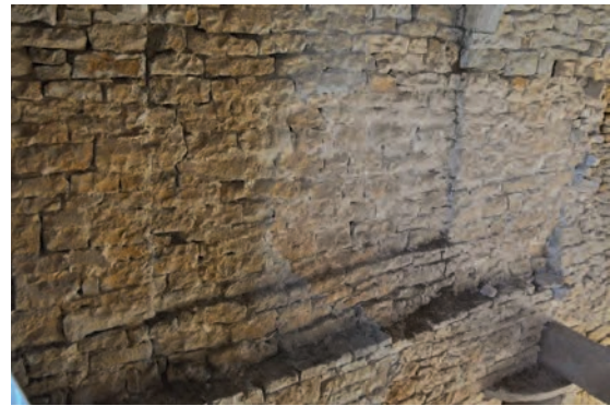
Fig. 472: Détail du ressaut inférieur
