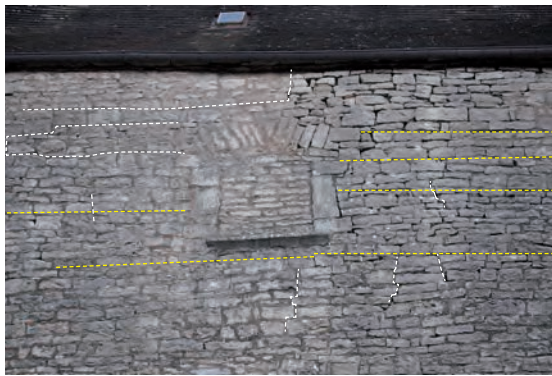
Fig. 465: Parement extérieur au niveau de la baie centrale (UM1-5-UC3)
