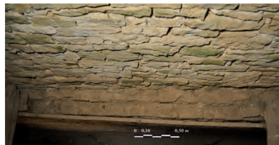
Fig. 316 : Double ressaut, vue du dessus
