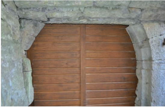
Fig. 66 : À l'extérieur, le linteau de l'arc transformé amortit la voûte du passage extérieur
