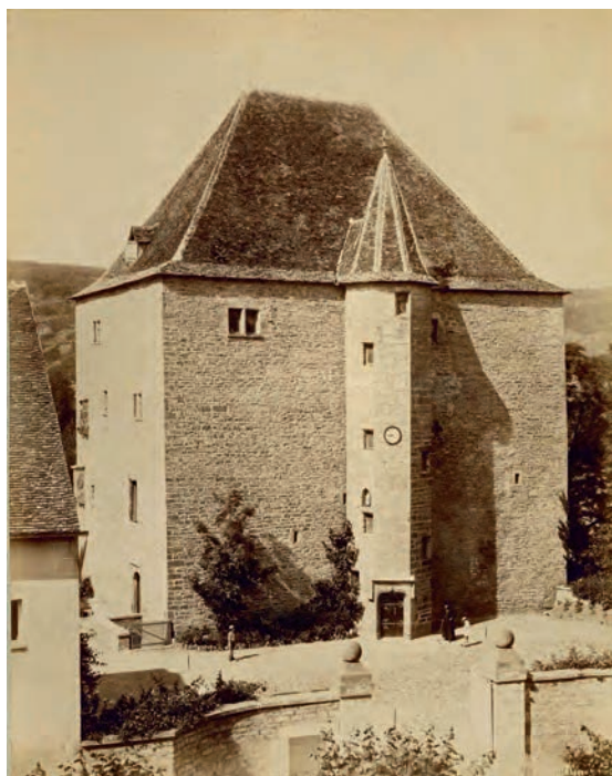
Fig. 21 : Vue générale des façades nord et est (archives E. de Prunelé)
