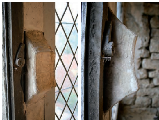
Fig. 359: Détails de la moulure du meneau
