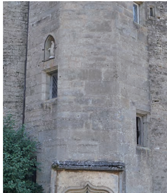
Fig. 33 : Détail de la mise en œuvre de la tourelle d'escalier
