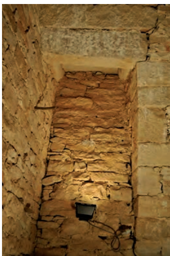
Fig. 119 : Mur sud du conduit
