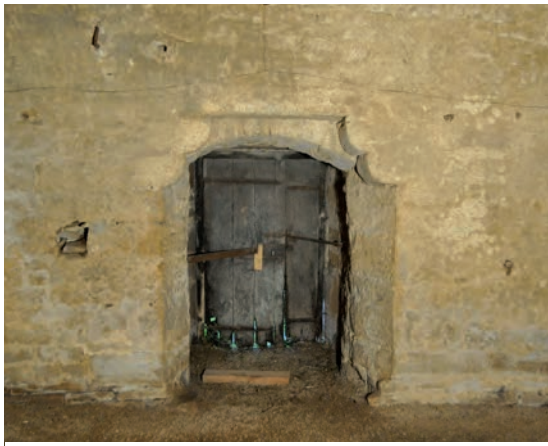
Fig. 83 : Parement intérieur de la porte du mur sud (UM1-1-UC2)
