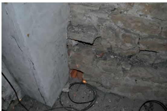
Fig. 213 : Partie supérieure des deux conduits au-dessus du plancher, en limite des 3 e et 4 e niveaux
