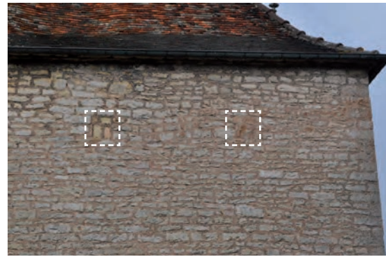
Fig. 384: Parement extérieur au niveau de la cheminée avec comblement des abouts de corbeaux
