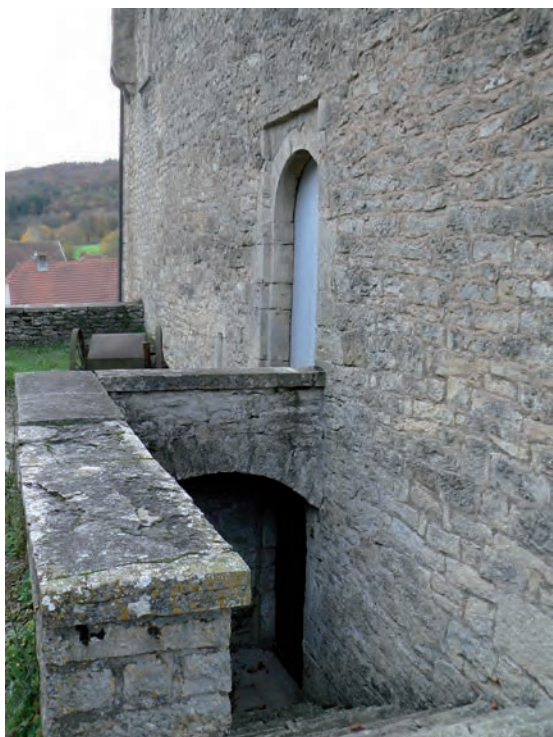
Fig. 44 : Détail de l'escalier d'accès au 1 er niveau depuis la cour
