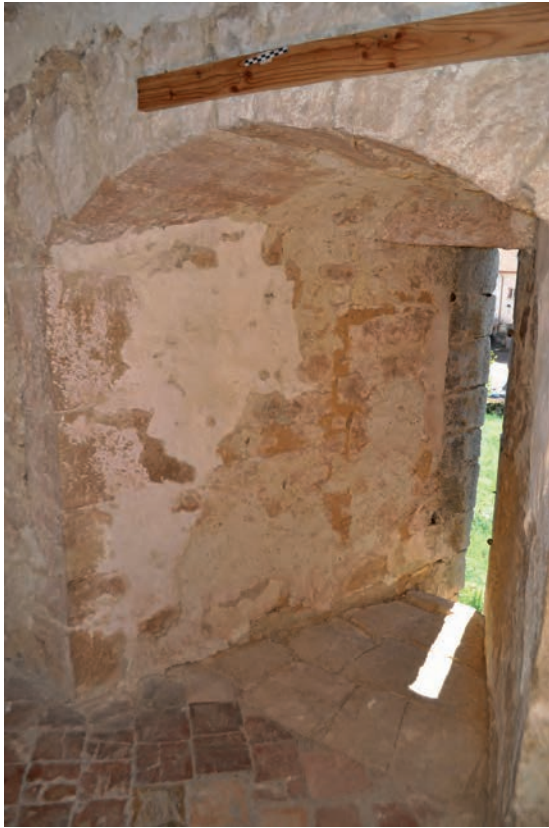
Fig. 159 : Ébrasement oriental de l'archère ouest
