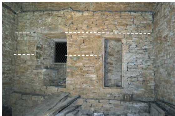
Fig. 367: Vue d'ensemble du mur oriental
