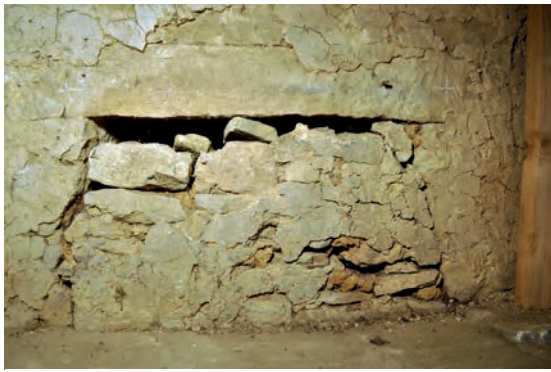
Fig. 257: Détail du comblement de la gaine
