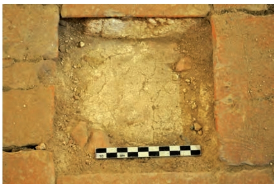
Fig. 140 : Lit de chaux recevant les carreaux de pavement de la salle 4
