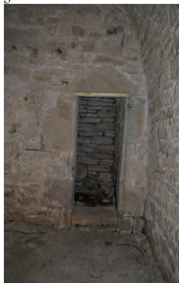
Fig. 89 : Porte de l'escalier intrapariétal
