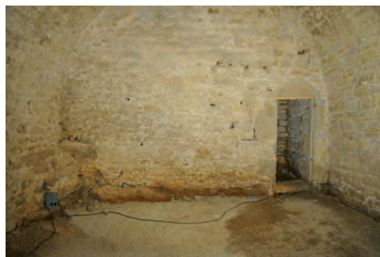
Fig. 88 : Mur oriental de la salle 2 a
