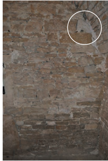
Fig. 105 : Moitié nord du parement est du mur de refend (UM9) avec un remploi (entouré)
