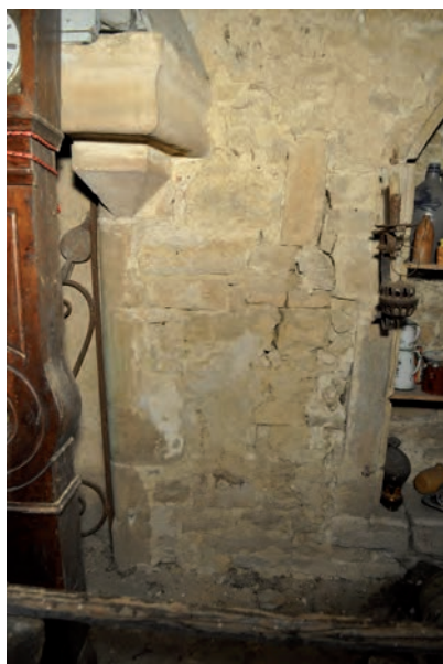
Fig. 192 : Maçonnerie entre le placard et la cheminée
