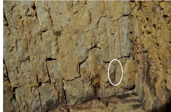
Fig. 96 : Détail du plafond de la voûte avec trace de planche et morceau de bois conservé (entouré)
