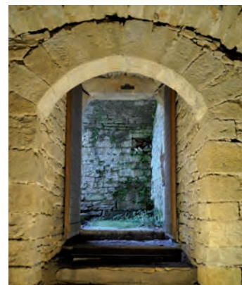
Fig. 61 : Accès au 1 er niveau depuis la cour
