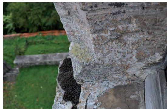
Fig. 322 : Détail du congé (piédroit sud)
