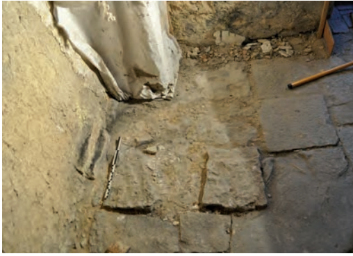
Fig. 220 : Pierres en saillie à l'angle sud-ouest
