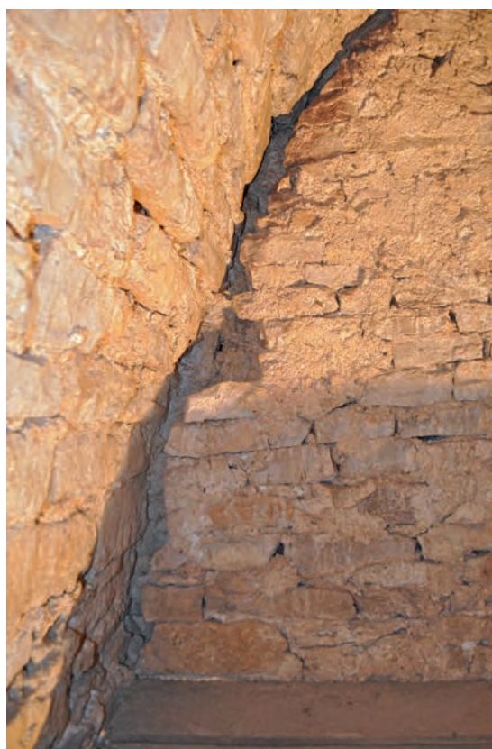
Fig. 98 : Détail de l'UM2, à sa jonction avec le mur sud
