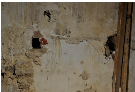
Fig. 209: Détail de la limite horizontale sur le mur ouest
