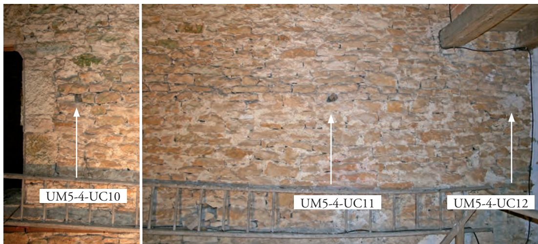
Fig. 331: Boulins à l'ouest milieu du mur de refend (salle 7)
