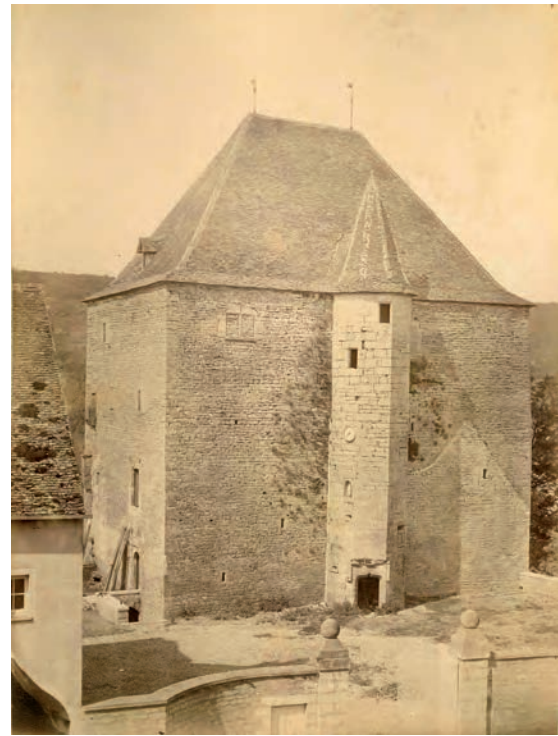
Fig. 16 : Vue plus récente de la façade nord (archives E. de Prunelé)
