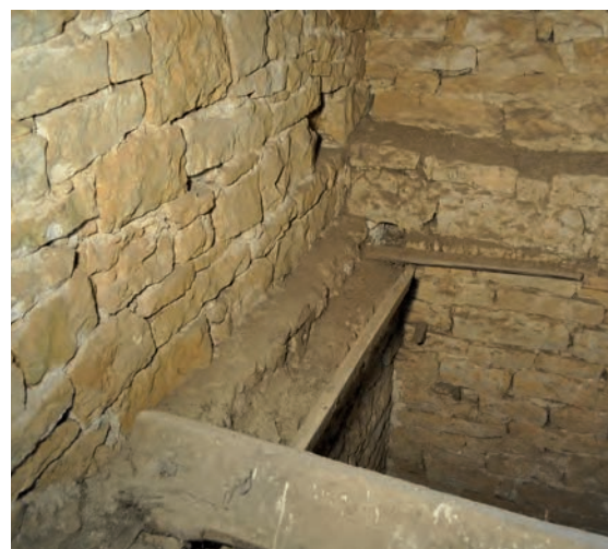
Fig. 315 : Double ressaut à la limite des niveaux 3 et 4
