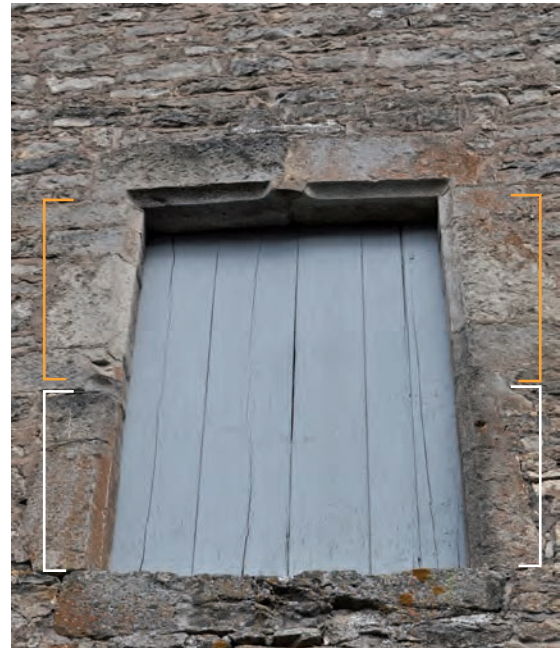
Fig. 239: Porte en parement extérieur : en blanc les zones à chanfrein, en orange les cavets à profils d'arc segmentaire
