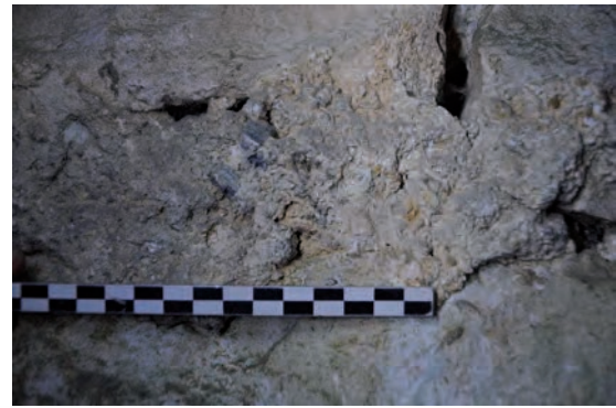
Fig. 433: Détail du mortier du mur de refend
