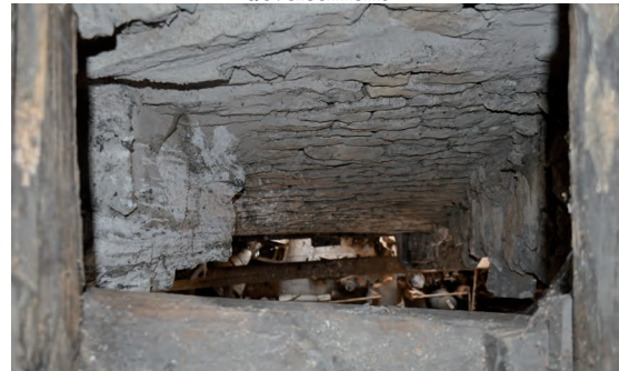
Fig. 460: Conduit vue depuis le comble
