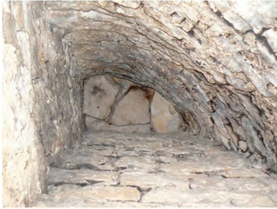
Fig. 154: Dalles couvrant le conduit 1383 ± 10 ans 86 .
