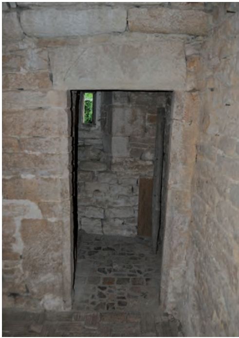
Fig. 169: Porte de l'escalier vers le 3 e niveau
