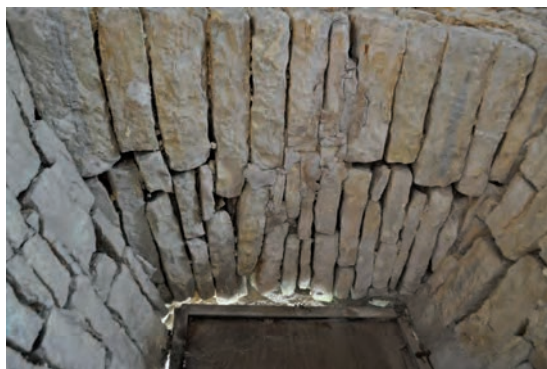
Fig. 450: Détail de la voussure (UM1-5-UC1)
