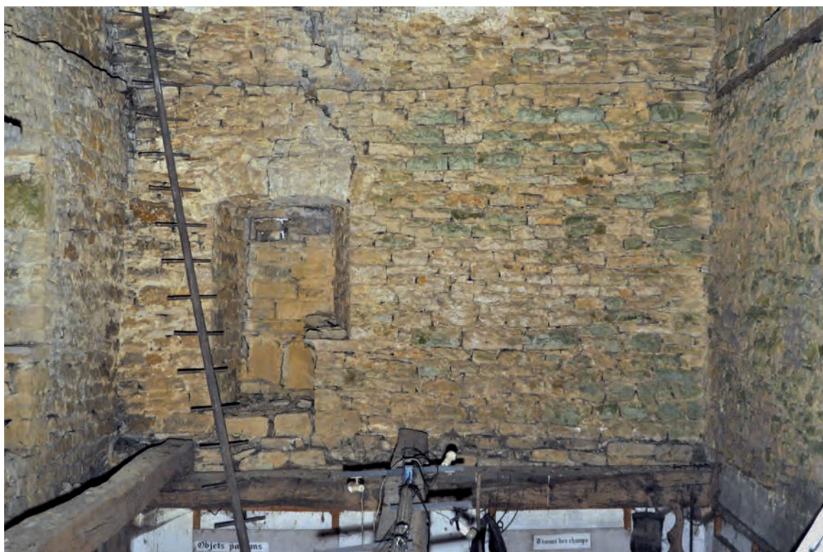
Fig. 341 : Mur occidental, salle 8
