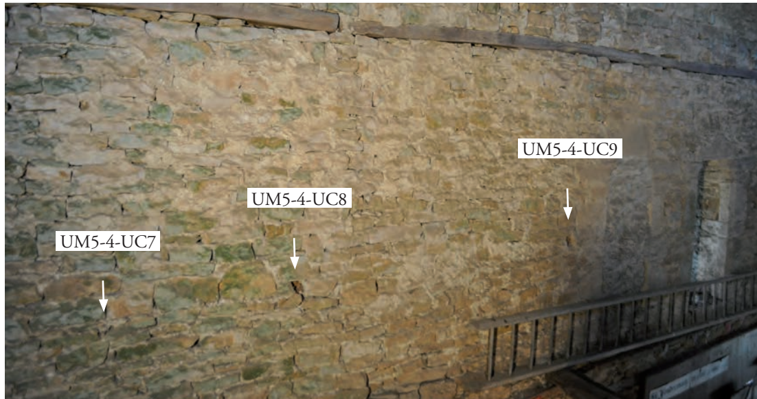
Fig. 330: Boulins au milieu du mur de refend (salle 7)
