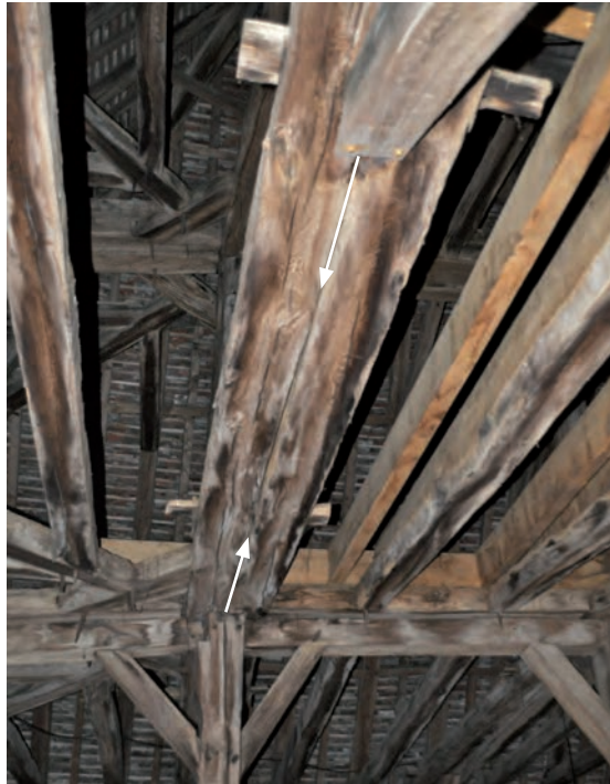
Fig. 489: Détail du faux-entrait, formé d'une pièce double
