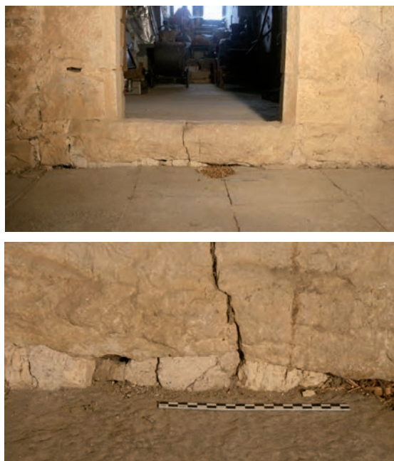
Fig. 249: Localisation et détail du liant sous le seuil de la porte UM5-3-UC2
