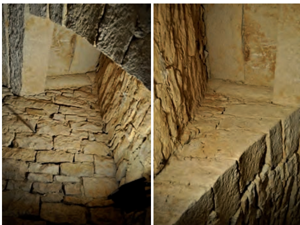
Fig. 117 : Parois latérales du conduit
