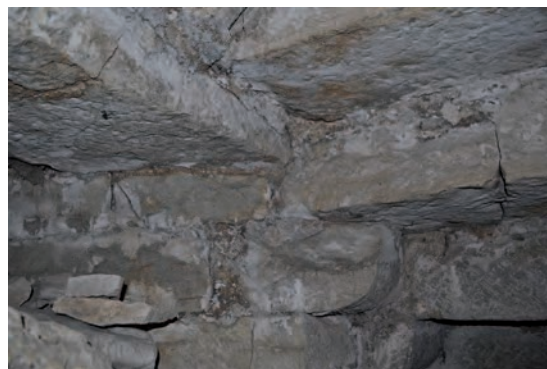
Fig. 103 : Modification du couvrement de l'escalier pour insérer le linteau de la baie
