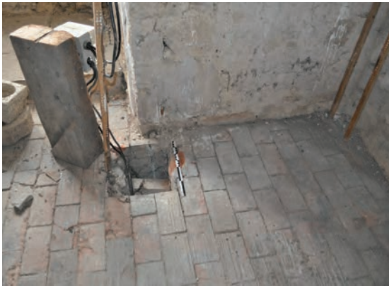
Fig. 247: Sol de briques à l'angle nord-ouest
