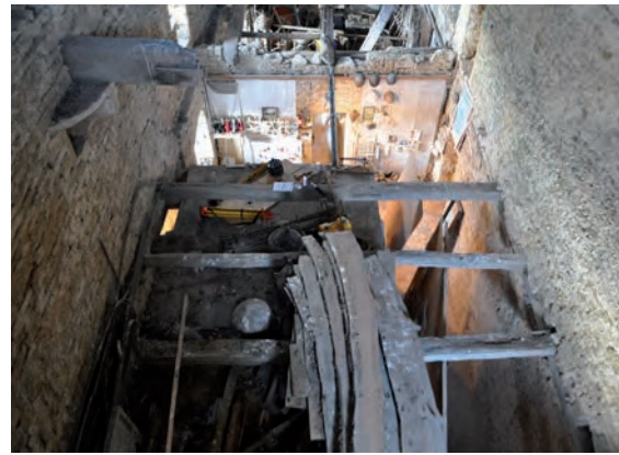
Fig. 336: Situation des poutres de la partie orientale
