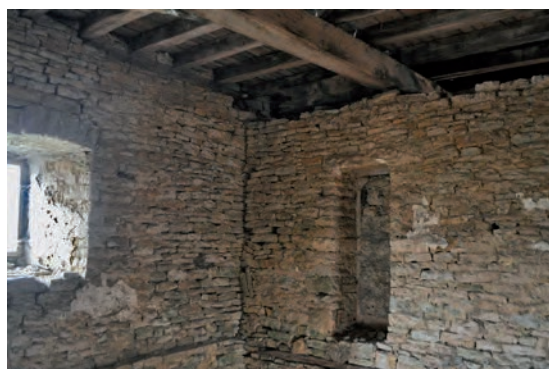
Fig. 444 : Angle nord-ouest, salle 10
