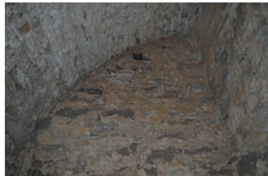
Fig. 101 : Deux enduits couvrent le mur est
