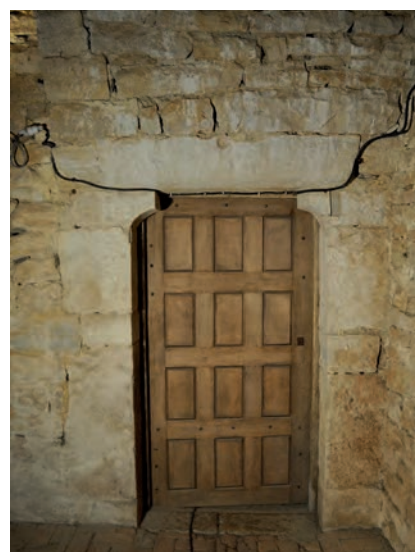
Fig. 121 : Porte entre les salles 3a et 4
