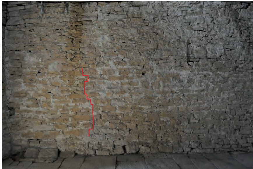
Fig. 225 : Extrémité est du mur de refend (3 e niveau, salle 5)
