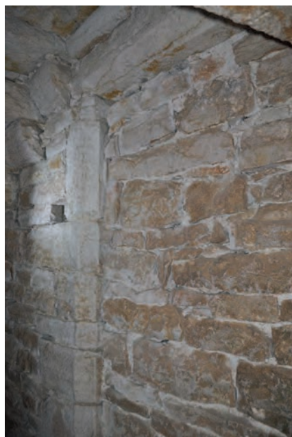
Fig. 184: Porte d'accès initiale, côté escalier intrapariétal
