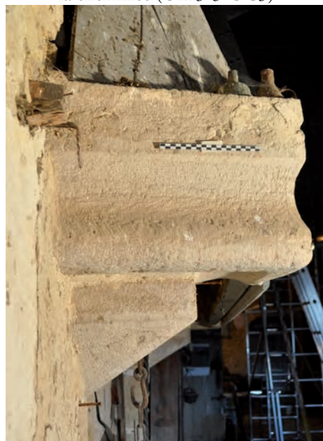
Fig. 197: Détail des corbeaux occidentaux de la cheminée (UM3-3-UC3)
