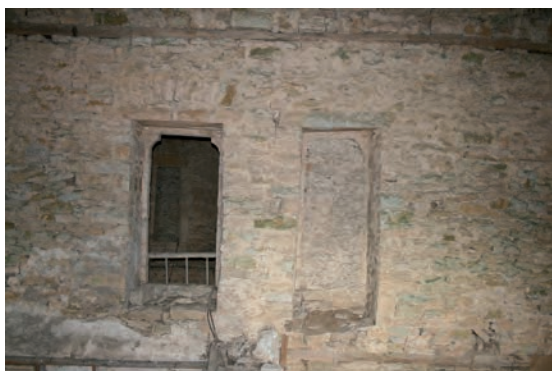
Fig. 333 : Portes du mur de refend, côté sud
