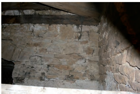
Fig. 410: Détail du parement à l'angle nord-ouest
