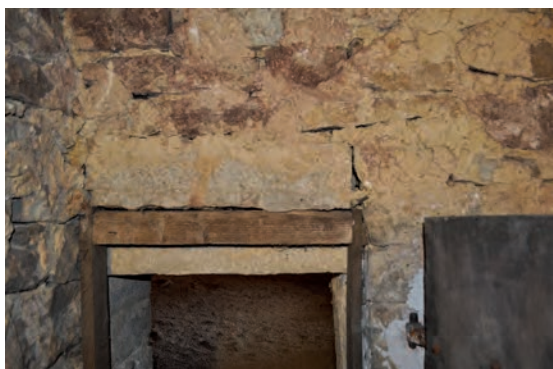
Fig. 91 : Détail du linteau intérieur
