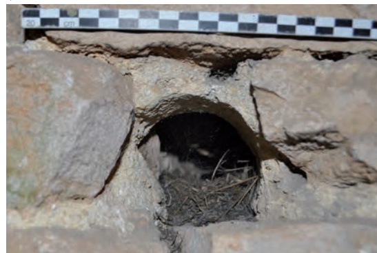
Fig. 435: Détail du trou de boulin (UM5-5-UC5)
