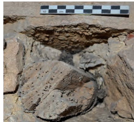
Fig. 436: Détail du trou de boulin (UM5-5-UC7)
