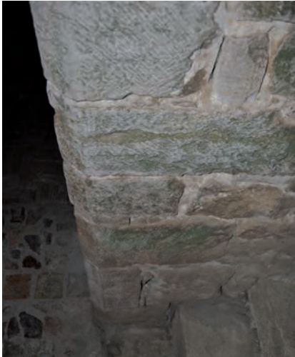
Fig. 170: Arête chanfreinée de l'embrasure de porte, au bas de l'escalier vers le 3 e niveau
