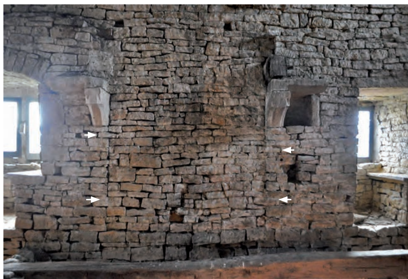
Fig. 349: Détail de la cheminée occidentale (UM1-4-UC2)
