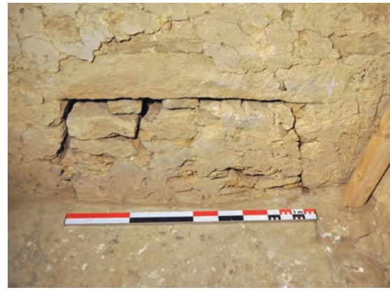
Fig. 232 : Extrémité sud du passage (salle 6 a)
