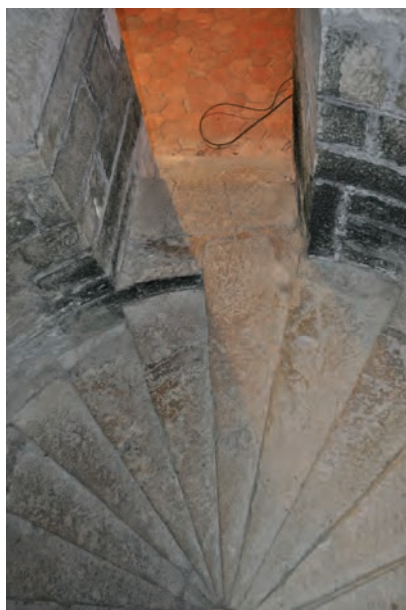
Fig. 128 : Articulation entre la porte et l'escalier
