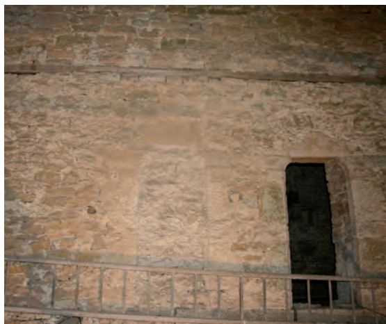
Fig. 299: Les deux portes voisines du mur de refend
