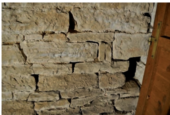
Fig. 63 : Gaine de verrouillage inférieure de la porte UM4-1-UC3 (tableau nord)
