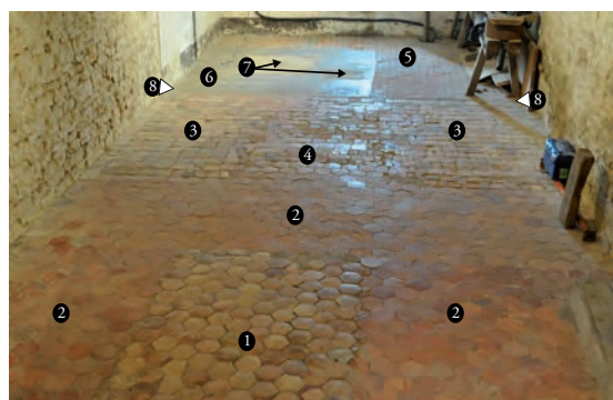
Fig. 137 : Disposition des sols de la salle 3 b de couleur jaune/beige à rouge sombre avec de fréquentes traces de gabarit.
