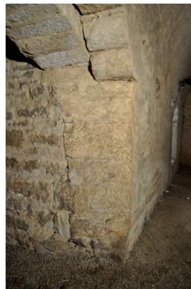
Fig. 86 : Détail du piédroit occidental avec traces de retailles des assises inférieures
