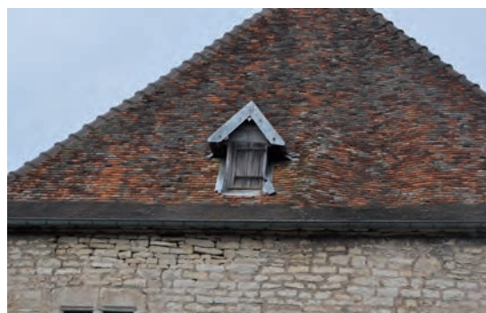
Fig. 499: Détail de la couverture sur le pan oriental
