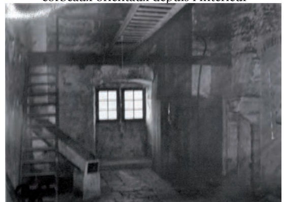
Fig. 200: Cliché ancien montrant la cheminée dépourvue de hotte, et plusieurs aménagements
