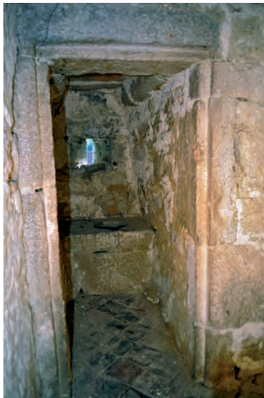
Fig. 163 : Latrines du 2 e niveau
