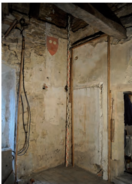
Fig. 208: Angle nord-ouest de la salle 5
