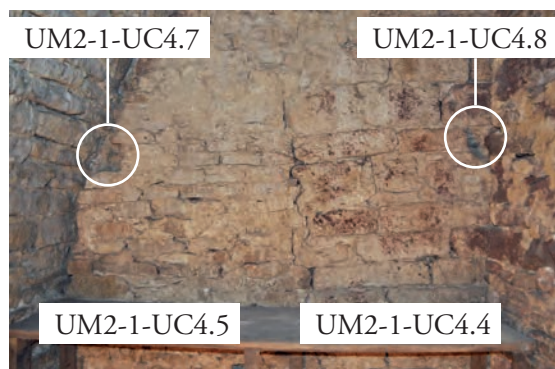
Fig. 97 : À gauche, l'appareil de petit module, à droite, de plus grands moellons
