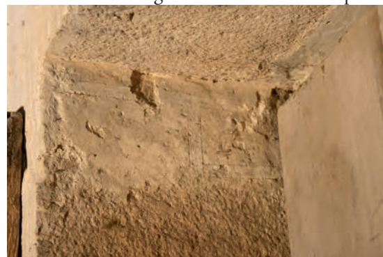
Fig. 253: Faux-joints et traces d'outils dans l'embrasure de la porte
