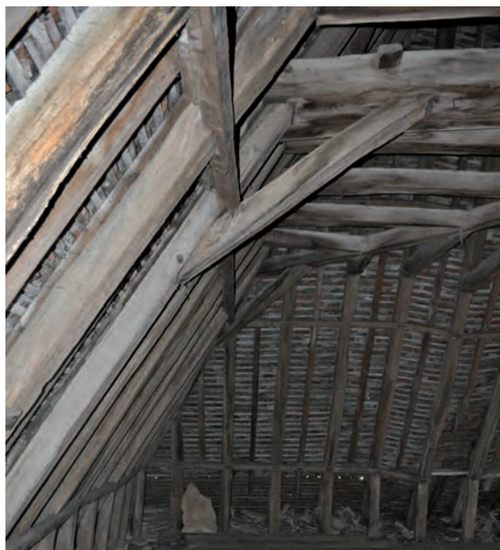
Fig. 490: Jonction du faux-entrait / chevron-arbalétrier
