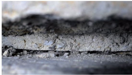
Fig. 430: Localisation (en haut) et détail (en bas) du mortier pris au-dessus de la sablière
