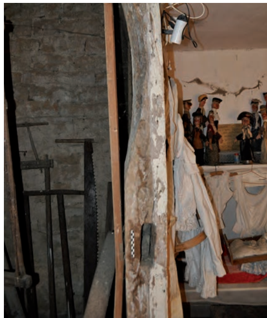
Fig. 288: Poteau porteur (au nord-est)
