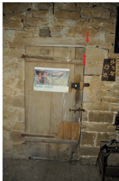
Fig. 185: Porte d'accès de la tourelle
