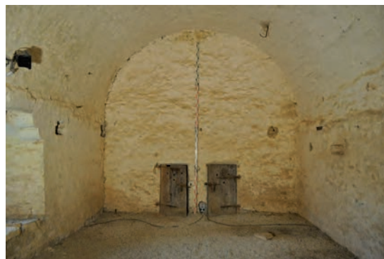
Fig. 77 : Mur de refend transversal séparant la salle 2a des salles 2b et 2c
