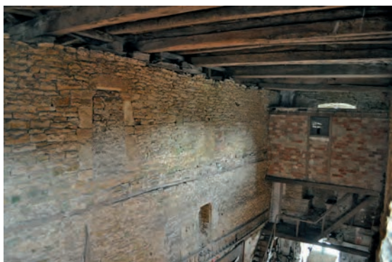
Fig. 417: Partie supérieure du mur et calage en bois
