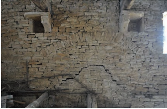
Fig. 361 : Maçonnerie du contrecœur
