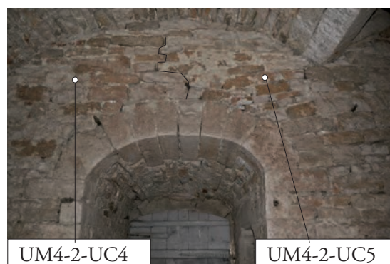
Fig. 110 : Mur oriental de la salle 3 a
