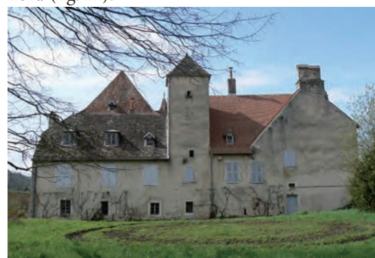
Fig. 11 : Façade orientale du bâtiment sud-est
