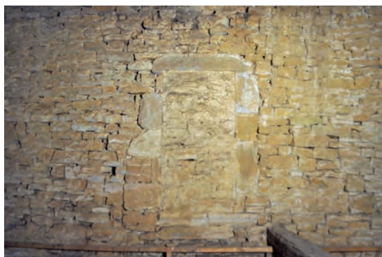
Fig. 309 : Maçonneries autour de la porte
