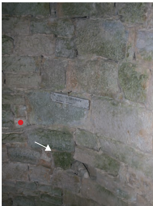
Fig. 302: Couture du mur de cage de la tourelle d'escalier au niveau de l'escalier intrapariétal
