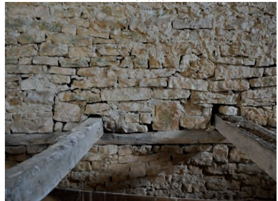
Fig. 337: Insertion des deux poutres centrales dans la maçonnerie nord (UM5)
