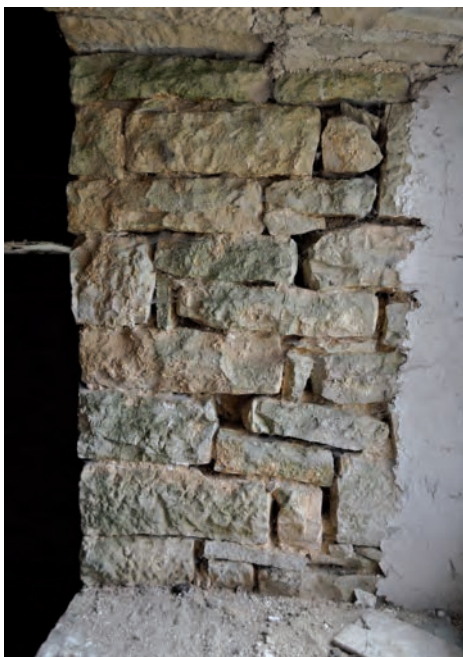
Fig. 404: Ébrasement occidental de la fenêtre (UM3-5-UC2)
