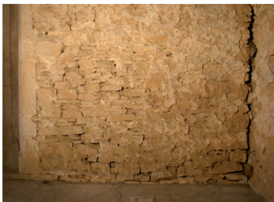
Fig. 250: Mur de refend (UM10), parement est, côté nord
