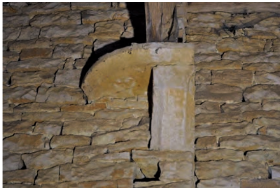
Fig. 383: Détail du support nord de la cheminée, salle 9 (UM4-5-UC2)
