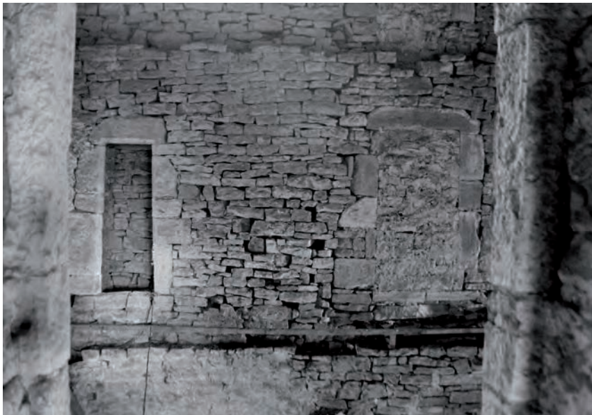
Fig. 310: Parement du mur nord entre les portes de l'escalier primitif et celui de la tourelle
