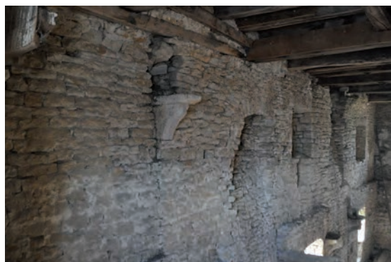
Fig. 448: Mur sud, salle 10
