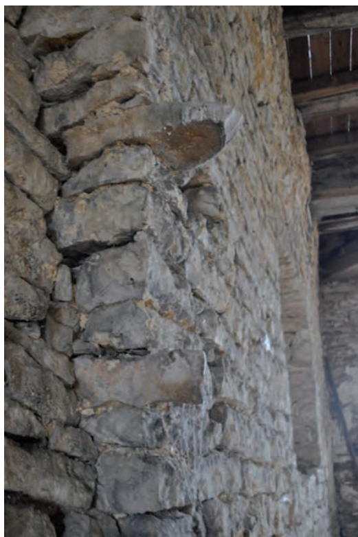
Fig. 454: Détail du piédroit ouest du conduit de cheminée
