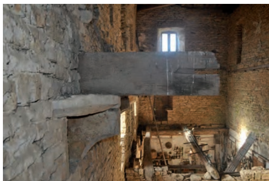
Fig. 363 : Face est des supports orientaux de la cheminée (UM1-4-UC4)
