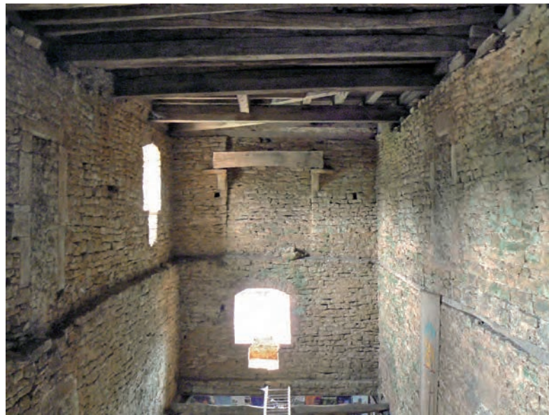
Fig. 380: Salle 9 vue de l'ouest
