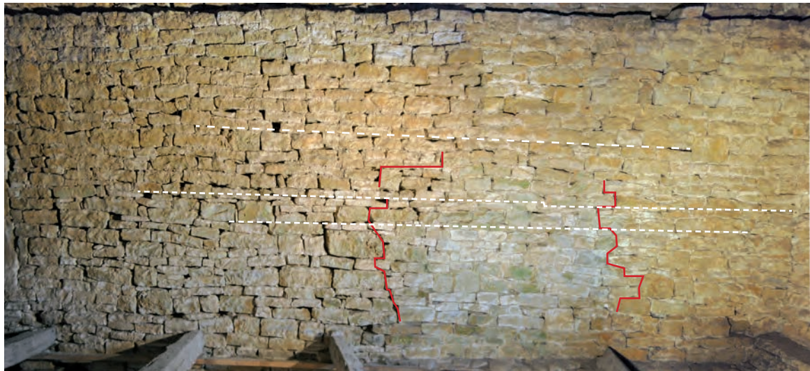
Fig. 314 : Moitié orientale du parement nord de la salle 7 (assemblage photographique)
