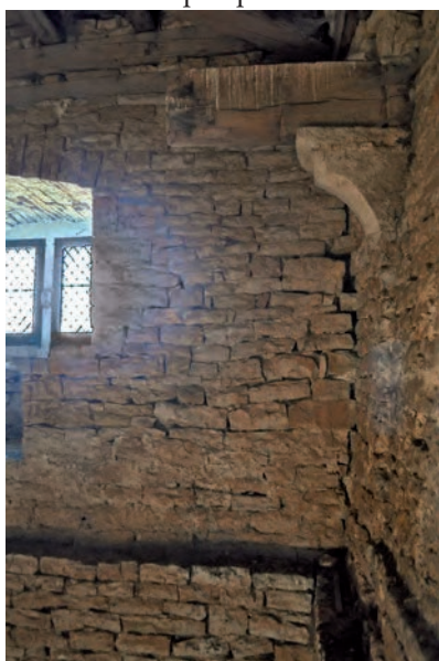
Fig. 438: Jonction des murs sud et est
