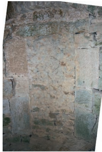
Fig. 398: Porte du 5 e niveau, côté tourelle d'escalier
