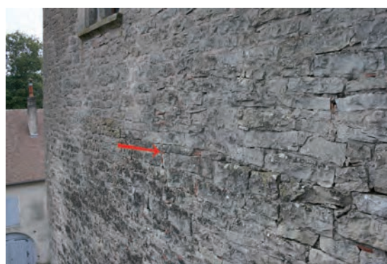
Fig. 32 : Détail du ressaut entre les 4 e et 5 e niveaux, à l'est de la façade nord
