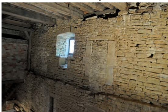
Fig. 389 : Partie occidentale du mur nord avec des réparations à l'emplacement des sablières
