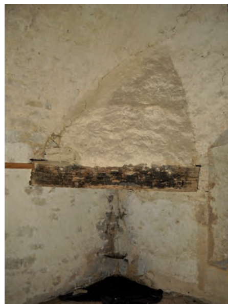
Fig. 152 : Détail de la cheminée d'angle
