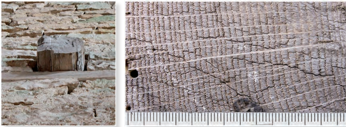
Figure 9 : Fragment d'une des poutres porteuses du plancher du 5 e niveau du donjon (éch. 26) – Macrophotographies de la coupe transversale du bois, préparé et analysé selon un procédé non invasif.
