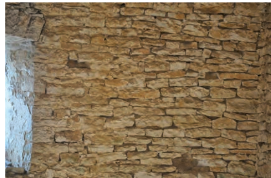
Fig. 440: Détail du parement au nord
