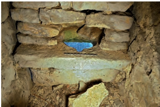
Fig. 376: Détail de l'assise des latrines
