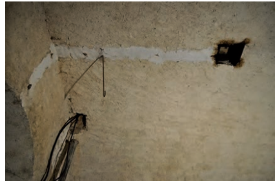
Fig. 73 : Percements de la voûte liés, pour partie au moins, à l'installation du réservoir d'eau
