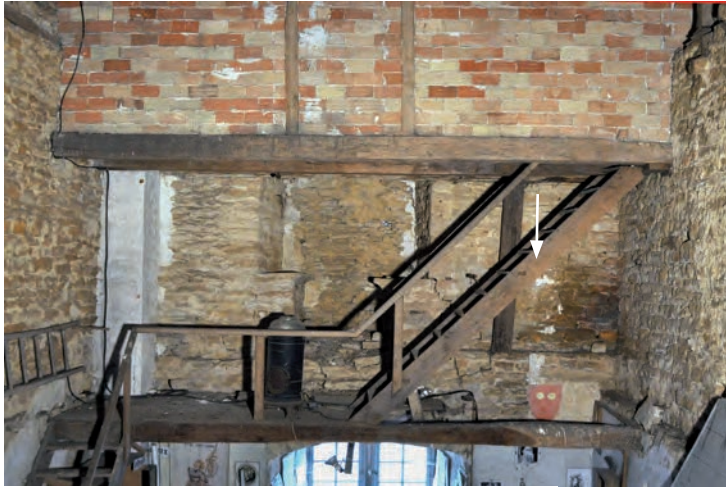
Fig. 334 : Mur ouest, salle 7
