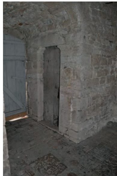
Fig. 108 : Tableau sud de la porte (UM4-2-UC3) percé de la porte de l'escalier intrapariétal (UM4-2-UC2)
