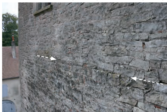
Fig. 394: Détail du ressaut dans la moitié orientale du mur
