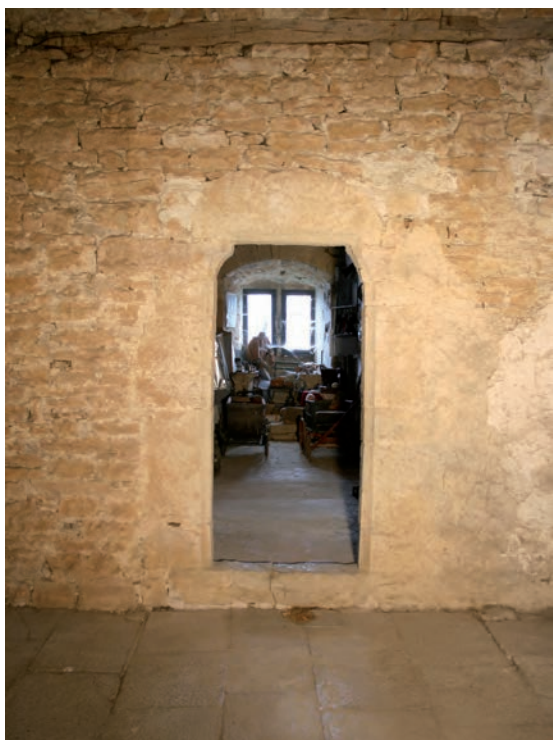
Fig. 228: Vue de la porte centrale (UM5-3-UC2)
