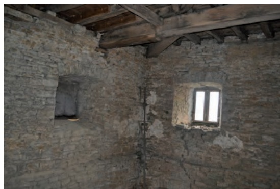
Fig. 443 : Angle sud-ouest, salle 10
