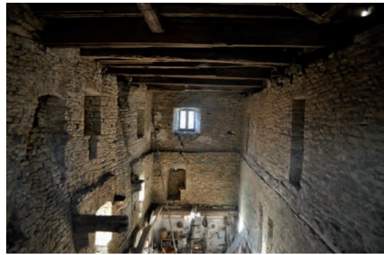
Fig. 378: Salle 10 vue de l'est
