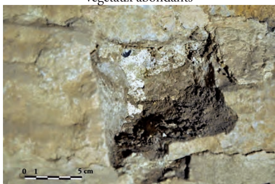
Fig. 236: Mortier conservé au cœur du mur
