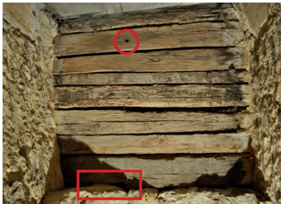
Fig. 84 : Couvrement en bois avec des traces de cheville (en haut) et d'assemblage (en bas)
