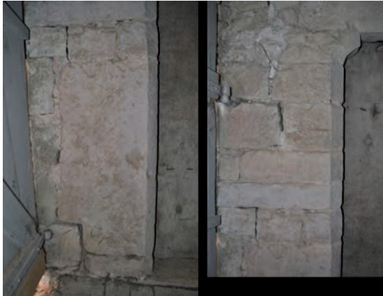
Fig. 111 : Jonction entre l'encadrement de la porte extérieure (UM4-2-UC3) et celle de l'escalier intrapariétal (UM4-2-UC2)
