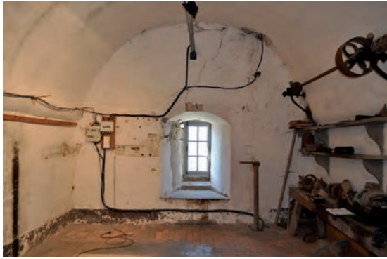
Fig. 129 : Mur occidental de la salle 3 b
