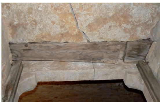
Fig. 53 : Détail de l'arrière-linteau en bois (UM5-1-UC1)
