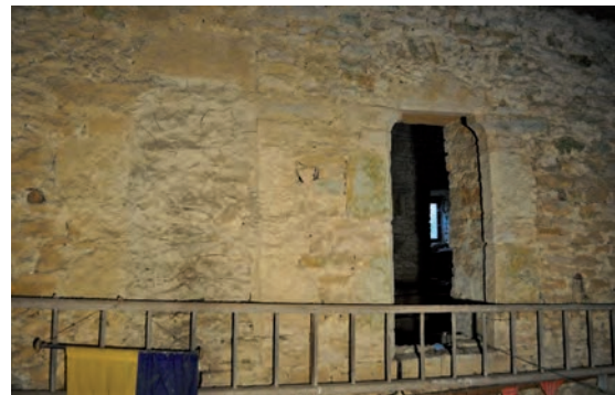
Fig. 332: Portes du mur de refend, côté nord
