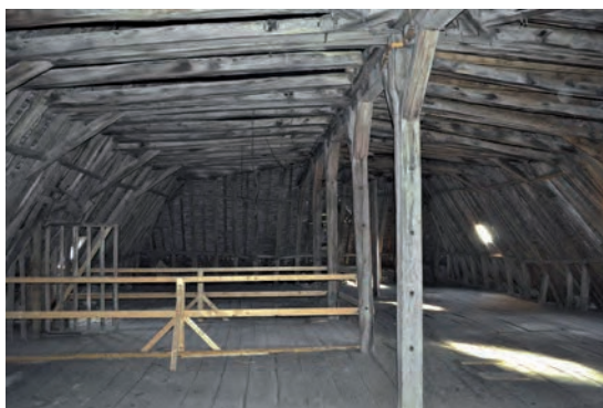
Fig. 482: Vue de la charpente vers l'est
