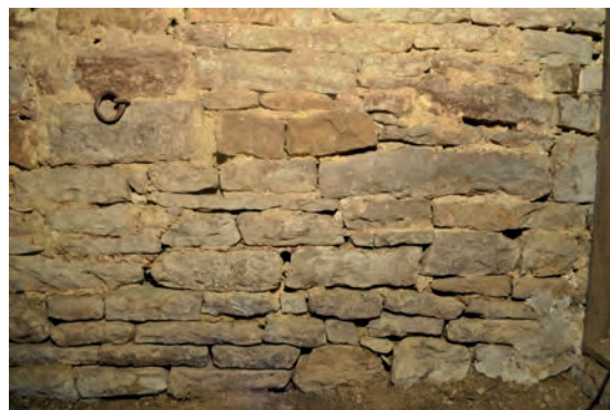
Fig. 93 : Détail de l'UM8-1-UC1, près de la porte
