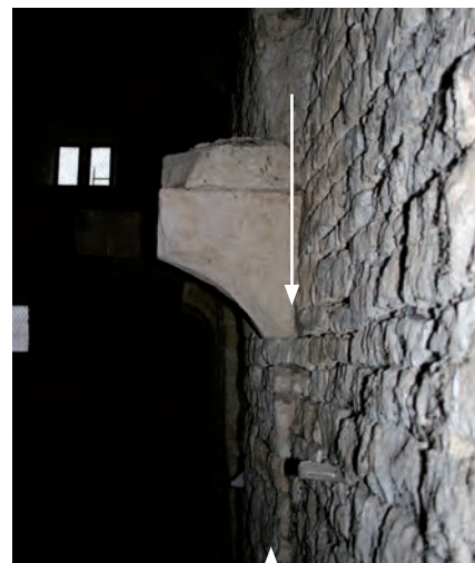
Fig. 350: Profil du contrecœur et du support oriental de la cheminée UM1-5-UC2
