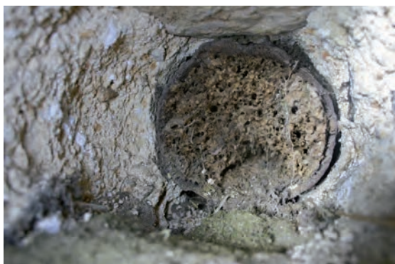
Fig. 420: Détail du boulin UM5-5-UC6 (masqué par un nid sur la fig. 416)
