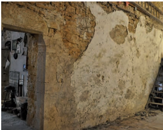
Fig. 221 : Parement entre les deux portes
