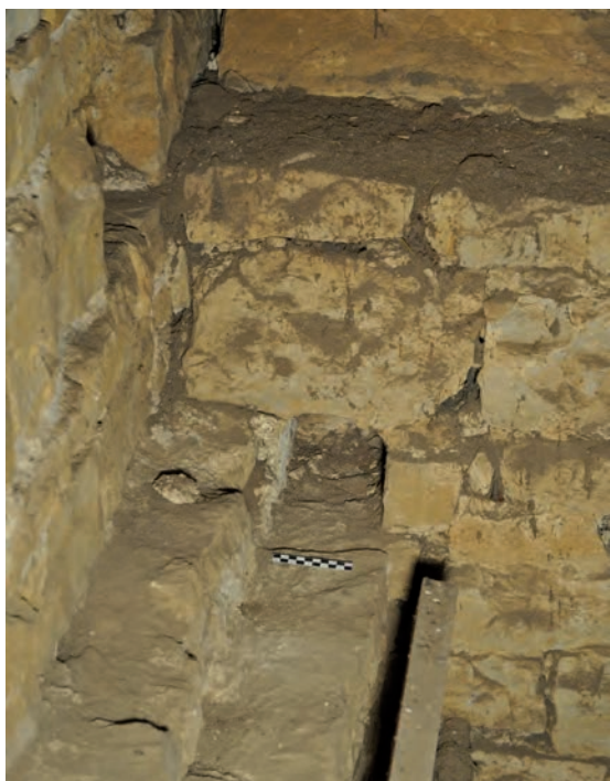
Fig. 317: Détail du ressaut inférieur qui accueillait une sablière
