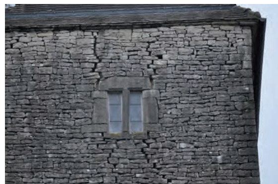
Fig. 447 : Parement extérieur de la fenêtre occidentale
