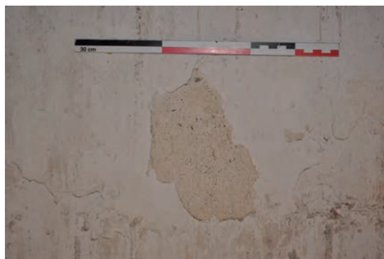
Fig. 277: Enduit visible sur le contrecœur
