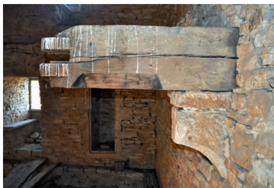
Fig. 364 : Face ouest des supports orientaux de la cheminée (UM1-4-UC4)
