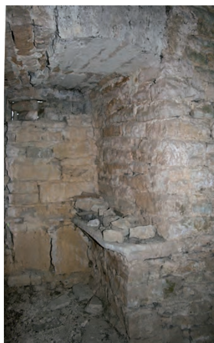
Fig. 342 : Détail de l'ébrasement nord et du comblement, baie UM2-5-UC1
