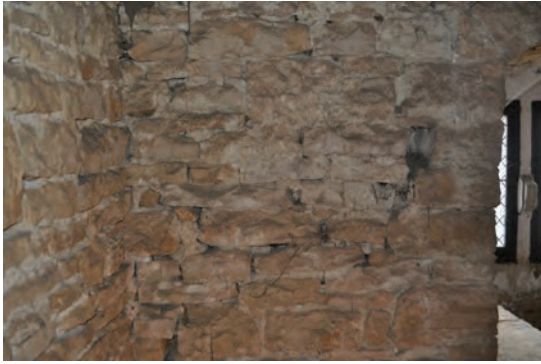
Fig. 320 : Détail du parement au nord de la baie
