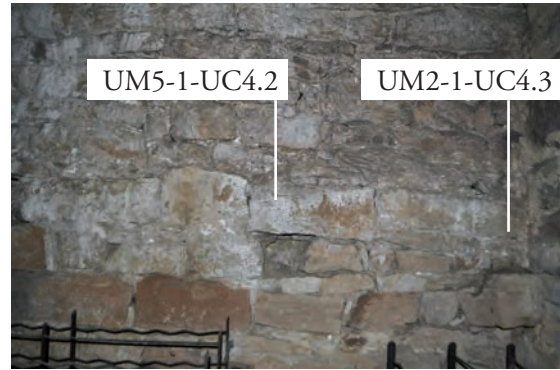
Fig. 100 : Parement du mur nord, à l'est
