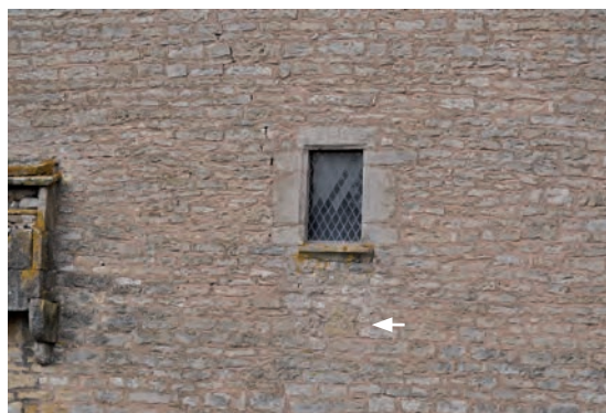
Fig. 370: Parement extérieur de cette baie
