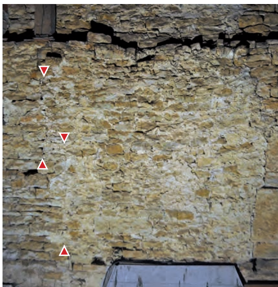
Fig. 312: Détail du conduit obstrué au 4 e niveau
