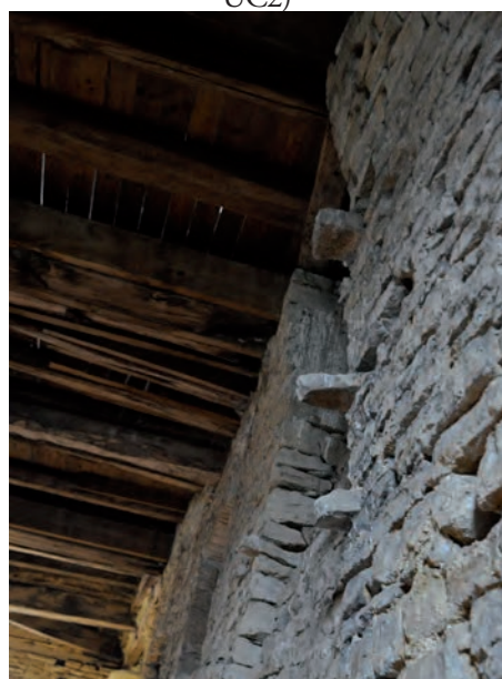
Fig. 456: Pierres en encorbellement soutenant la hotte
