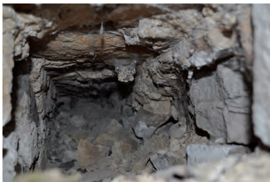
Fig. 64 : Négatif de poutre dans le mortier de la gaine de verrouillage supérieure
