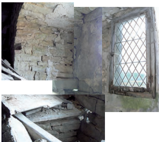
Fig. 411: Assemblage photographique (très déformé) de la fenêtre occidentale
