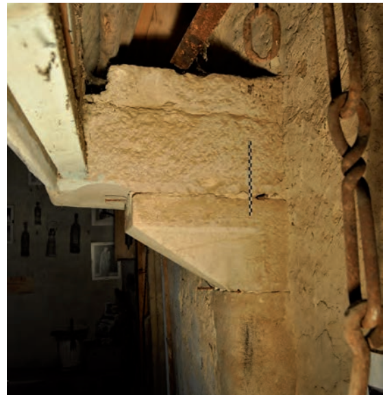
Fig. 198: Détail des corbeaux occidentaux de la cheminée, côté intérieur
