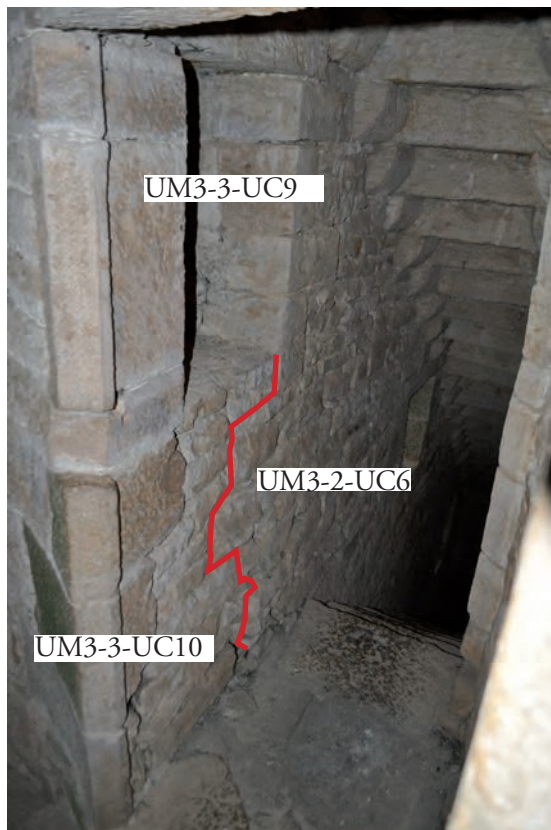
Fig. 176 : Fenêtre supérieure de l'escalier
