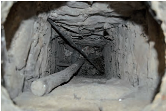
Fig. 165 : Conduit des latrines du 2 e niveau
