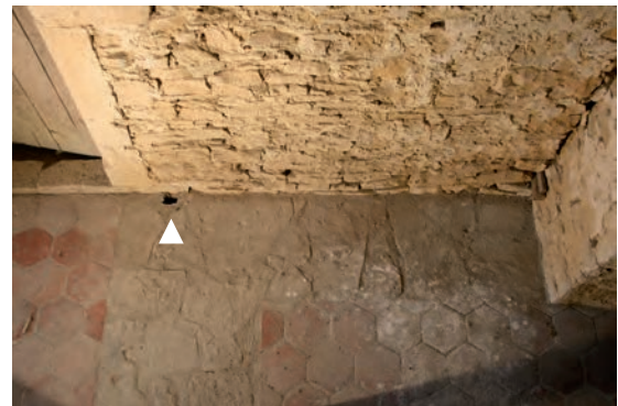
Fig. 254: Sol à l'angle nord-ouest de la salle 6 a
