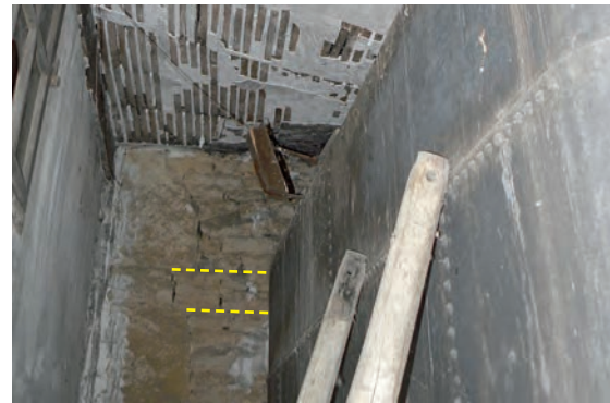
Fig. 413: Plafond de la salle 9 bis
