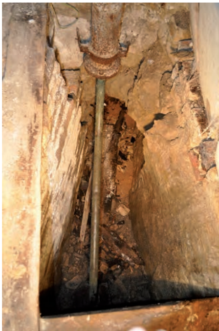
Fig. 72 : Fosse de la conduite de pompage aménagée vers 1914
