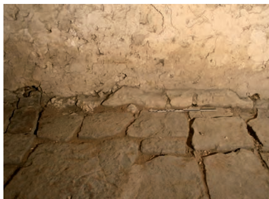
Fig. 245: Le sol de dalles butte contre l'assise inférieure du mur
