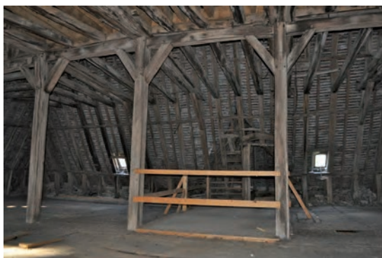
Fig. 483: Vue des poinçons, vers le nord
