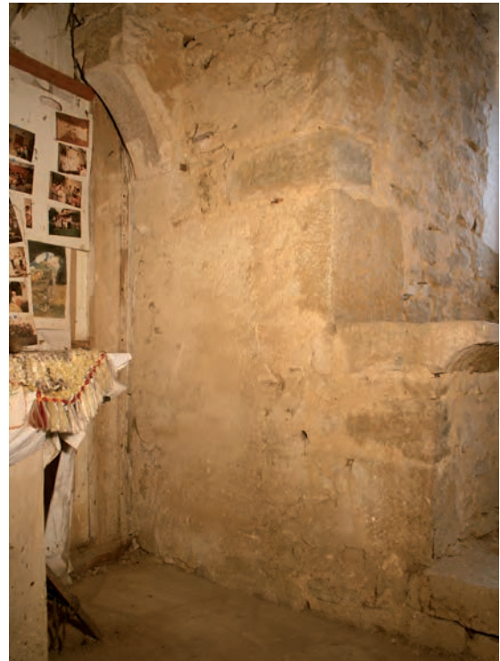
Fig. 275: Maçonnerie entre la cheminée (UM1-3-UC4) et la baie centrale (UM1-3-UC3)
