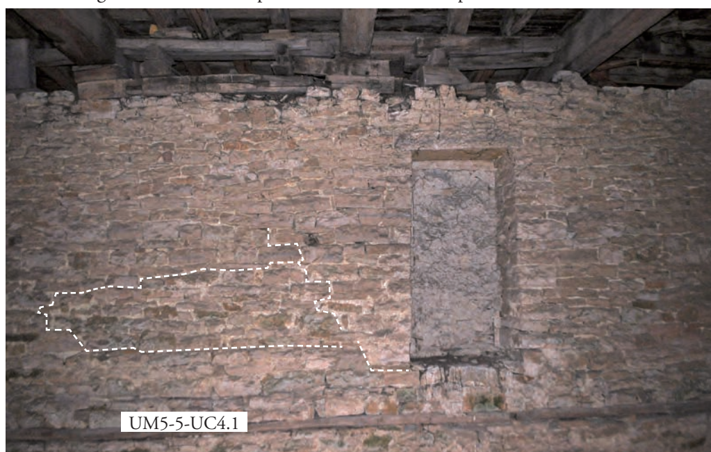
Fig.427: Insertion de la porte UM5-5-UC2 dans le parement nord de la salle 10
