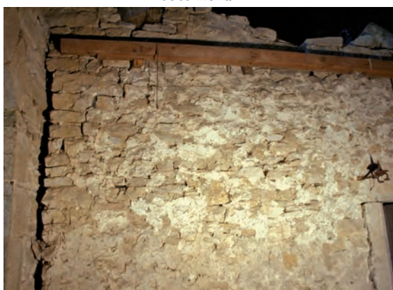
Fig. 251: Mur de refend (UM10), parement est, côté sud
