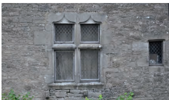
Fig. 6 : Détail de la fenêtre à croisée (façade sud)
