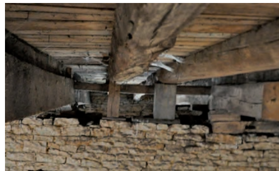
Fig. 478: À l'arrière plan, entrail entre deux poutres
