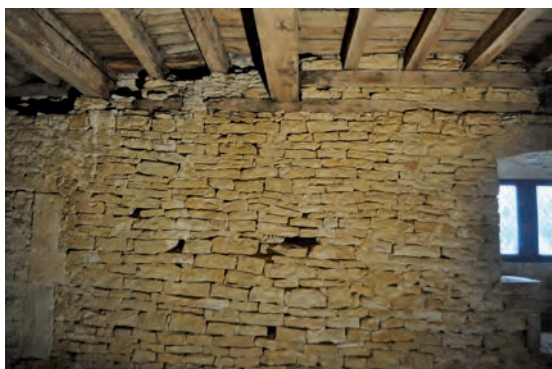
Fig. 388 : Partie centrale du mur nord, les sablières sont conservées à l'est et disparaissent à l'ouest
