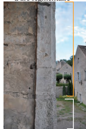
Fig. 239: Porte en parement extérieur : en blanc les zones à chanfrein, en orange les cavets à profils d'arc segmentaire
