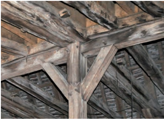
Fig. 488: Jonction faux-entrait / poinçon
