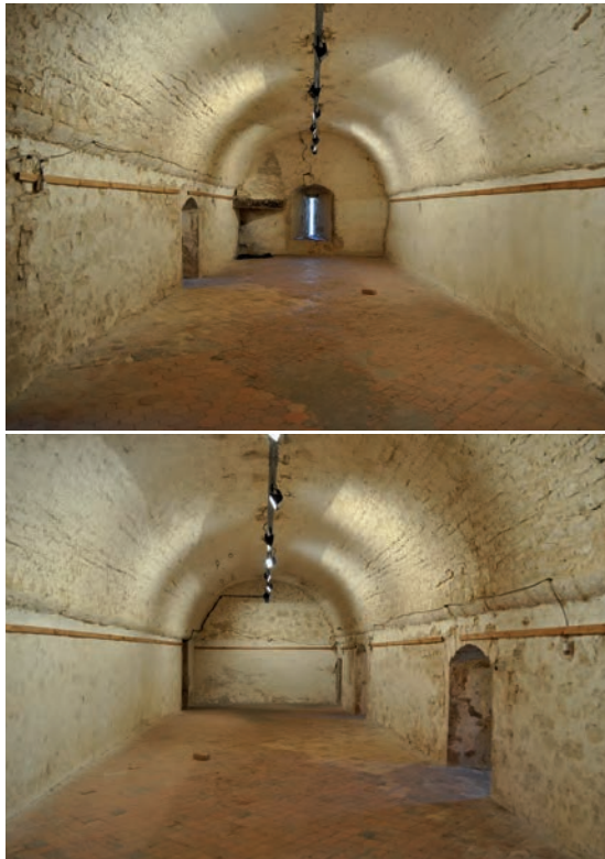
Fig. 138 : Vues générales de la salle 4, vers l'ouest (en haut) et vers l'est (en bas)
