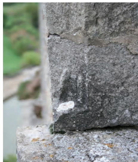
Fig. 357: Congé du piédroit occidental
