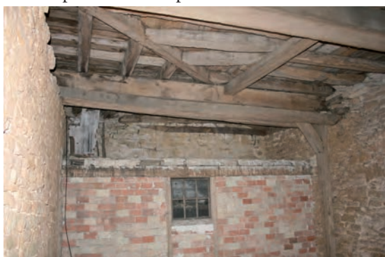
Fig. 390 : Extrémité occidentale du parement nord et mur ouest avec à nouveau des sablières hautes
