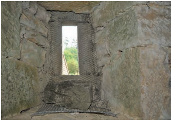
Fig. 175 : Fenêtre intermédiaire de l'escalier
