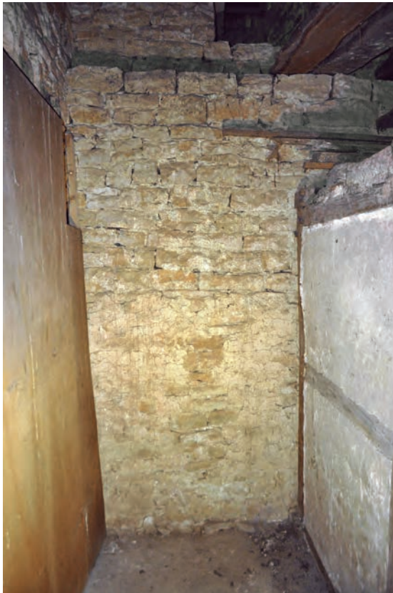
Fig. 258: Mur est, salle 6 a
