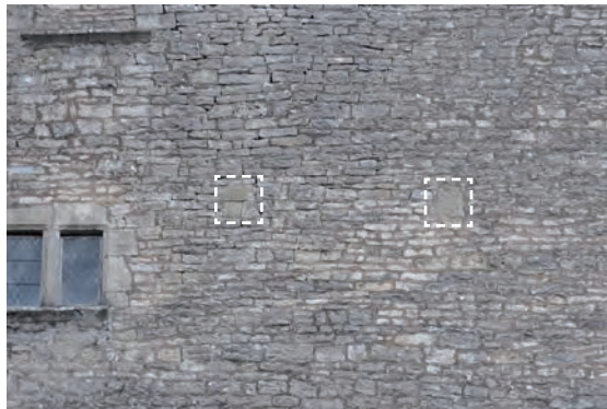
Fig. 366: Parement extérieur au niveau de la cheminée avec comblement au niveau des abouts des corbeaux de bois (encadrés)
