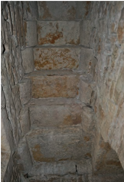
Fig. 171: Couvrement du palier inférieur
