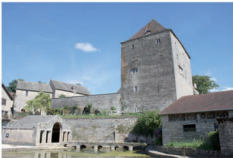
Figure 1 : Château de Fondremand (70) – façade Ouest
