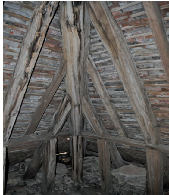
Fig. 491: Détail de l'angle nord-ouest
