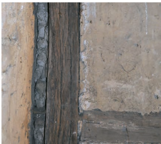
Fig. 290: Comblement derrière la paroi orientale
