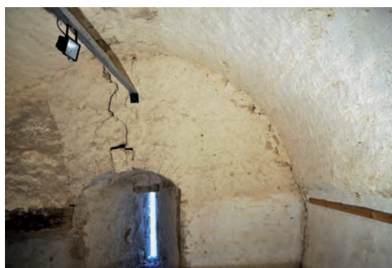
Fig. 146: Partie supérieure du mur ouest
