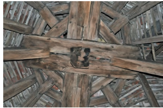
Fig. 495: 2° niveau d'enrayure de la tourelle d'escalier
