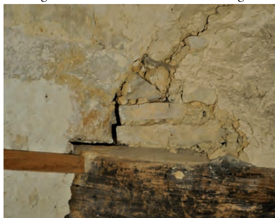
Fig. 153 : Détail de la maçonnerie de la hotte
