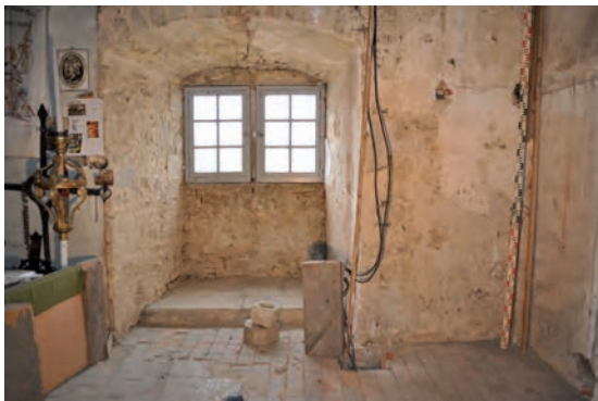
Fig. 211 : Fenêtre occidentale, salle 5
