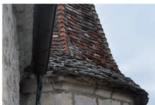
Fig. 501: Détail des tuiles arêtières de la tourelle
