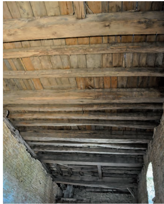
Fig. 477: Plafond du vaisseau nord, vers l'ouest
