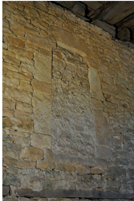
Fig. 425: Détail de la porte UM5-5-UC2 et de son comblement
