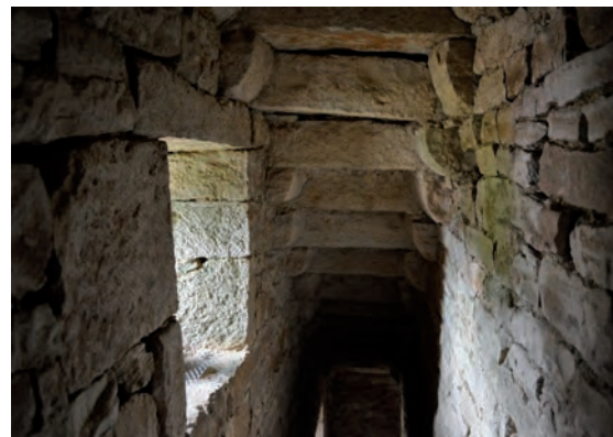
Fig. 174: Fenêtre intermédiaire de l'escalier
