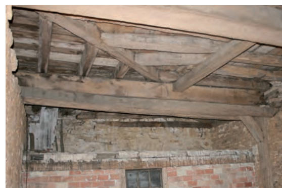
Fig. 409: Partie supérieure du mur occidental, salle 9
