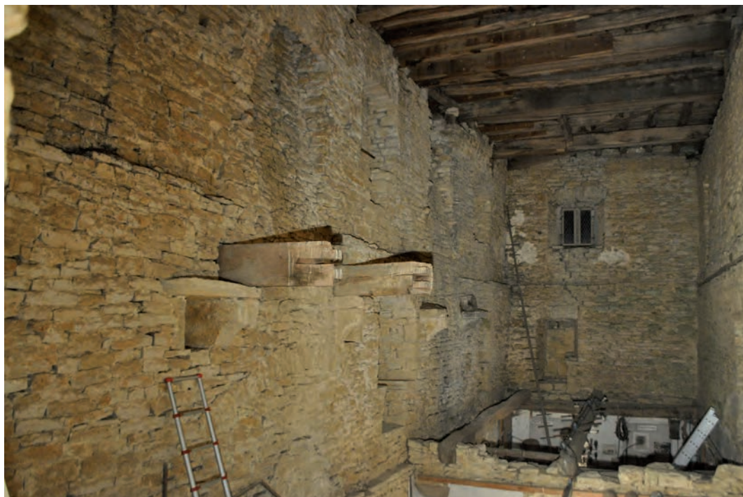
Fig. 344: Vue d'ensemble des aménagements du mur sud du 4 e niveau, salle 8
