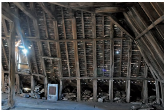
Fig. 492: Implantation du conduit de cheminées en briques
