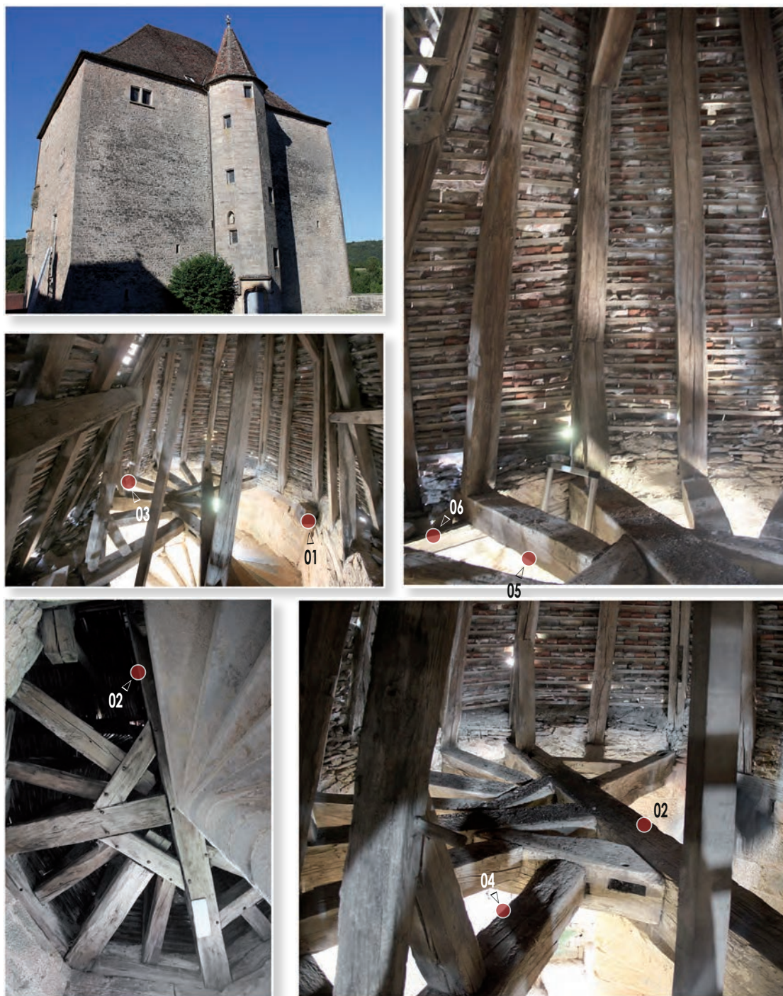
Figure 2 : Tourelle d'escalier du donjon - Localisation des bois échantillonnés
