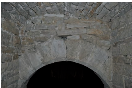
Fig. 62 : Couvrement de l'embrasure de la porte orientale (UM4-1-UC3)
