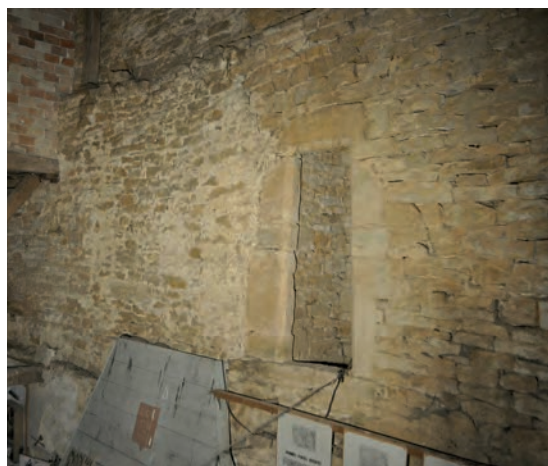
Fig. 300: Porte de l'escalier initial
