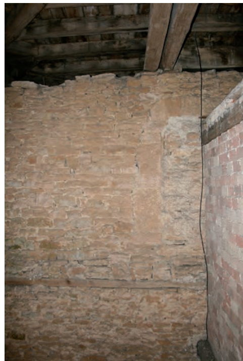
Fig. 414: Poutre du plafond de la salle 9 bis insérée dans le comblement d'une porte
