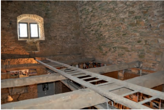
Fig. 304 : Poutrage récent, salle 7 côté oriental
