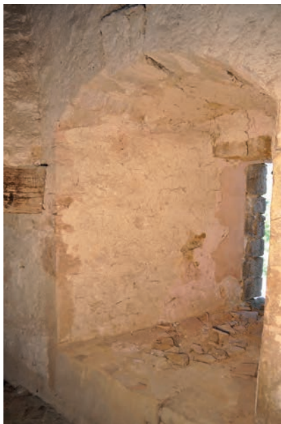
Fig. 149: Jonction entre le piédroit sud de l'archère et le linteau de la cheminée d'angle
