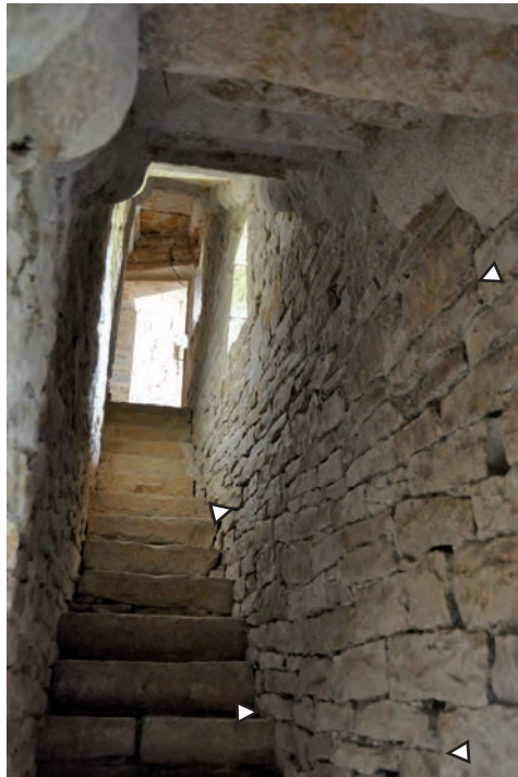
Fig. 172: Paroi nord de l'escalier intrapariétal les triangles signalent des assises de réglage
