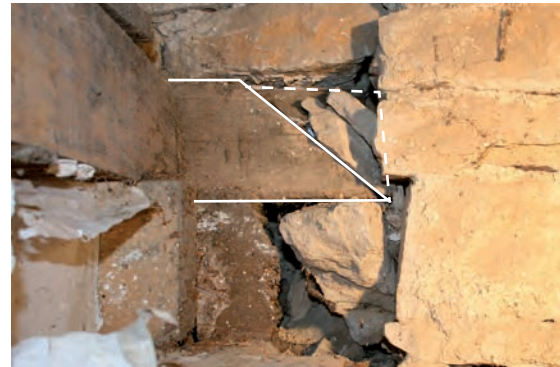
Fig. 280: Extrémité de la poutre (en blanc) avec tenon d'assemblage (tiret)
