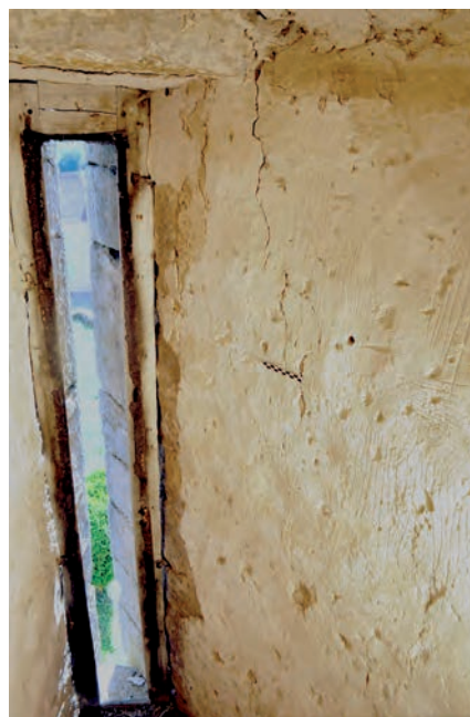
Fig. 161 : Archère orientale, ébrasement ouest
