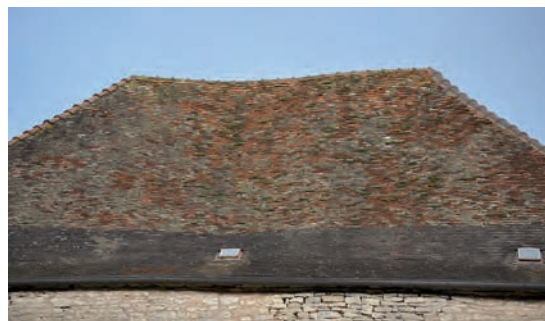
Fig. 498: Détail de la couverture sur le pan sud
