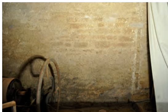
Fig. 55 : Mur nord de la moitié occidentale de la salle 1 avec une trace de cloison à droite et la pompe au premier plan
