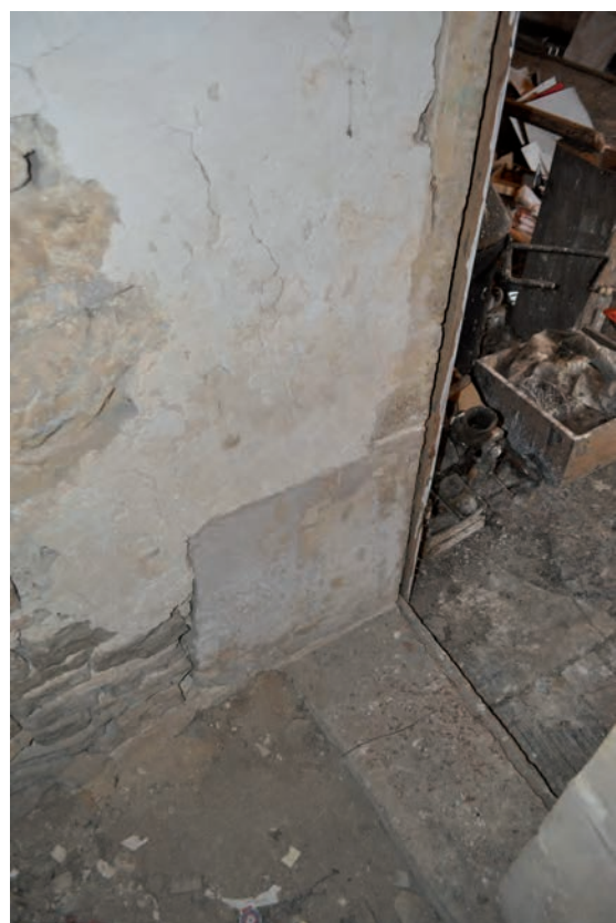
Fig. 204 : Détail de la base du piédroit oriental et de la maçonnerie en petit appareil de ce mur
