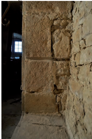
Fig. 190: Détail du piédroit occidental (en rouge, mortier avec fragment de verre pilé)
