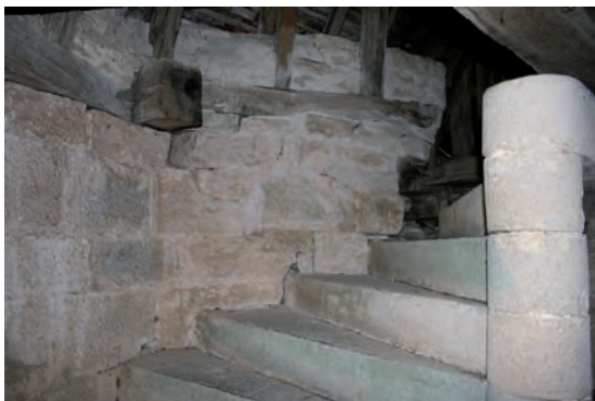
Fig. 494: Sommet du mur de cage, à l'est, avec une sablière recevant les chevrons-arbalétriers
