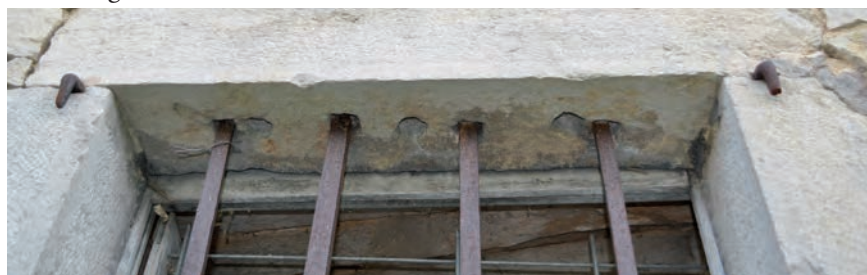
Fig. 80 : Détail des trous de fixation des barreaux, des gonds et des traces de bouchardes
