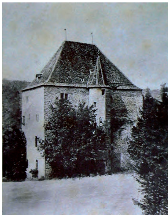
Fig. 22 : Vue plus récente des façades nord et est (publiée par Amédée Richardet)
