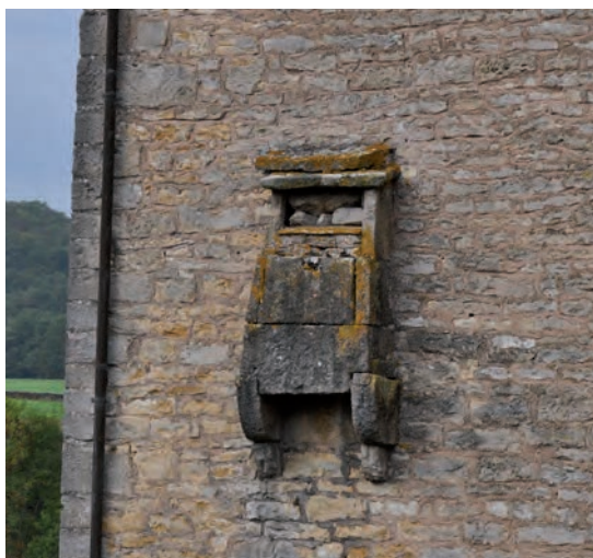
Fig. 374: Parement extérieur des latrines du 4 e niveau (UM4-4-UC1)
