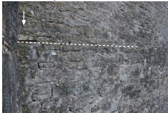
Fig. 392: Moitié occidentale du parement extérieur en jaune, le retrait observé
