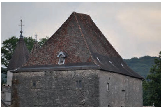
Fig. 497: Toiture des pans ouest et sud
