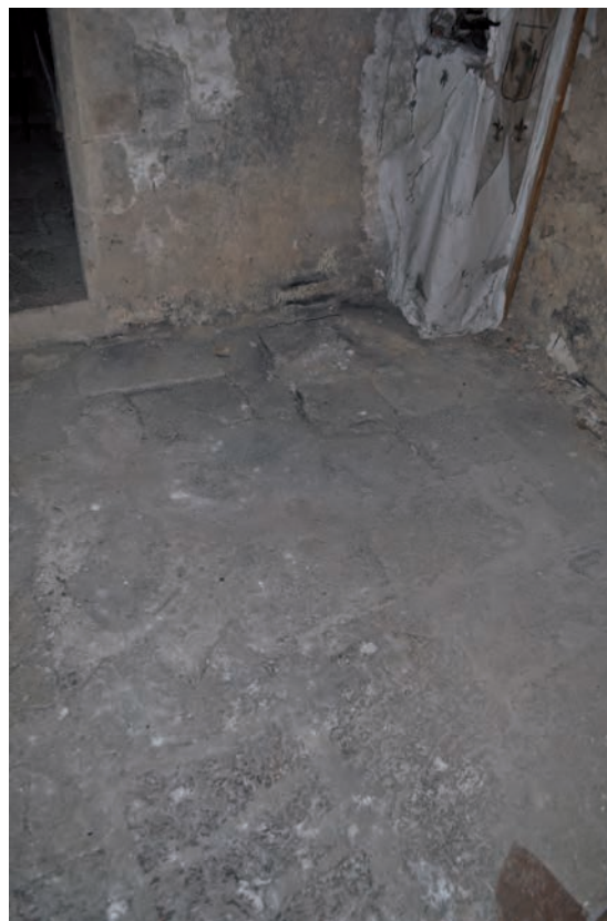
Fig. 246: Sol composite à l'angle sud-ouest de la salle 5
