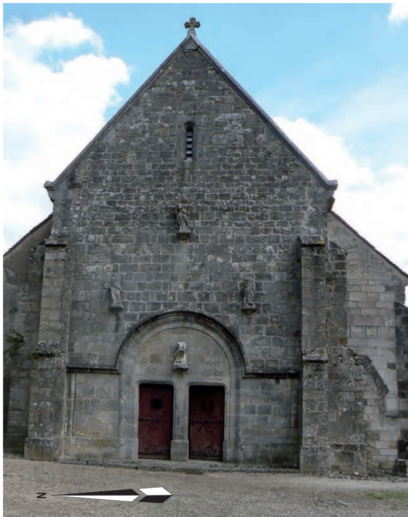
Fig. 6 : Façade construite pour fermer le chœur de l'église paroissiale après la destruction de la nef
