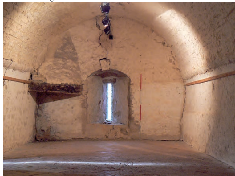
Fig. 34 : Partie occidentale de la pièce sud du second niveau
