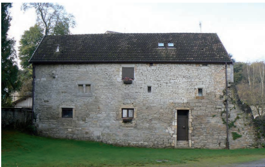
Fig. 23 : Façade nord-est du bâtiment 2
