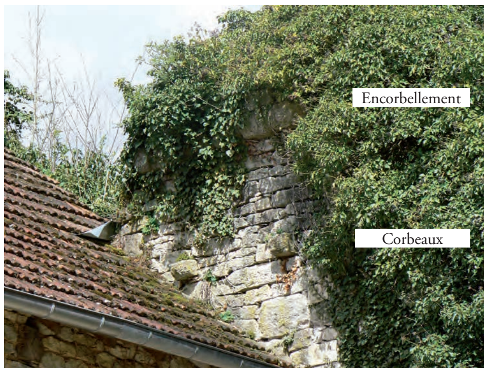
Fig. 4 : Détail de la courtine avec un rang de corbeaux et un encorbellement (fig. 1, n°3)
