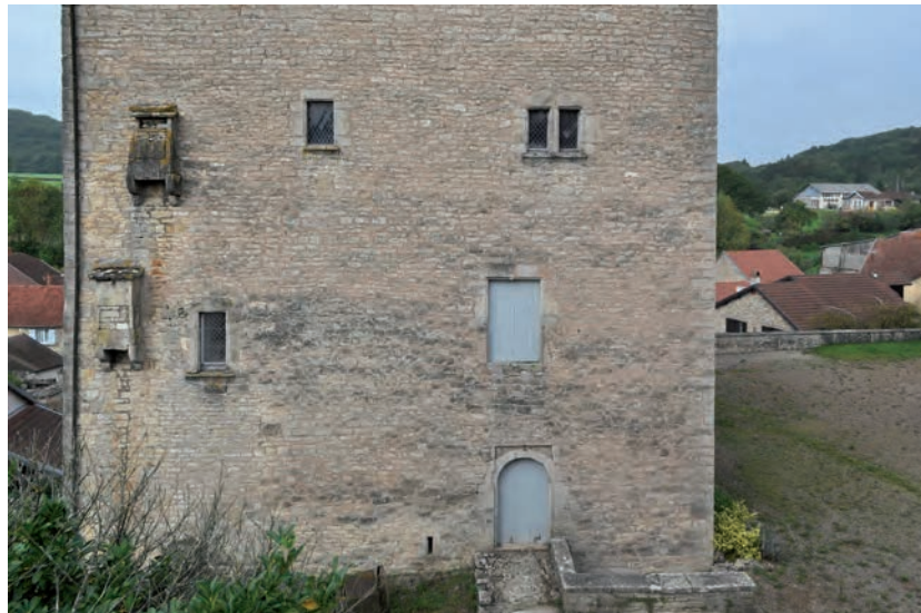
Fig. 33 : Parement extérieur est, second niveau
