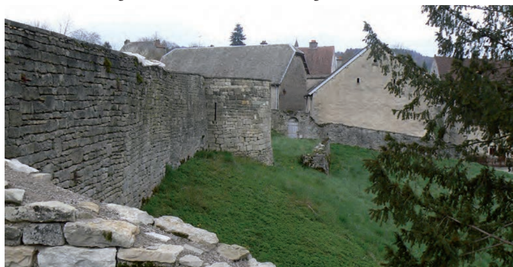
Fig. 6 : Tour d'artillerie sud-est fig. 1, n°5), vue de l'ouest, et fossé méridional
