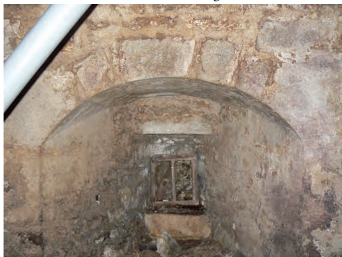
Fig. 12 : Niche de tir du petit vaisseau nord
