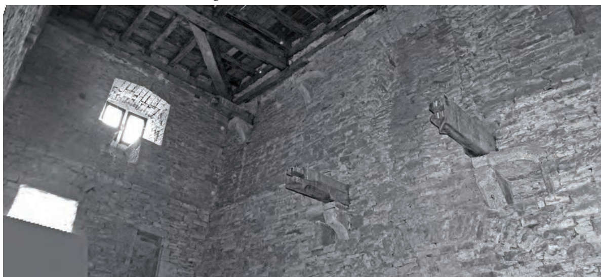
Fig. 70 : Angle sud-est du 5 e niveau (assemblage photographique)
