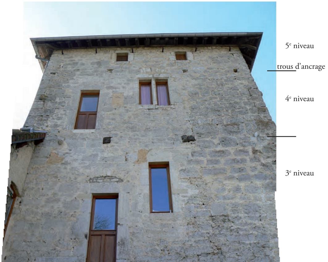
Fig. 21 : Façade nord de la tour pentagonale (montage photographique)
