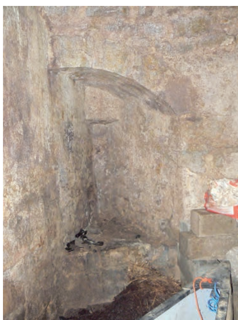
Fig. 14 : Ouverture ouest du petit vaisseau sud, obstrué par un contrefort
