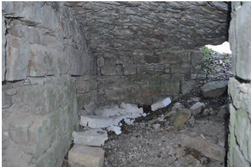
Fig. 11 :Chambre de tir photographiée depuis son couloir d'accès. L'ouverture est complètement désaxée pour des raisons évidentes de défense
