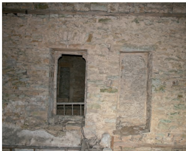
Fig. 53: Portes du mur de refend du quatrième niveau
