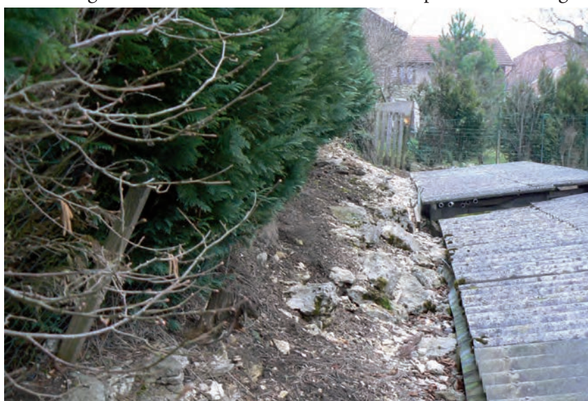
Fig. 7 : Courtine occidentale du bourg
