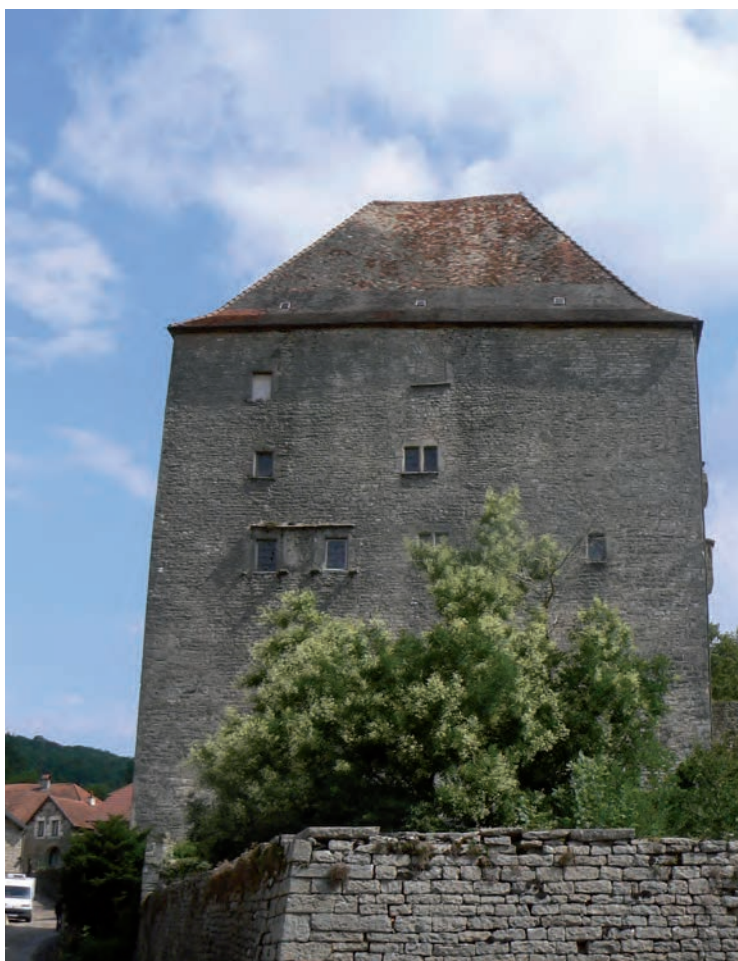
Fig. 46 : Façade méridionale de la tour maîtresse
