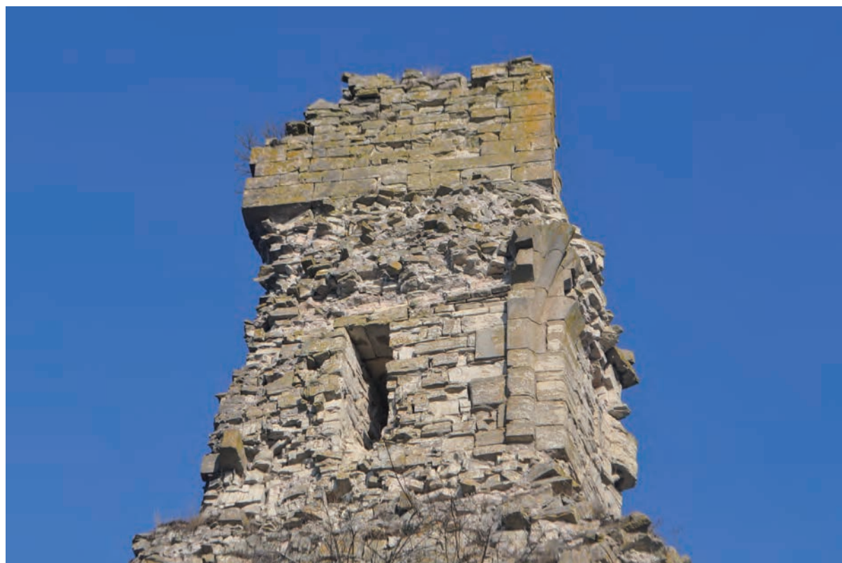
Fig. 19: Détail des quatrième et cinquième niveaux
