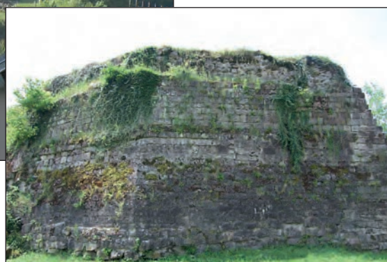
Fig. 9 : Détail de la courtine orientale
