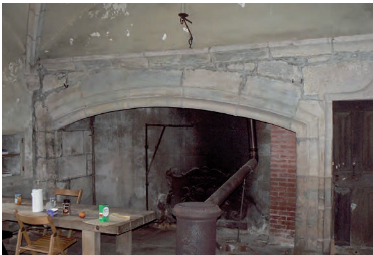
Fig. 22 : Cheminée de la cuisine du corps de logis
