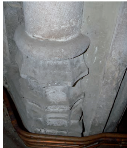
Fig. 23 : Base de cheminée de la pièce est
