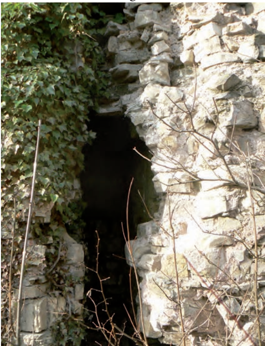
Fig. 16: Conduit maçonné. À gauche, le blocage apparaît en raison de l'arrachement du parement extérieur. À droite, vue intérieur du conduit, maçonné en moellons
