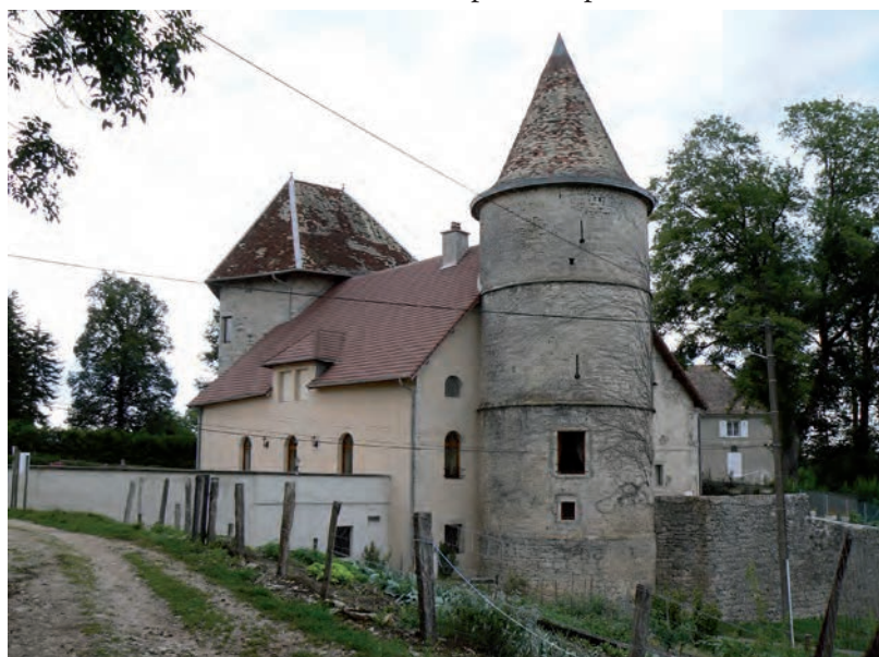
Fig. 12 : Vue sur la tour circulaire et la tour pentagonale
