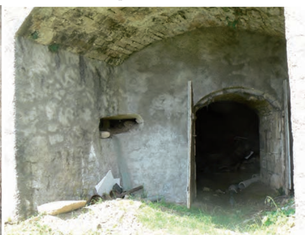
Fig. 17 : Porte et canonnière du vaisseau sud
