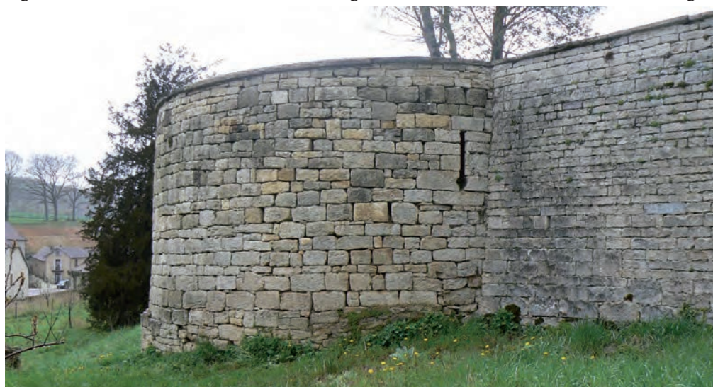
Fig. 5 : Tour d'artillerie sud-est (fig. 1, n°5), vue de l'est
