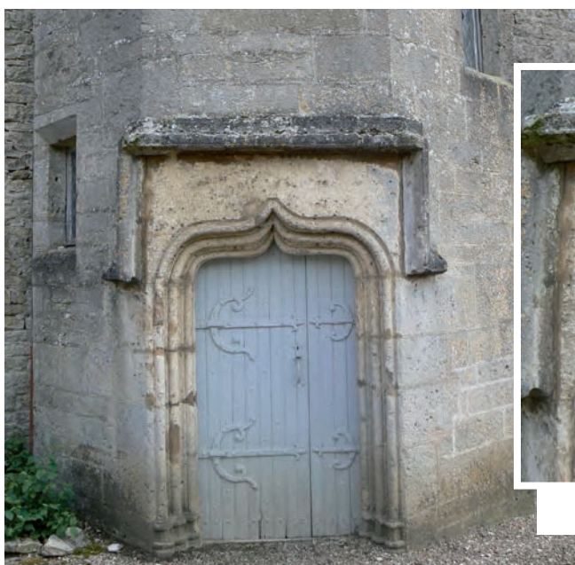
Fig. 72 : Porte de la tourelle d'escalier
