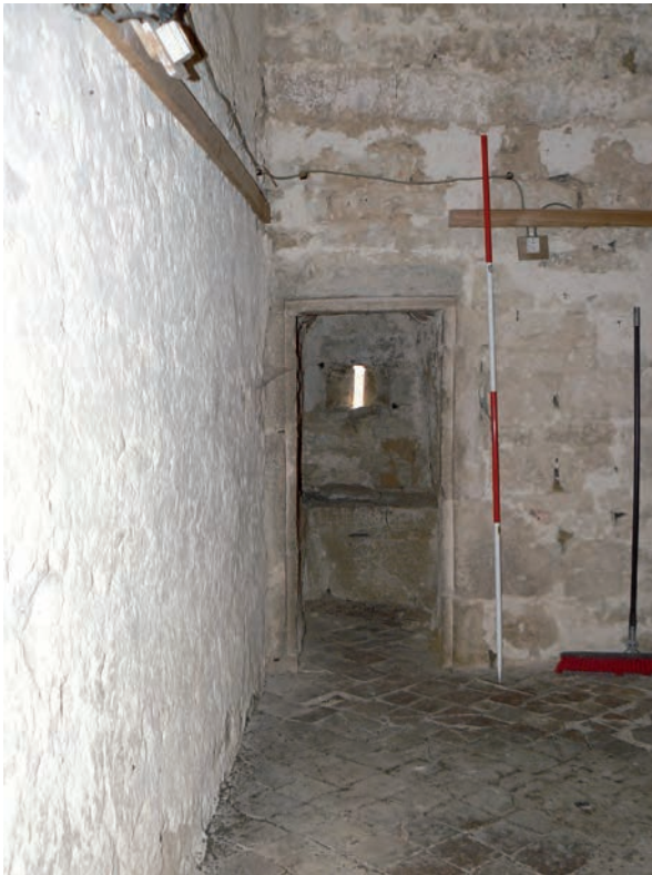
Fig. 35 : Latrines du 2 e niveau
