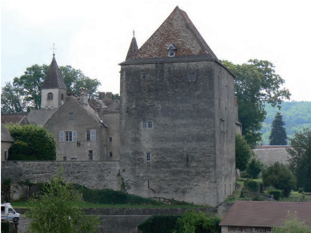
Fig. 8 : Façade occidentale du donjon
