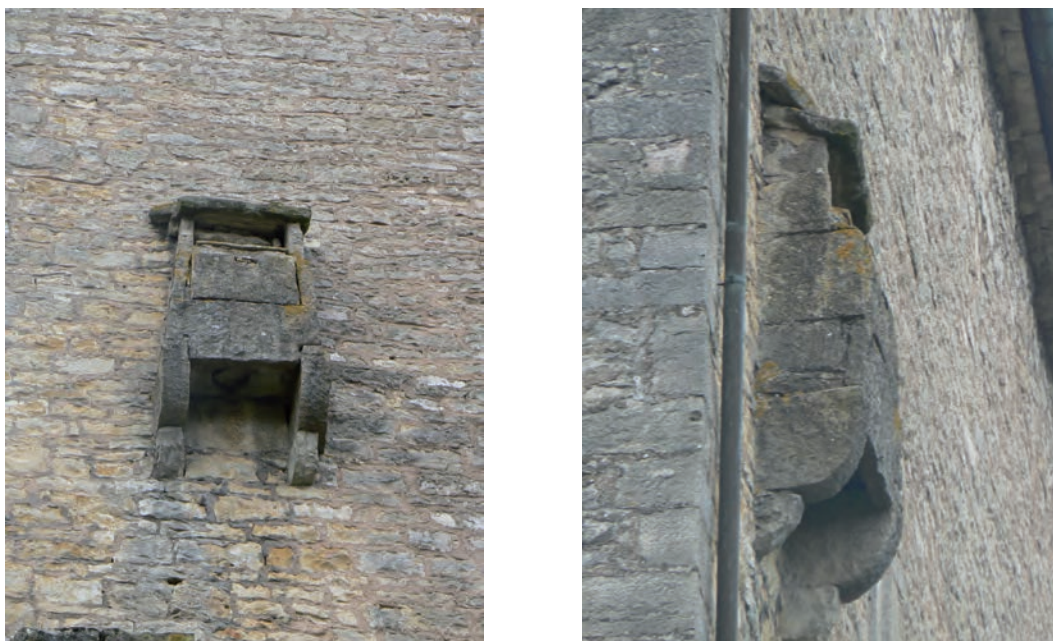
Fig. 61: Détail des latrines en encorbellement au 4 e niveau
