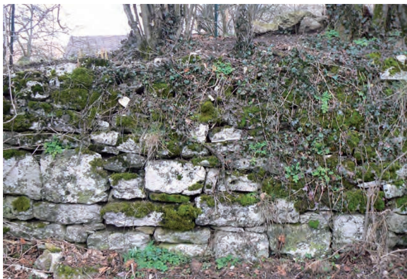
Fig. 8 : Portion de courtine remployée en mur de soutènement
