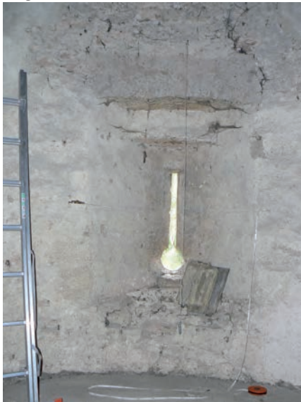
Fig. 25 : Archère-canonnière sud du 3 e niveau
