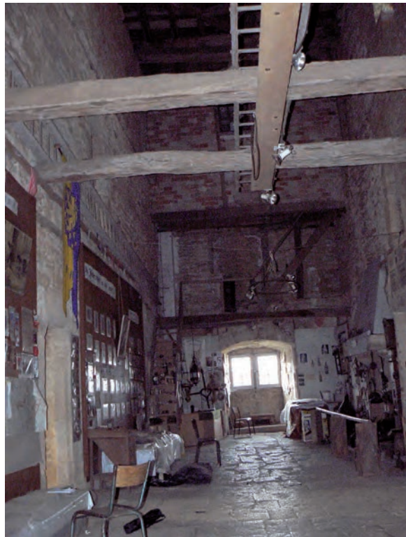
Fig. 41 : Pièce nord du 3 e niveau (vers l'ouest)
