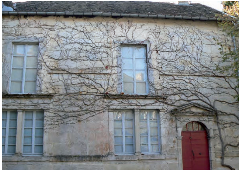
Fig. 12: Bâtiment oriental du château (façade sur cour)
