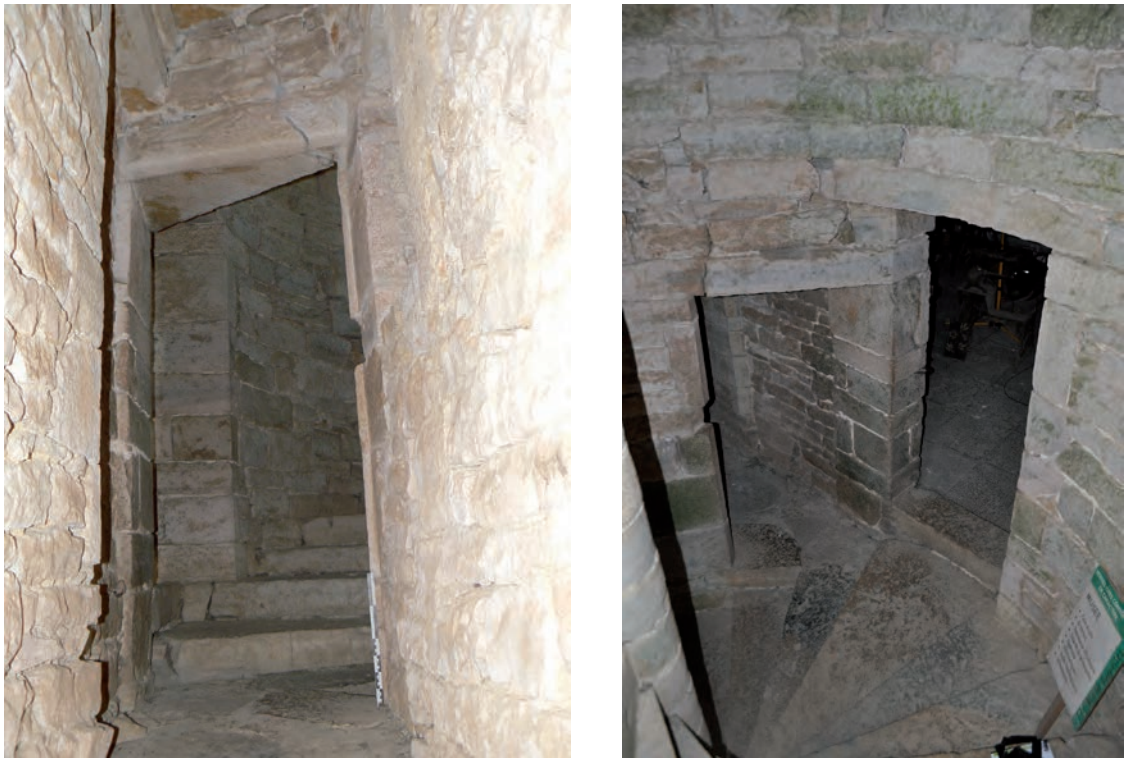
Fig. 76: Jonction de l'escalier intra-pariétal et de la tourelle d'escalier
