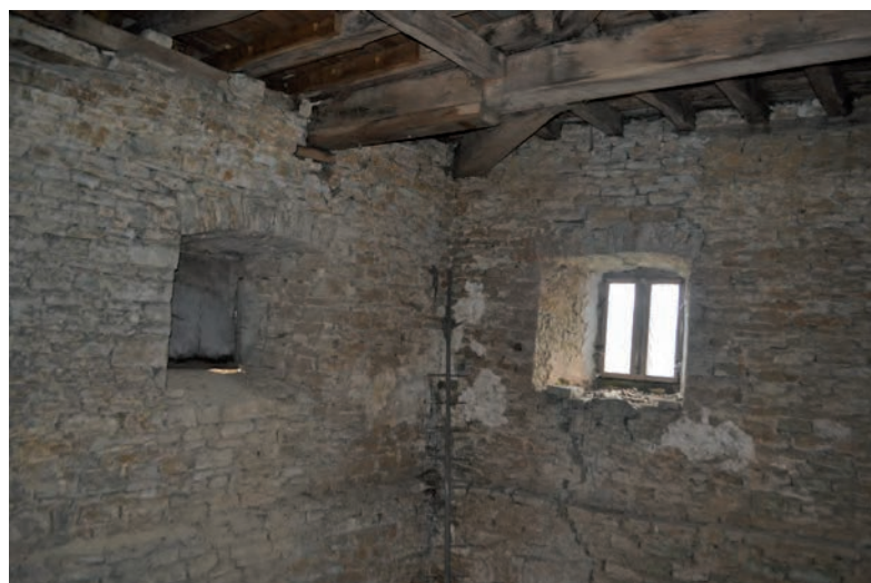
Fig. 67 : Angle sud-ouest du 5 e niveau
