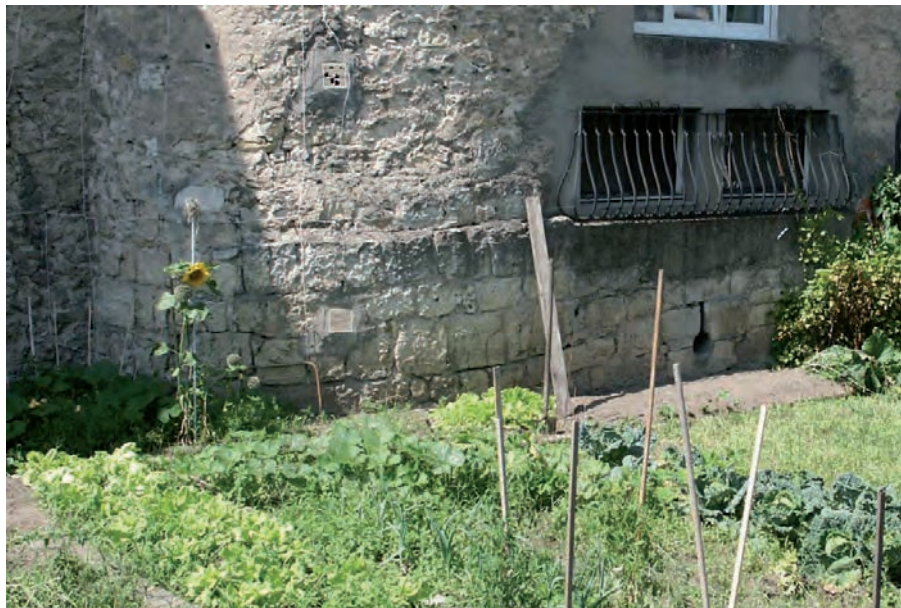
Fig. 28: Canonnière de la tour dite du Chertemps (cliché C. Moulis)
