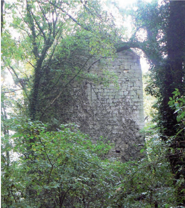
Fig. 7 : Tour carrée vue depuis le sud
