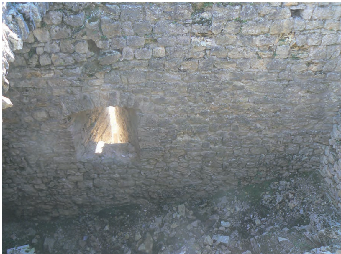
Fig. 10 : La même archère vue depuis la plate forme sommitale à l'intérieur du château
