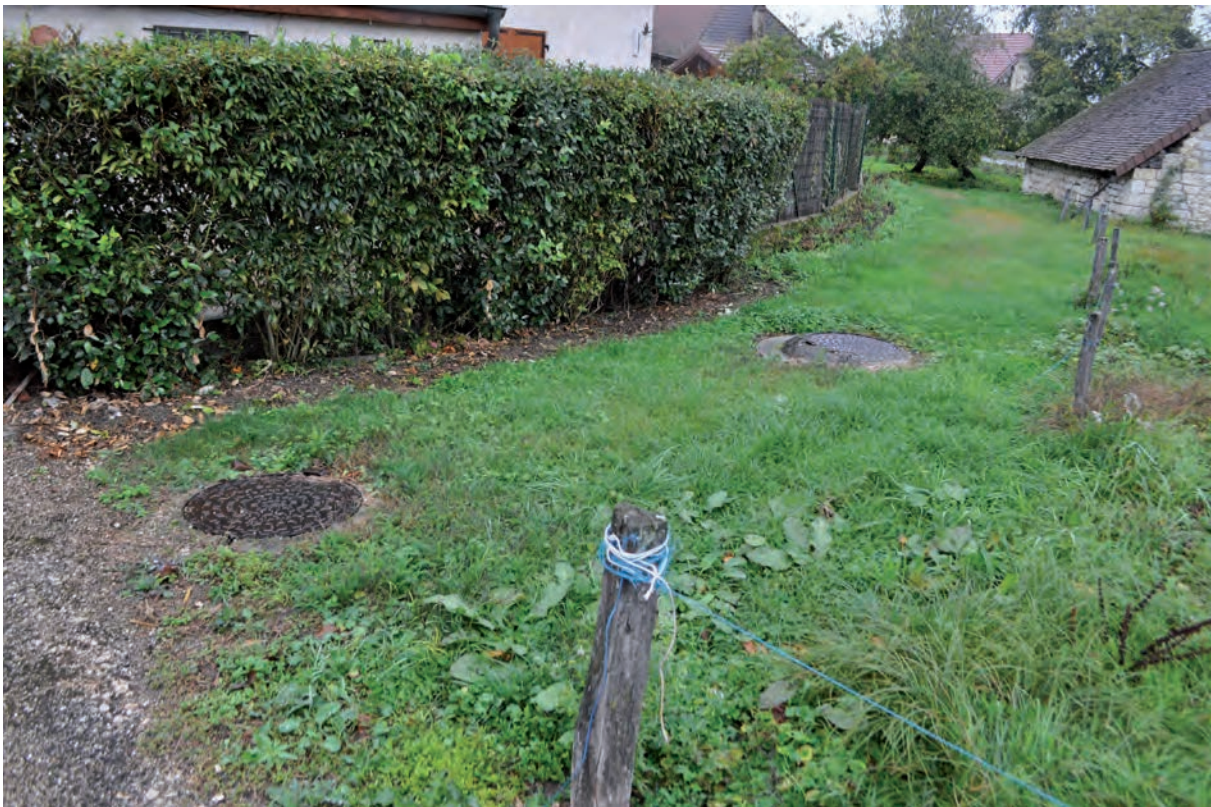
Fig. 2 : Le chemin occupé par les égouts correspond à l'ancien fossé
