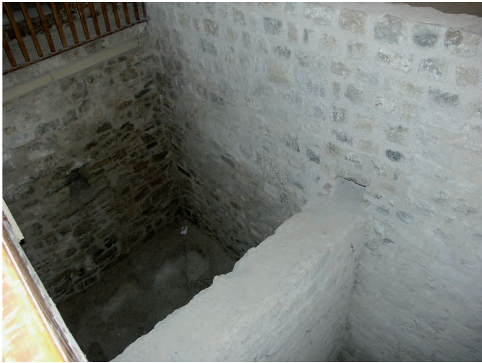
Fig. 23: Fosse et pile du pont-levis (cliché C. Moulis)
