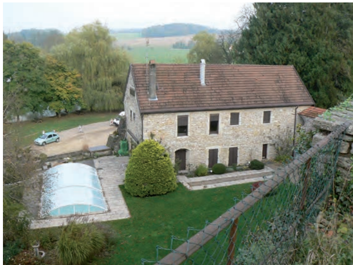
Fig. 22 : Façade sud du bâtiment 2
