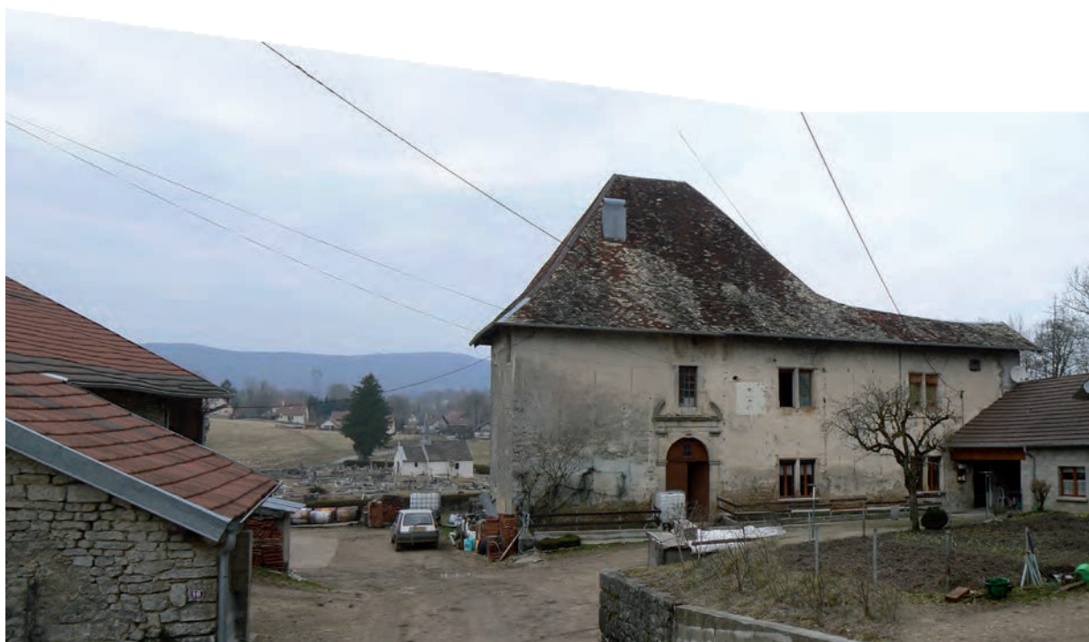
Fig. 15 : Édifice du XVII e siècle (montage photographique)
