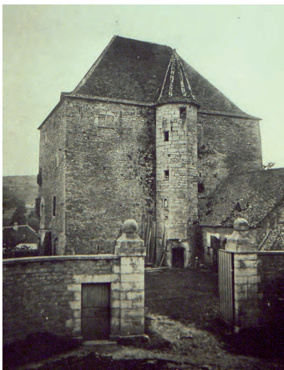
Fig. 43 : Photographie ancienne, façade nord (château de Fondremand)
