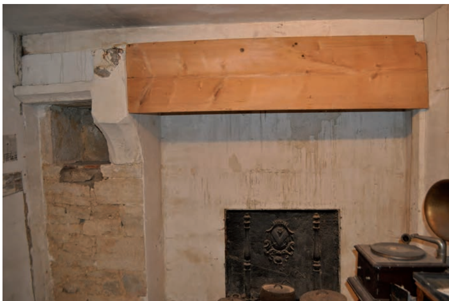
Fig. 47 : Cheminée orientale de la façade sud, 3 e niveau
