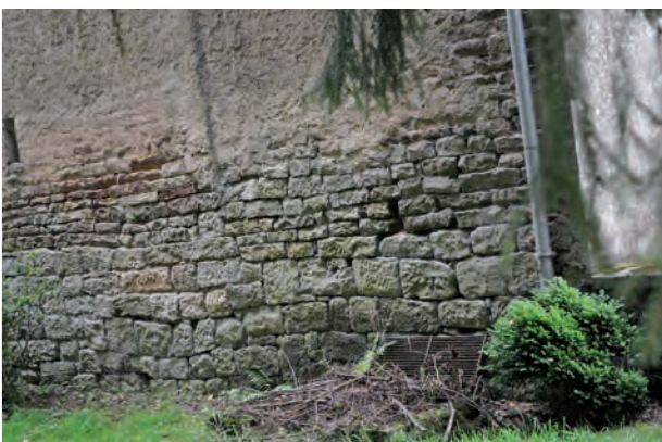
Fig. 21 : Bâtiment de la parcelle 543
