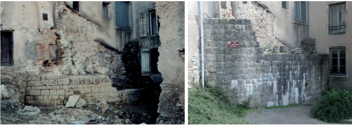
Fig. 27: État initial (1990) et restitution (2004) de la tour de la porte d'en haut (cliché C. Moulis)
