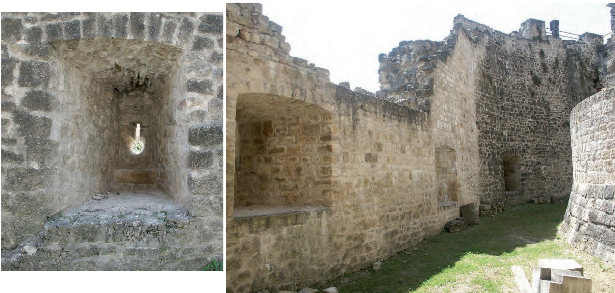
Fig. 12 : Vue de la chemise d'artillerie (L2) depuis l'intérieur et détail d'une canonnière (cliché C. Moulis)
