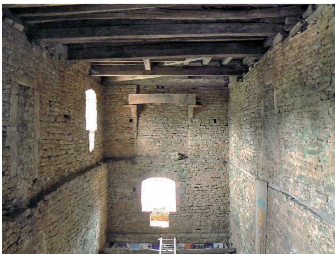
Fig. 62: Partie nord du 4 e niveau, côté oriental
