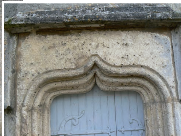
Fig. 73 : Détail du linteau
