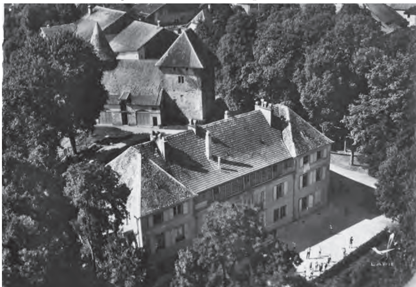
Fig. 11 : Détail du château : bâtiment du XIX e s. au premier plan et tours médiévales à l'arrière-plan
