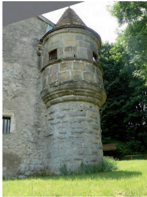
Fig. 21 : Tourelle du bâtiment 1
