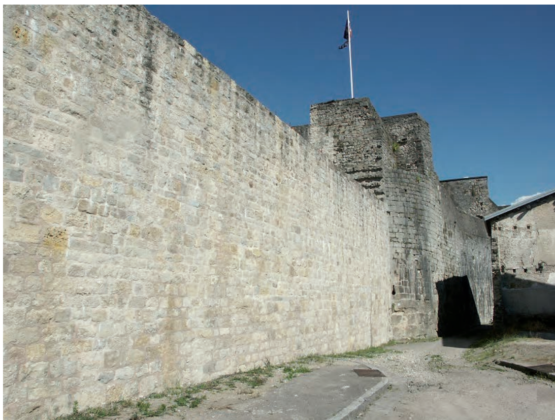
Fig. 14 : Courtine extérieure au sud-ouest (L1). L'inflexion à l'arrière plan correspond à une galerie d'artillerie (cliché C. Moulis)
