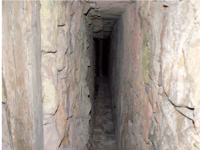
Fig. 15: Gaine de herse dans la façade nord du bâtiment occidental
