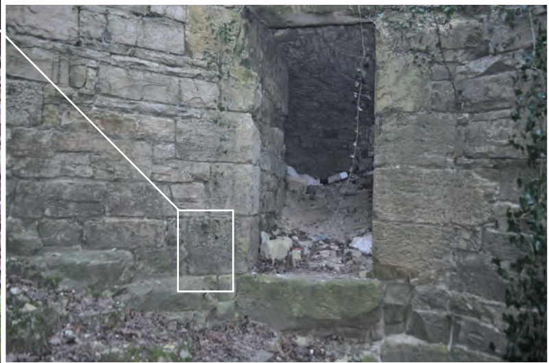
Fig. 10: Détail du chanfrein et du congé de la porte de la salle nord
