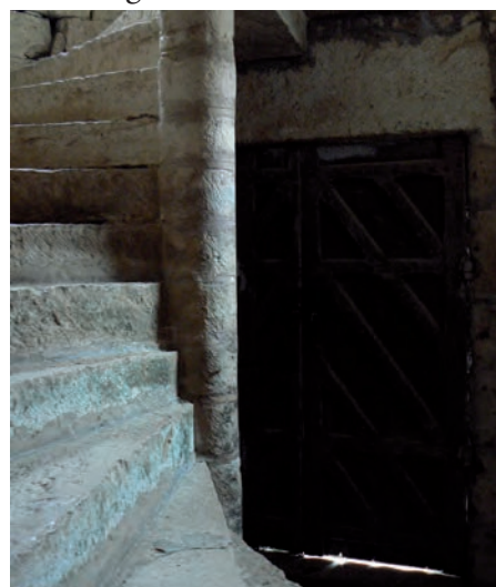
Fig. 74 : Détail de l'escalier en vis
