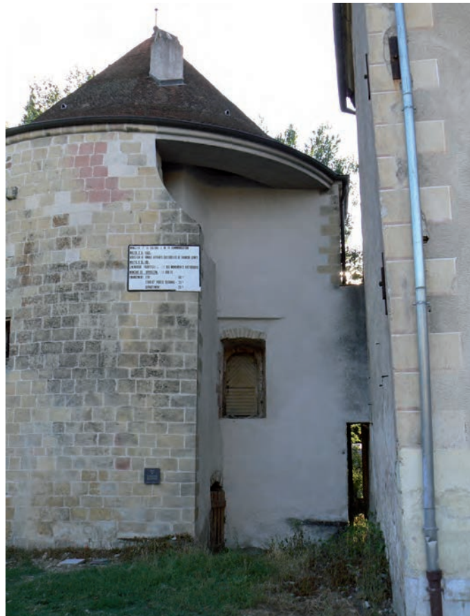
Fig. 4 : Détail du négatif de l'angle de l'enceinte et pan coupé de la tour
