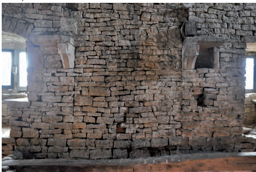
Fig. 54: Cheminée occidentale du mur sud, 4 e niveau
