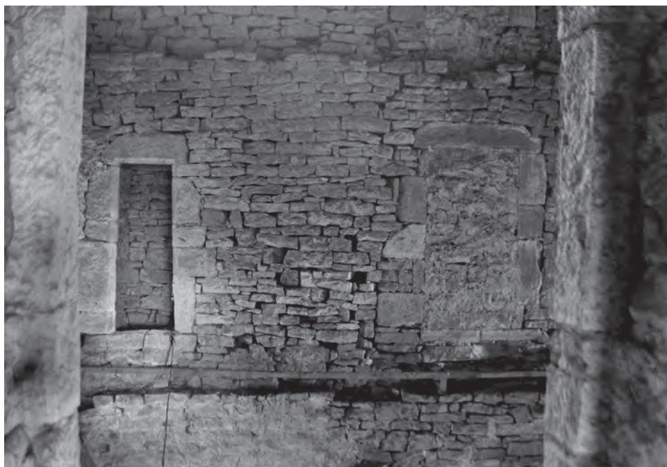
Fig. 63: Portes d'accès au 4 e niveau
