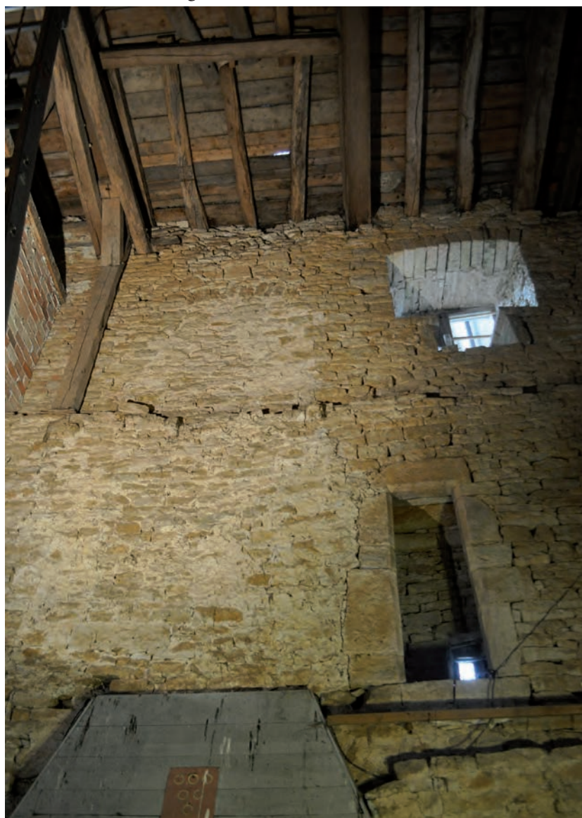
Fig. 64: Conduit de cheminée des 4 e et 5 e niveaux
