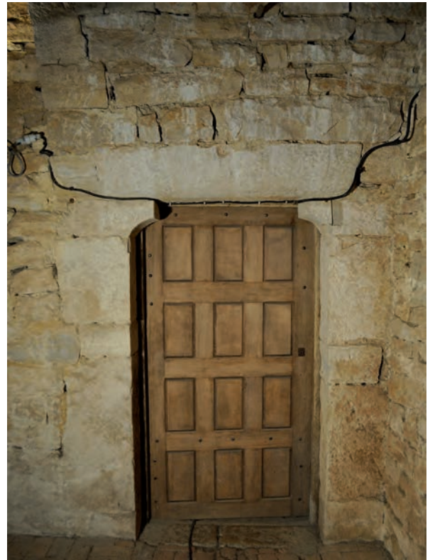
Fig. 36 : Porte du vestibule vers la pièce sud, 2 e niveau
