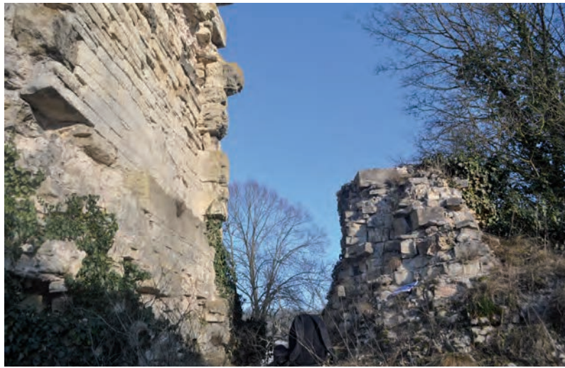
Fig. 15: Détail de la niche de la fenêtre nord du second niveau
