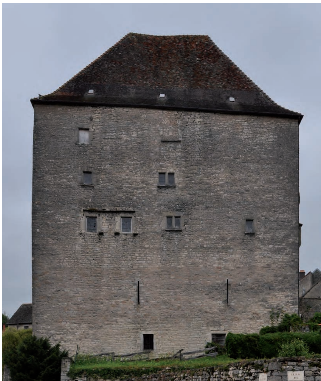
Fig. 58 : Façade méridionale de la tour
