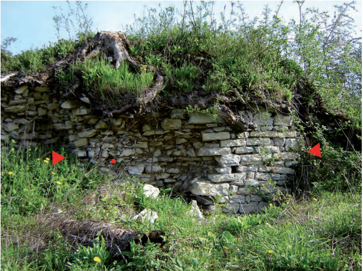
Fig. 9 : Maçonneries du mur sud avec assise de réglage (triangles) et localisation du charbon de bois prélevé (cercle)
