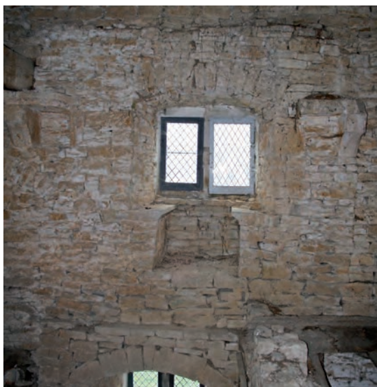
Fig. 52: Baie à meneau centrale, 4 e niveau, façade sud
