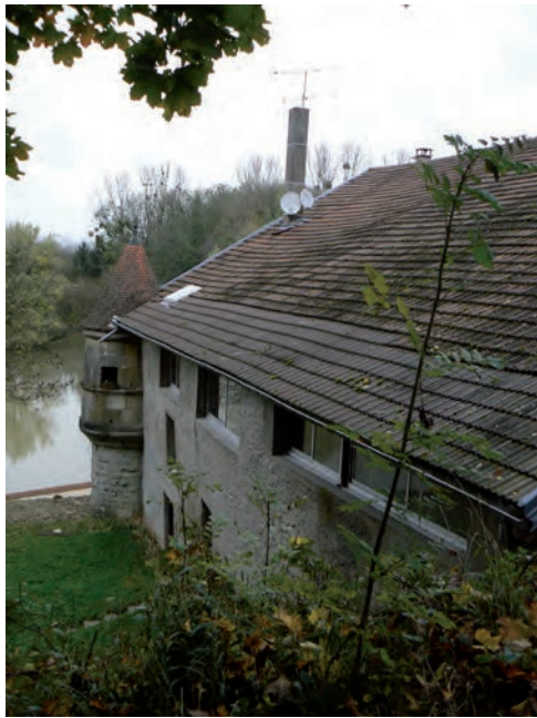
Fig. 20 : Façade occidentale du Bâtiment 1
