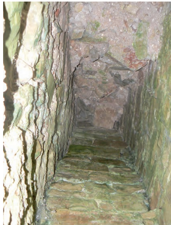
Fig. 16: Conduit maçonné. À gauche, le blocage apparaît en raison de l'arrachement du parement extérieur. À droite, vue intérieur du conduit, maçonné en moellons
