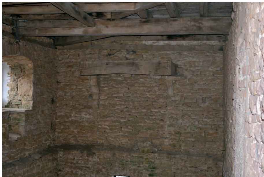
Fig. 66 : Pièce nord du 5 e niveau, côté est
