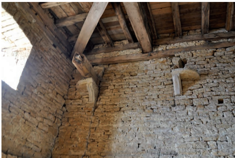
Fig. 71 : Détail de la cheminée sud-est (5 e niveau)
