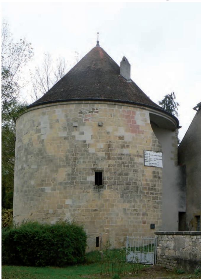
Fig. 3 : Vue générale de la tour depuis le sud-est. En blanc, les blocs remplacés lors de la restauration
