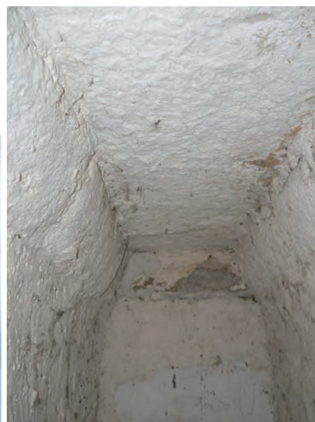
Fig. 45 : Accès aux latrines, 3° niveau
