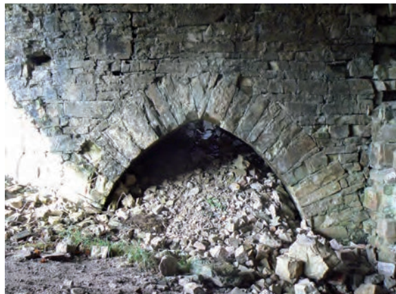
Fig. 13 : Ouverture occidentale de la salle voûtée sud. Sous l'arc brisé, les remblais comblant la pièce nord
