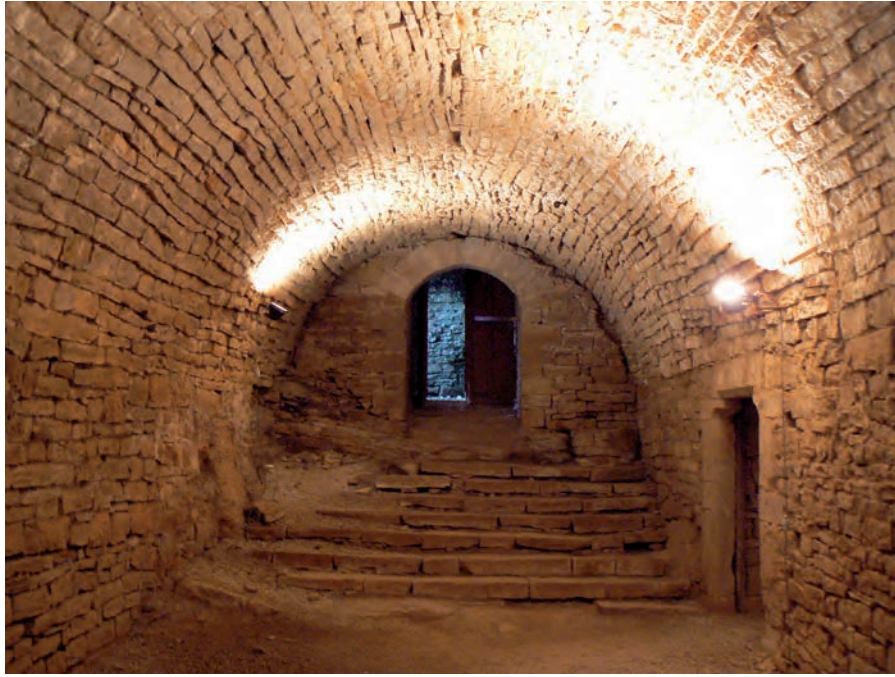
Fig. 29 : Salle nord du 1 er niveau (vers l'est)
