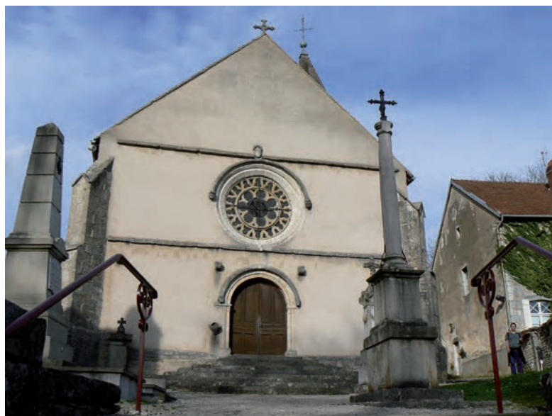
Fig. 10 : Façade de l'église de Fondremand
