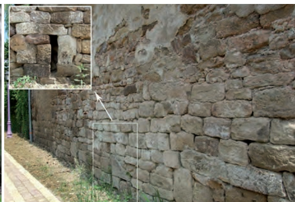
Fig. 22 : Bâtiment de la parcelle 548
