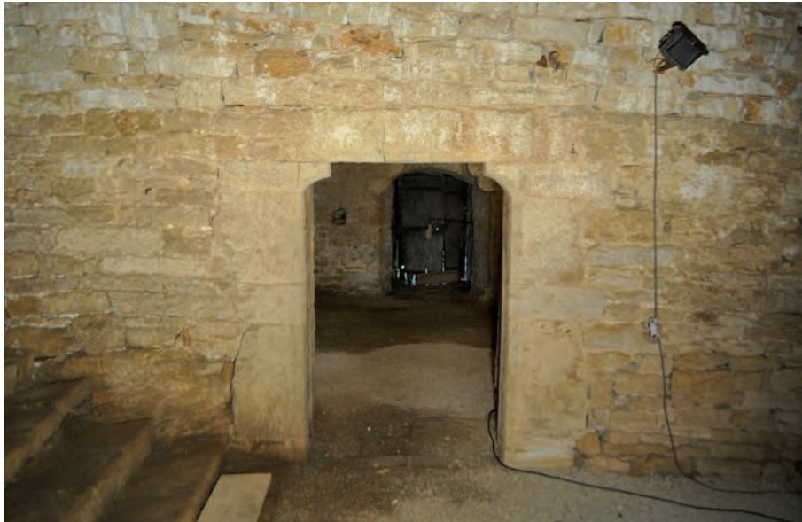
Fig. 30 : Porte du mur de refend (1 er niveau)
