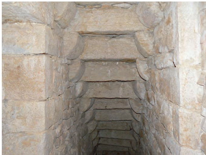
Fig. 31 : Couvrement de l'escalier intra-pariétal
