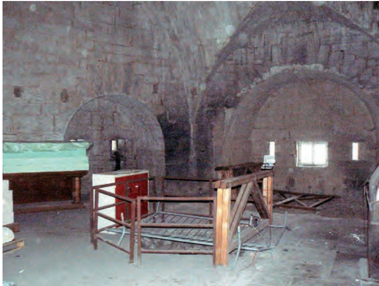
Fig. 14 : Salle du puits
