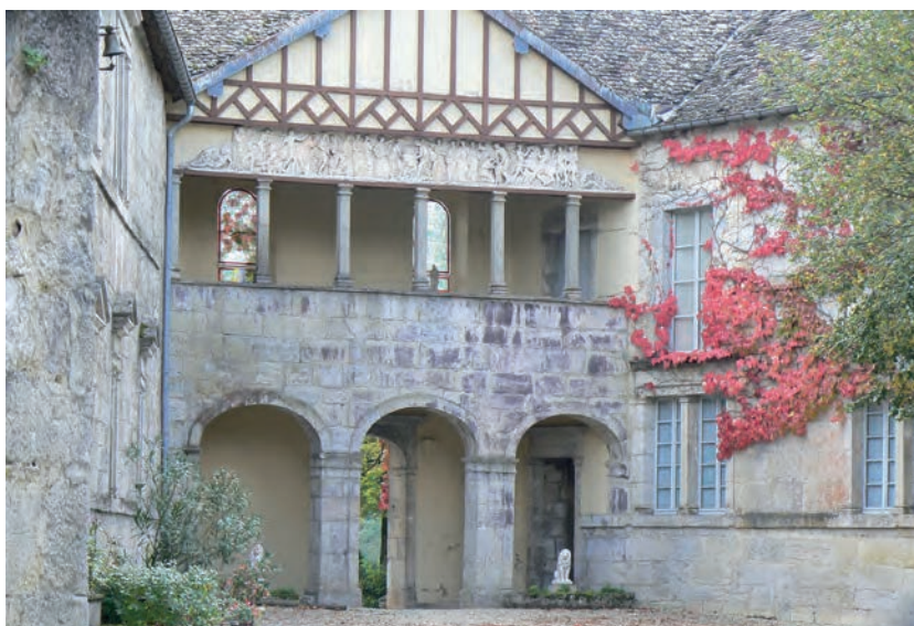
Fig. 11: Galerie sur cour du château
