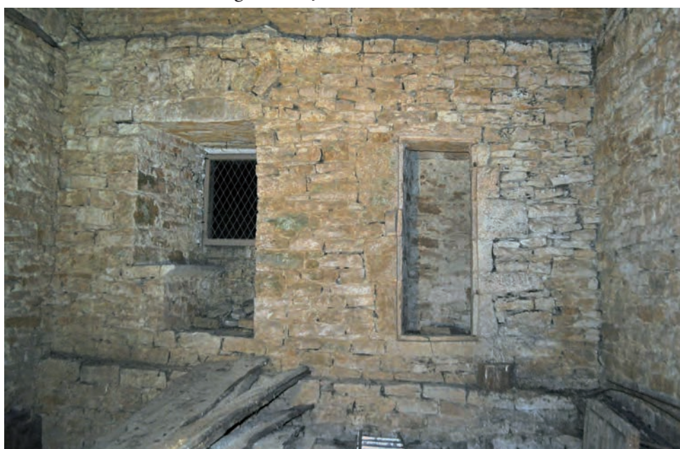
Fig. 60 : Mur orientale du 4 e niveau, baie à coussiège à gauche, accès aux latrines à droite
