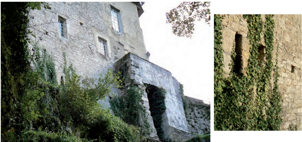
Fig. 17: Bâtiment occidental avec entrée de la poterne et détail du parement extérieur des archères
