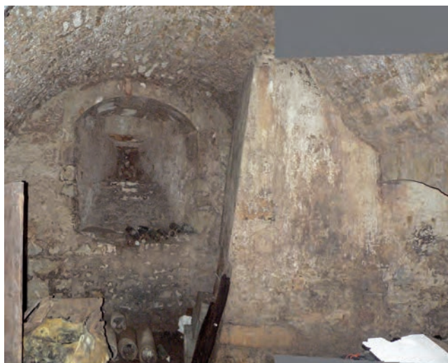
Fig. 15 : Contrefort et ouvertures ouest et sud du petit vaisseau sud
