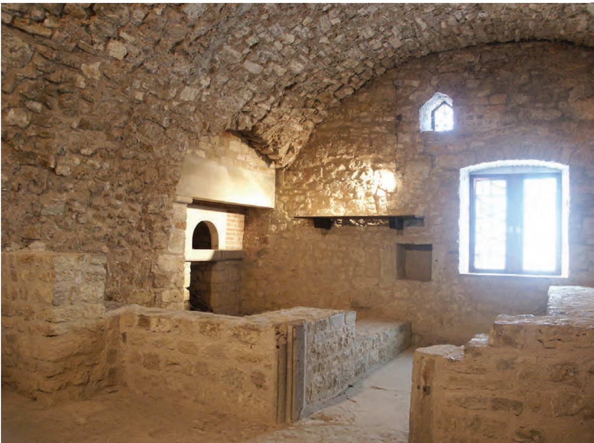
Fig. 85: La boulangerie après restauration (cliché C. Moulis)
