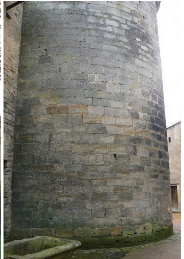
Fig. 61 b : Exemples de constructions en pierre de taille (en bas) ou moellons (en haut) de moyen à grand module. En bas à gauche : Amance, à droite : la tour des Lombards de Fontenoy ; en haut, la tour sud-est de l'enceinte urbaine de Neufchâtel Les triangles indiquent des assises de réglage
