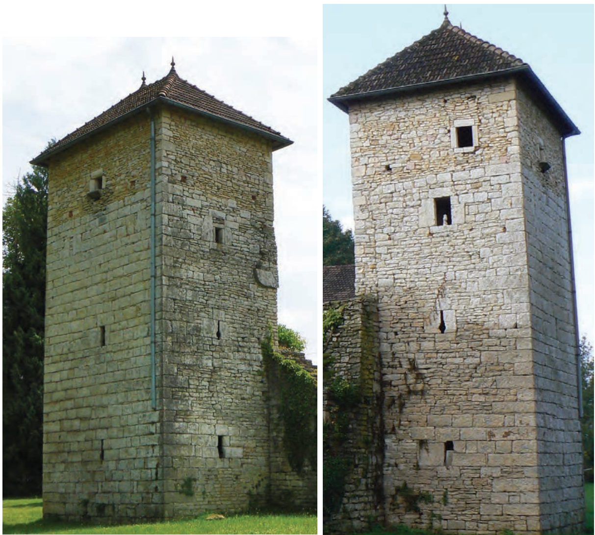
Fig. 103b : Tour carrée de l'enceinte basse de Chemilly (XV e s.).
