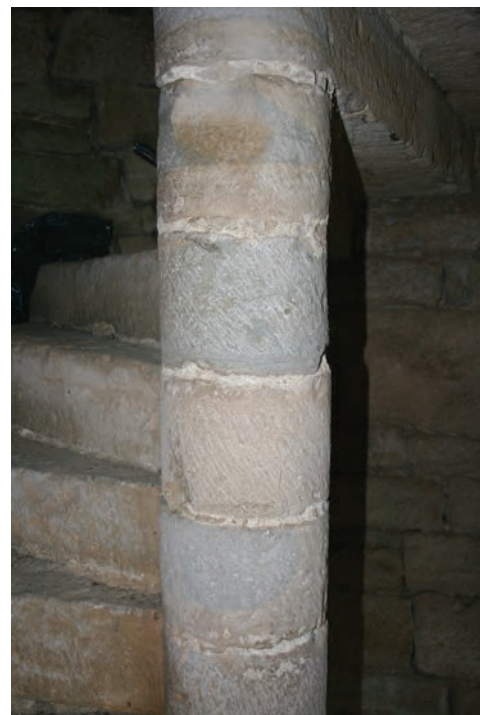
Fig. 63: Quelques traces d'outils, à gauche: Fontenoy (tour des Lombards en bas et château en haut), à droite: noyau de la vis de la tourelle d'escalier de Fondremand et détail d'une taille brettelée
