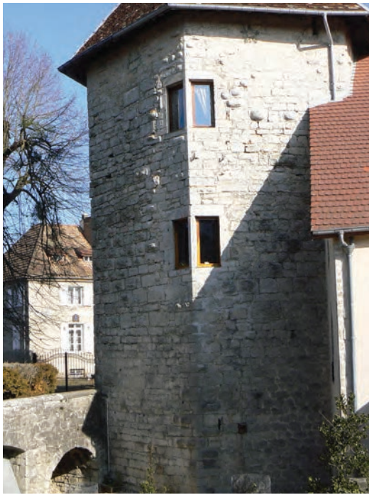
Fig. 62: Un usage rare de la pierre à bossage. Bouclans, à gauche; Fontenoy, à droite (cliché G. Giuliano)
