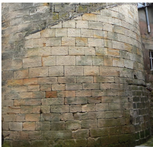
Fig. 63: Quelques traces d'outils, à gauche: Fontenoy (tour des Lombards en bas et château en haut), à droite: noyau de la vis de la tourelle d'escalier de Fondremand et détail d'une taille brettelée
