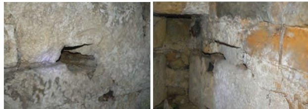
Enceinte urbaine d'Amance, embrasure et détail des dispositifs de calage
