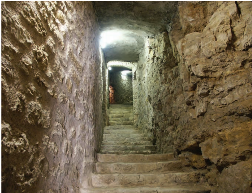
Fig. 66: Deux exemples de construction à flanc de roche, à Neufchâtel (en haut) et Châtel-sur-Moselle (en bas)
