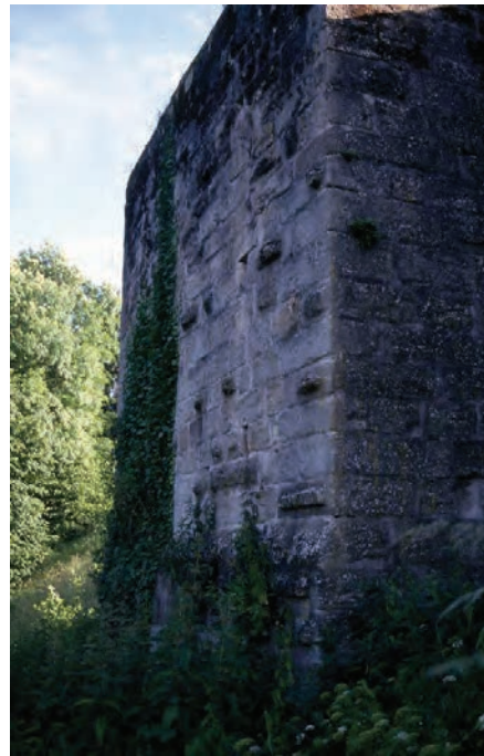
Fig. 62: Un usage rare de la pierre à bossage. Bouclans, à gauche; Fontenoy, à droite (cliché G. Giuliano)
