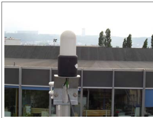
FIGURE 4.9 – Photographie du pluviomètre installé sur la toiture végétalisée.
