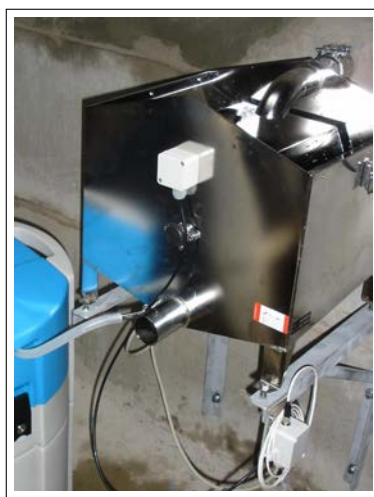
FIGURE 4.13 – Photographie du débitmètre à auget pour la mesure de la quantité d'eau sortante de chaque parcelle (Stock60, Stock40, AE et GR) à la base de chaque exutoire.
