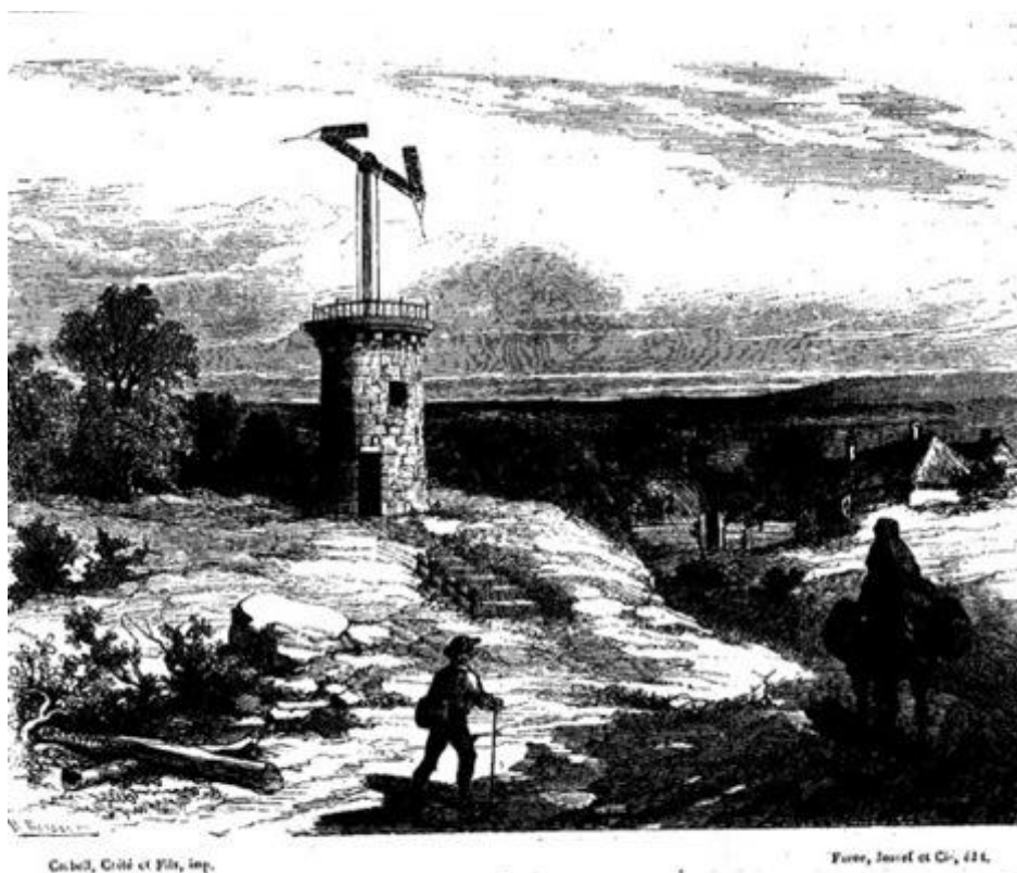
Fig. 20. — Poste de télégraphie aérienne.
