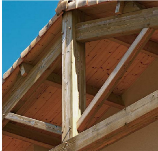
Figure 1.2 – Charpente réalisée en BMR.
