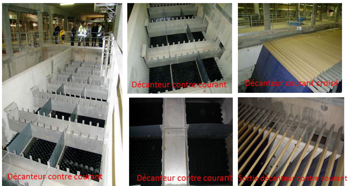
Figure III. 29 : Système de décantation (CUGN).
