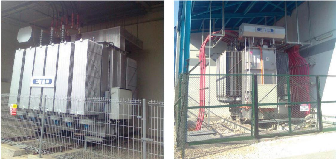
Figure 6 : Transformateurs abaisseurs du DSVC : (gauche) 33kV/2,4kV – S=55MVA ; (droite) 33kV/8kV – S=69MVA
