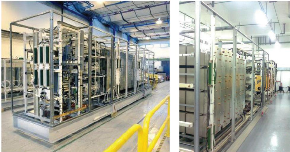
Figure 3 : (gauche et droite) Convertisseur MV7000 NPP 3-niveaux 27MVA
