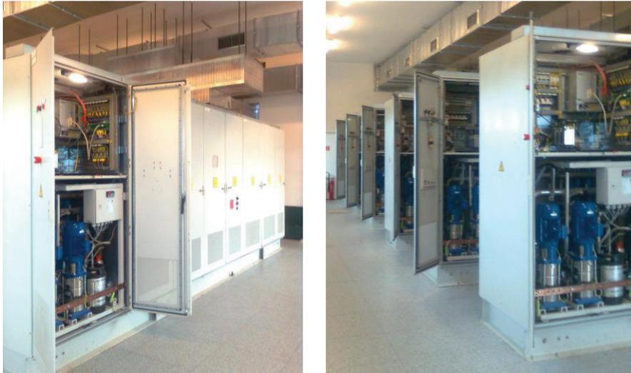
Figure 2 : Convertisseur MV7000 : (gauche) Un convertisseur NPC 3-niveaux 8MVA ; (droite) Rangées de six convertisseurs en parallèle
