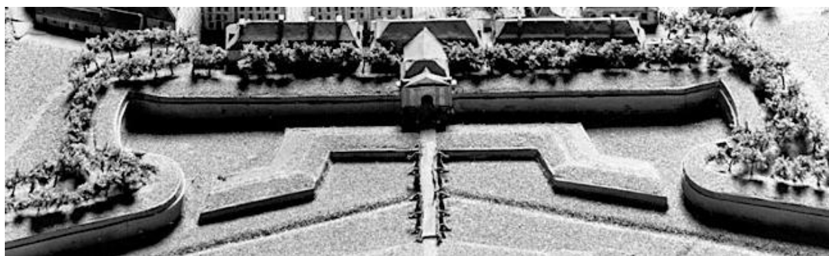
Figure 99. Une tenaille bastionnée sur le plan-relief de Huingue devant un rempart dont les flancs sont pourvus d'orillons.
