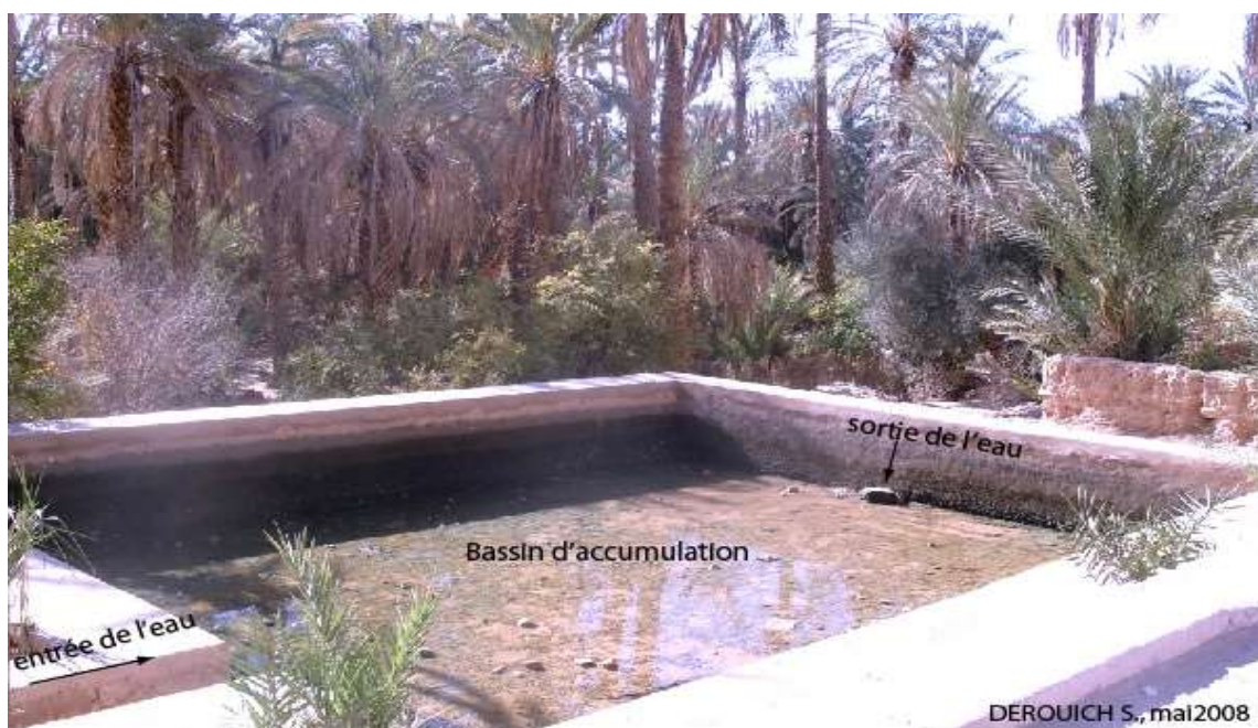
Cliché 64 : Type de bassin d'accumulation des eaux d'irrigation dans la zone d'étude
