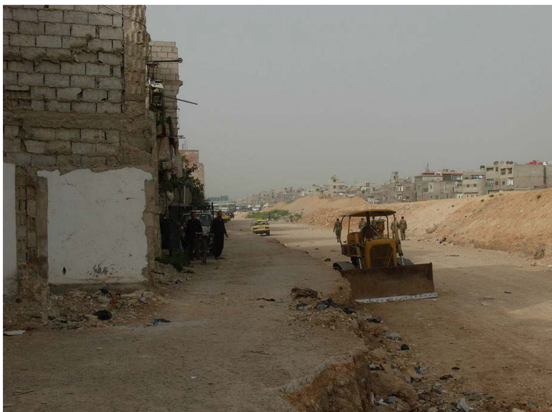
Cliché 46 : Construction de la rocade est de Damas. Elle a été réalisée entre 1998 et 2011 et a traversé plusieurs zones non réglementaires, dont Tabaleh, Dweila'a et Jobar. Elle a causé la démolition de plusieurs centaines d'unités d'habitations sur son itinéraire. Cliché : Main KAFA, Mars 2010
