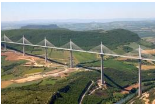
Viaduc de Millau (France)
