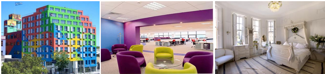
Figure 45 - La couleur à l'extérieur ou à l'intérieur du bâtiment
