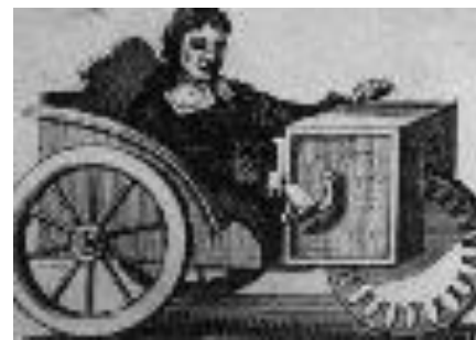
Figure 16. Fauteuil roulant à manivelles inventé par Stephan Farfler (1655).
