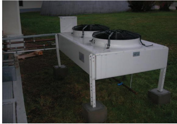
Figure 5.7 : L'aéro-réfrigérant
