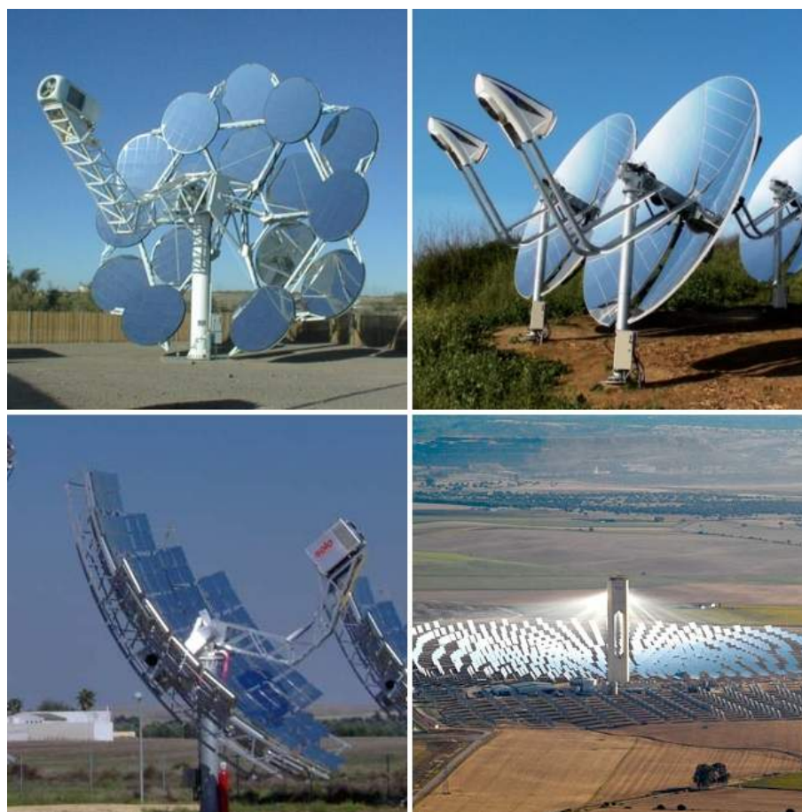
Figure 2.9 : Variantes de réflecteurs "deux axes" (de gauche à droite et de haut en bas) : Facettes "stretch-membrane" du SunDish (SAIC), "Pétales" de dish-Stirling (Infinia), facettes rigides du projet AZ-TH (Abengoa), et Tour solaire PS10 (Abengoa)
