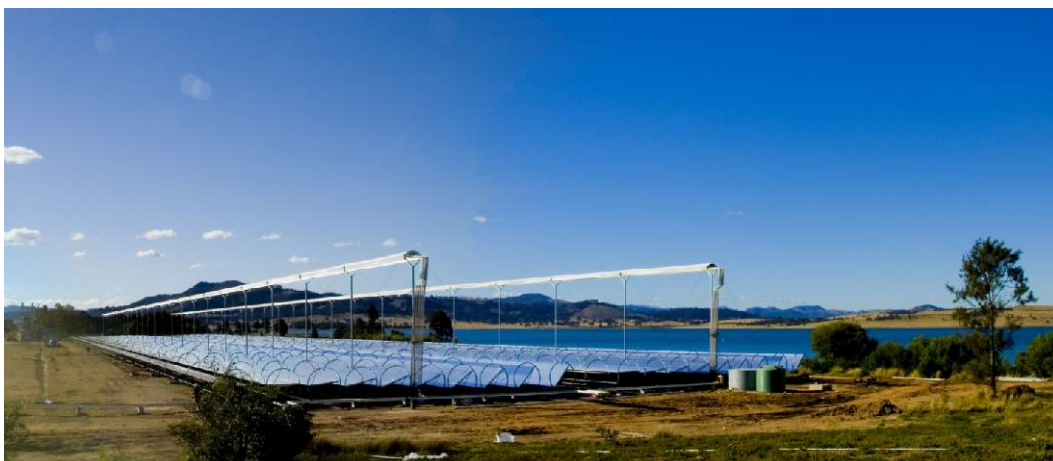
Figure 2.4 : Capteurs à CLFR utilisés pour la surchauffe de vapeur d'une centrale initialement alimentée au charbon. On note l'étendue en largeur des réflecteurs dont l'axe de pivotement est à hauteur d'homme, et les absorbeurs à renforcement optique. (Ausra)
