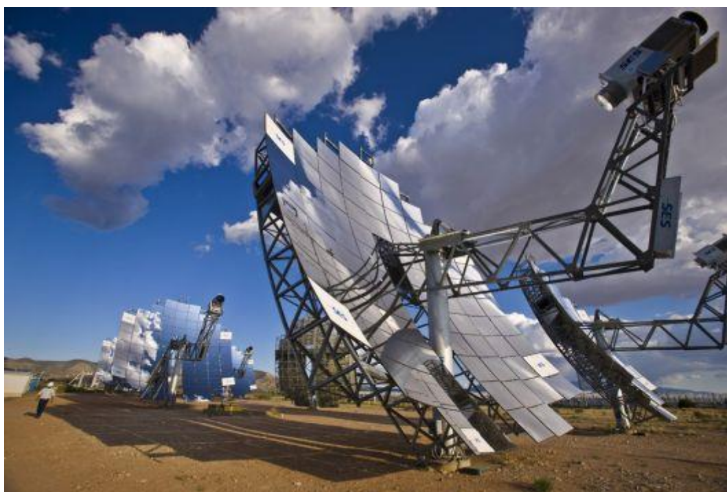
Paraboles solaires Dish-Stirling à Albuquerque, Australie
