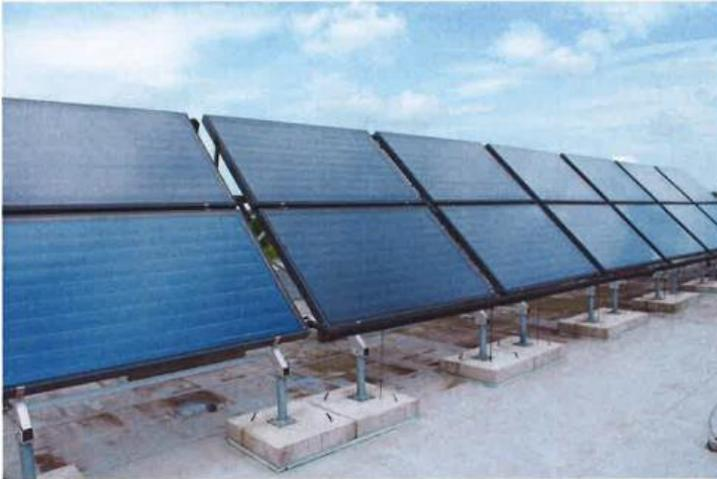
Système gravitaire permettant de protéger le liquide caloporteur en cas de surchauffe celui-ci redescend automatiquement dans le ballon, mais aussi corriger les erreurs de surdimensionnement. Ce système pourrait se passer d'eau glycolée.
