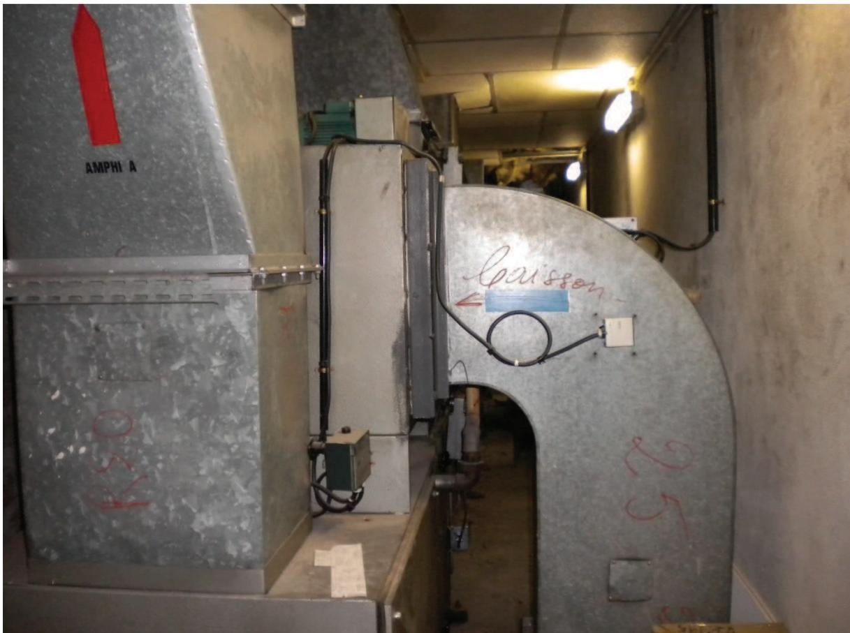
Sur cette photo, nous pouvons voir une centrale de traitement d'air où il n'est même pas possible d'effectuer l'entretien. En effet, il n'y a pas de passage possible car la centrale et les raccords encombrent toute la largeur de la pièce.
