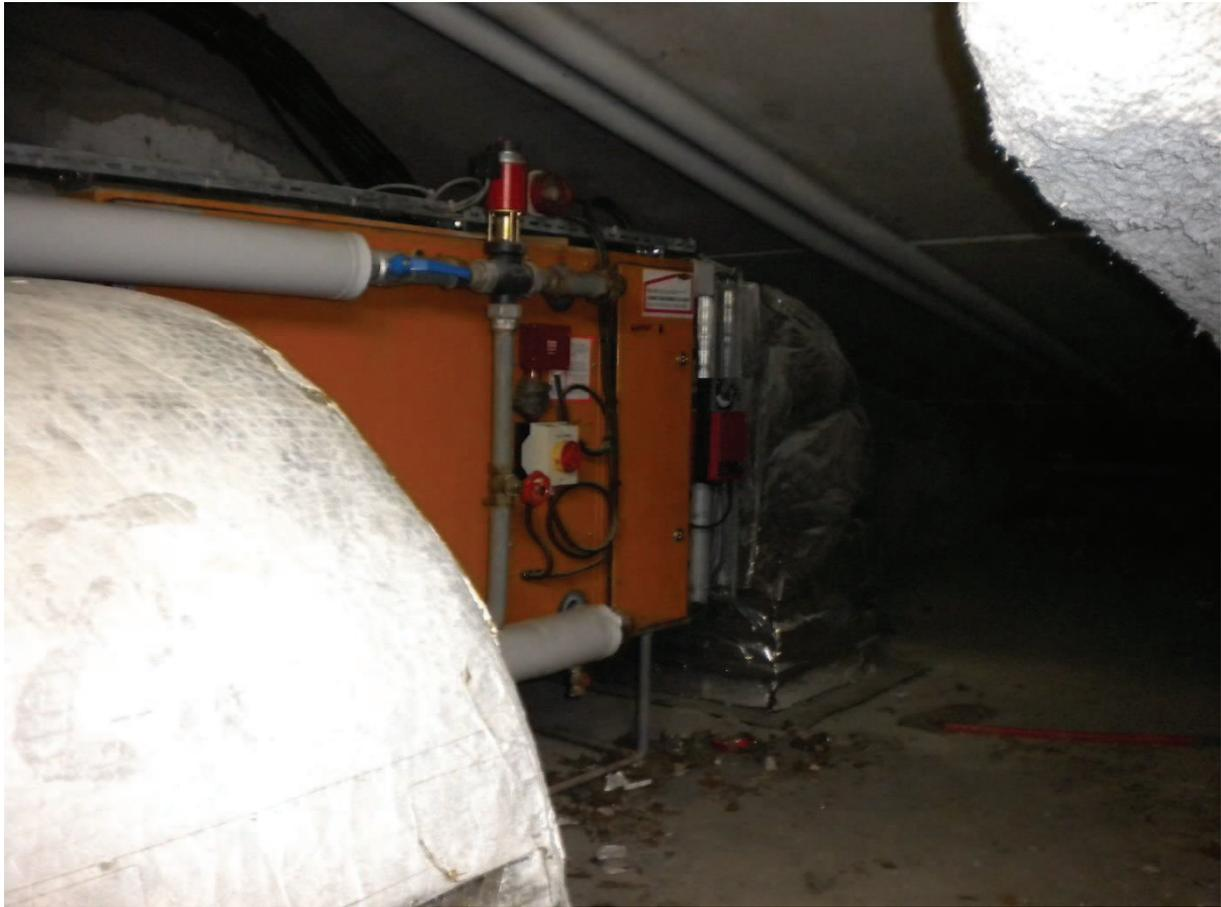
Sur cette photo, nous pouvons voir une centrale de traitement d'air placée sous les escaliers d'un amphithéâtre. Il est également compliqué d'effectuer des modifications sur ces centrales. La mise en place d'un nouveau matériel nécessitera la fourniture en pièces détachées avec le remontage sur site des équipements.
