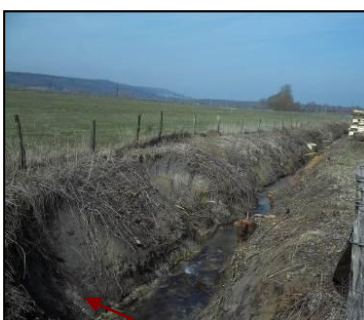
Erosion des berges en amont du Faux Moulin
