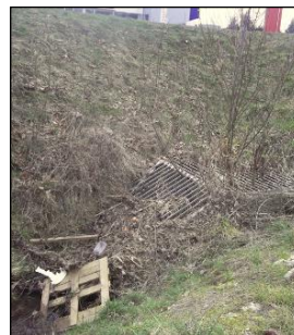
Entrée du busage du ruisseau des Embannies
