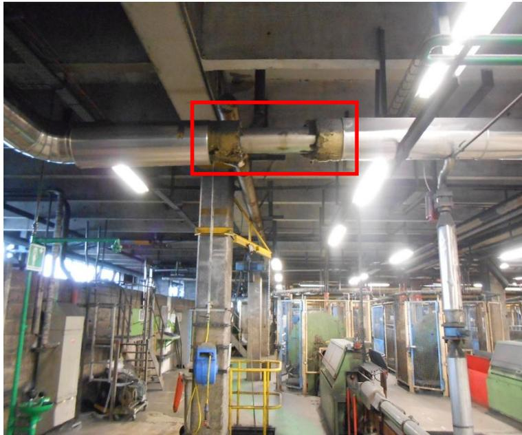
**Photo d'une canalisation non calorifugé du circuit EC DMB**
