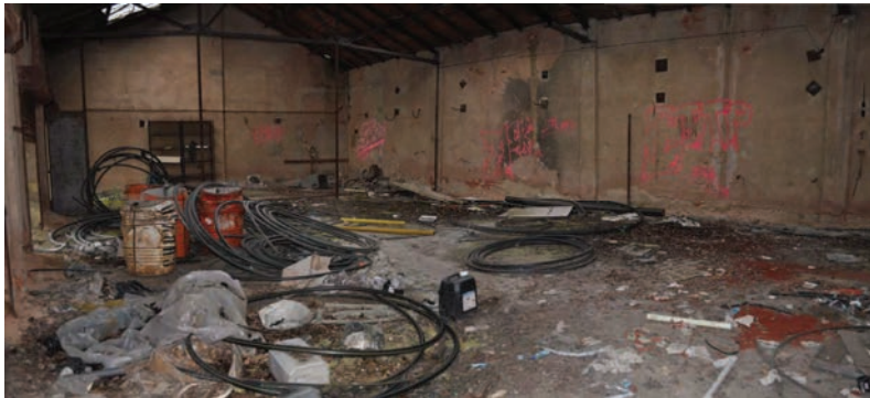
Intérieur de l'ancien atelier/magasin
