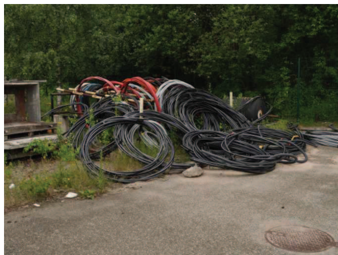
Stockage de câbles électriques
