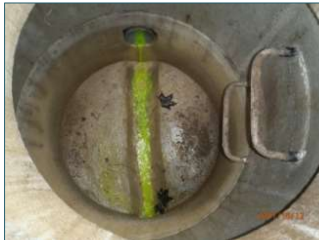
Figure 5 : Diagnostic assainissement en vue d'une vente de maison (test fluo)
