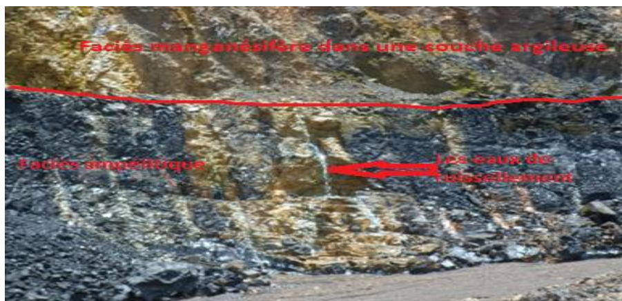
Figure 10: Les eaux de ruissellement de la zone B8 sud.
