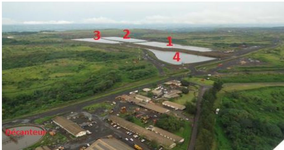
Figure 9 : Vue aérienne des bassins industriels
