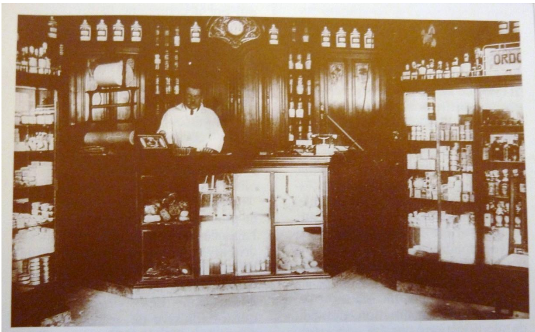
FIGURE 77 : INTERIEUR DE LA PHARMACIE DU POINT CENTRAL (102)
