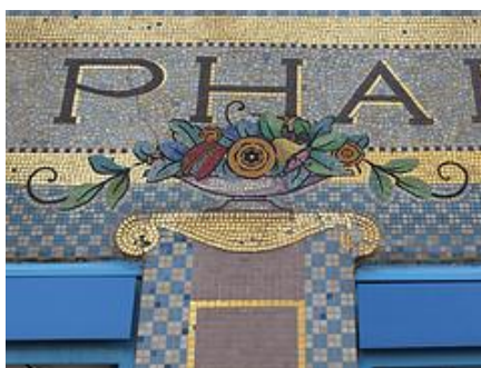
FIGURE 76 : DETAIL DE LA FAÇADE (106)
