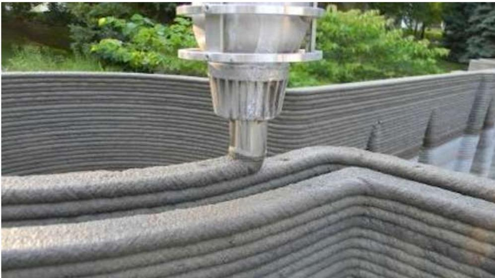
**Figure 156** : Impression 3D de maison en béton (Source : bekkeringadams)
