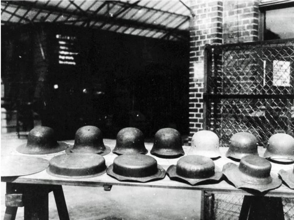
Figure n°51: Photographie des différentes étapes dans la fabrication du casque d'acier Photographie Musée archive de l'Imperial War Museums of London©(51).
