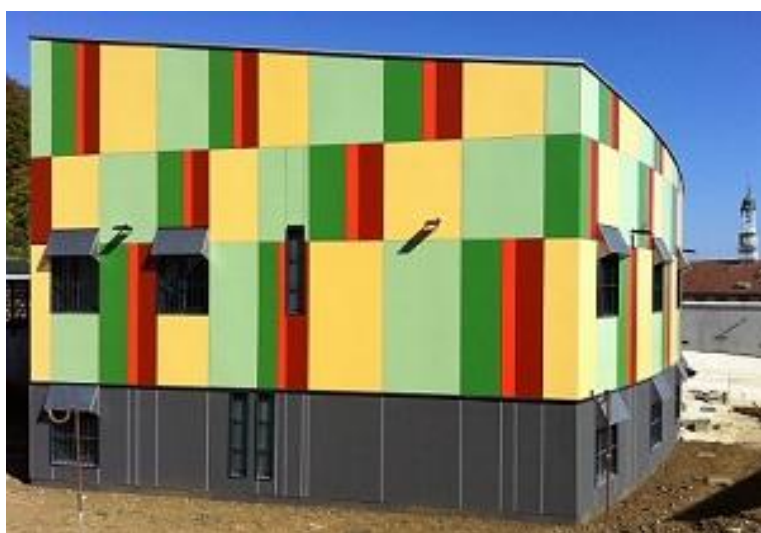
Annexe 13 : UHSA en construction.
