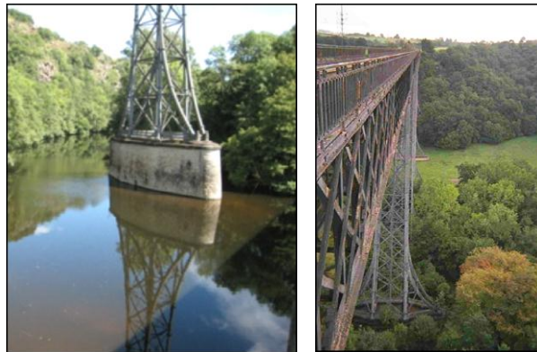
Illustration 6 : Pied de pile des viaducs de Rouzat et Neuvial
