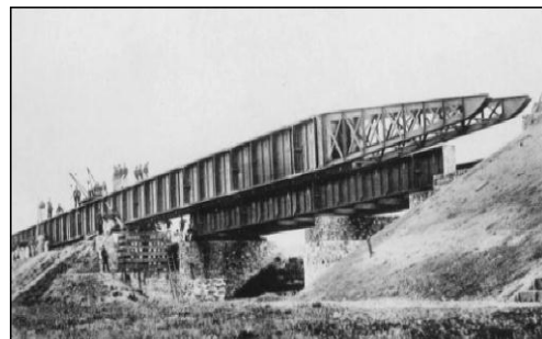
Illustration 16 : Ponts portatifs démontables
