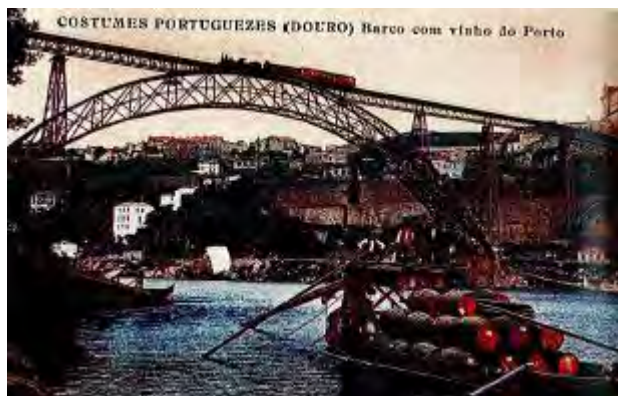
Figure 1 : Le viaduc de Maria Pia, franchissant le Douro
