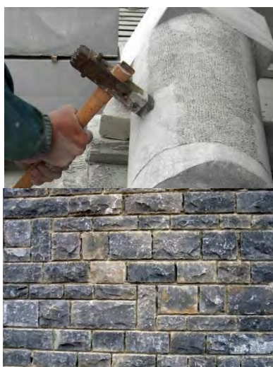
Figure 6 : Travail des moellons à la boucharde
